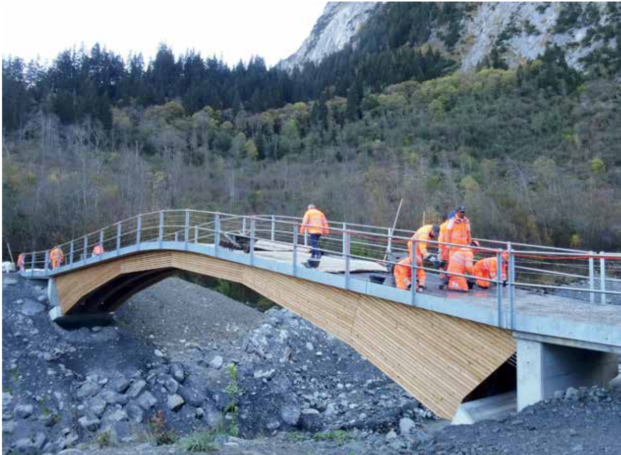
Bild 13 Gletschersandbrücke bei Grindelwald, Schweiz, eine Holz-UHF-Verbundbaubrücke
