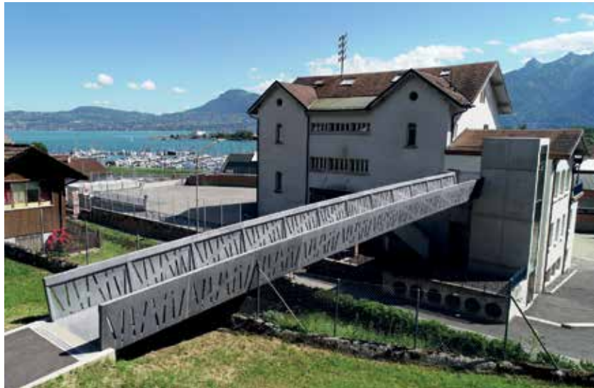
Bild 12 Stahl-UHFB Fußgängerbrücke in Le Bouveret: die Gestaltung des Brückenträgers wird durch die länglichen Aussparungen im Steg dominiert, die eine Transparenz und ein Lichtspiel bewirken. Die Stege des U-förmigen Trogquerschnitts sind leicht nach außen geneigt, um die Raumwirkung auf der Brücke zu verbessern.
