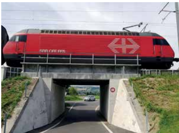
Bild 4 Straßenunterführung Unterwalden der Schweizer Bundesbahnen SBB (Juni 2018) Foto: E. Brühwiler
