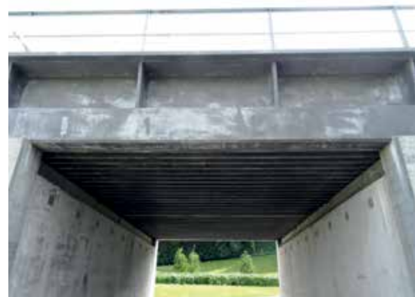
Bild 5 Randträger und Rippenplatte des Tragwerks aus bewehrtem UHFB Foto: E. Brühwiler
