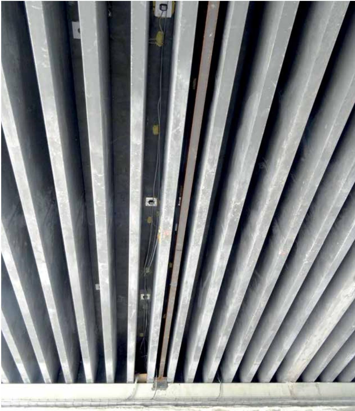
Bild 11 Struktur der UHFB-Rippenplatte mit Sensoren und eingelegtem Referenzbalken für die Durchbiegungsmessung Foto: E. Brühwiler
