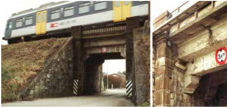
Bild 3 Straßenunterführung „Creux-du-Mas“ (1897), erste Bahnbrücke in der Schweiz aus Eisenbeton; links Ansicht und rechts Detailaufnahme Fotos: E. Brühwiler (1996)
