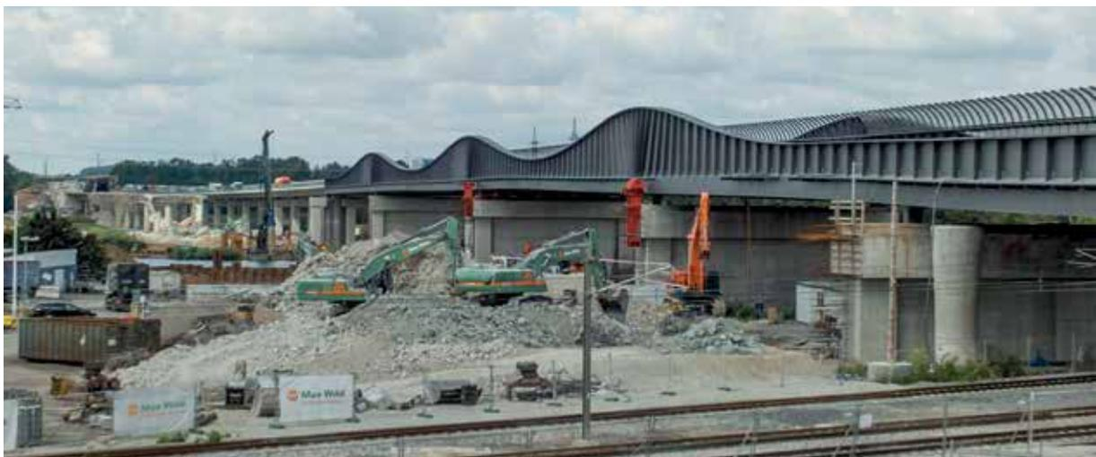
Bild 5: Neubau der Neckartalbrücke – vorläufige Seitenlage des Überbaus
