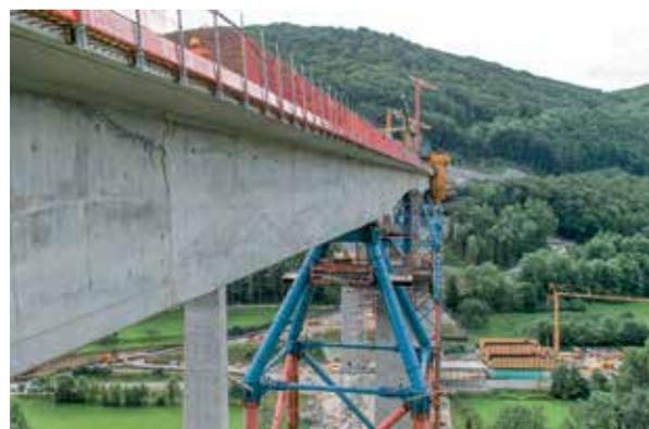
Bild 7: Oben liegende Vorschubrüstung (links) und Seitenansicht der Filstalbrücke (rechts)
