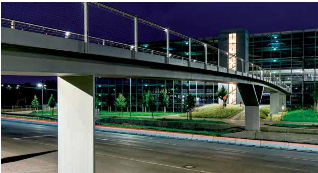
Bild 6 Steg Sindelfingen – massive Stahlscheiben als Stützelemente
