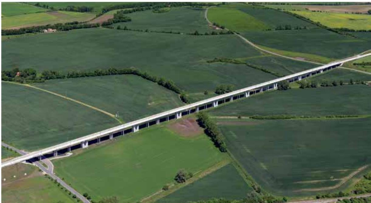
Bild 24 Gänsebachtalbrücke DB – integrale Segmente mit Bremsböcken © Hajo Dietz, Nürnberg Luftbild
