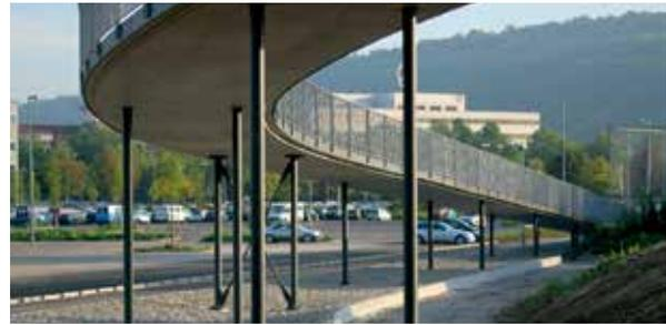
Bild 2 Steg Mettingen – aufgeständerte Rampen © sbp/Andreas Keil
