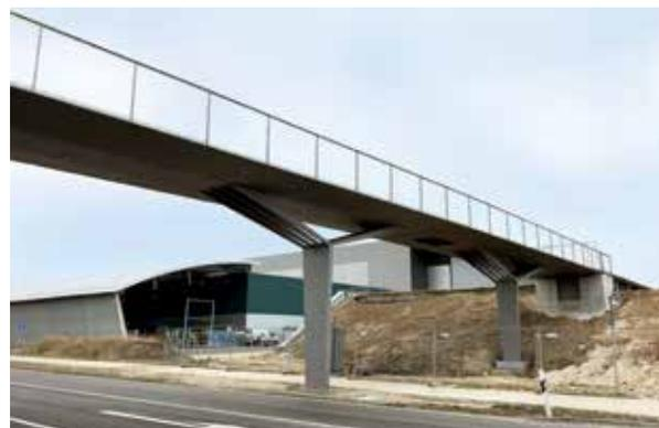
Bild 10 Steg Landesgartenschau Ingolstadt – Y-Stützen tragen schlanken Überbau
