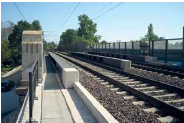
Bild 7 EÜ Lange-Feld-Straße, Blick auf die Hauptträger von oben © Marx Krontal Partner
