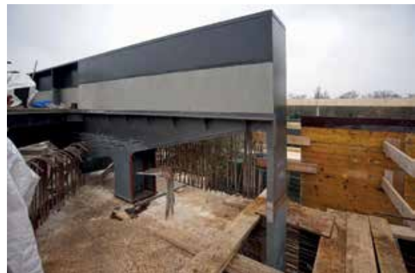
Bild 8 EÜ Lange-Feld-Straße, Rahmenecke mit Zugband © Marx Krontal Partner
