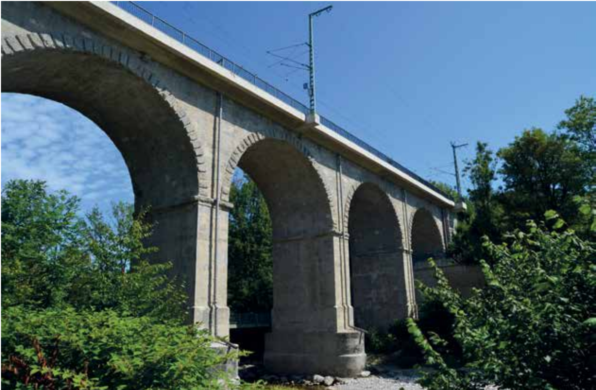
Bild 4 Sanierte Gewölbebrücke in Traunstein mit Fahrbahnwanne
