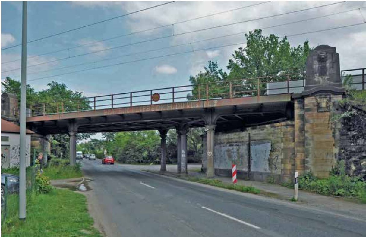
Bild 5 EÜ Lange-Feld-Straße, Zustand vor dem Umbau
