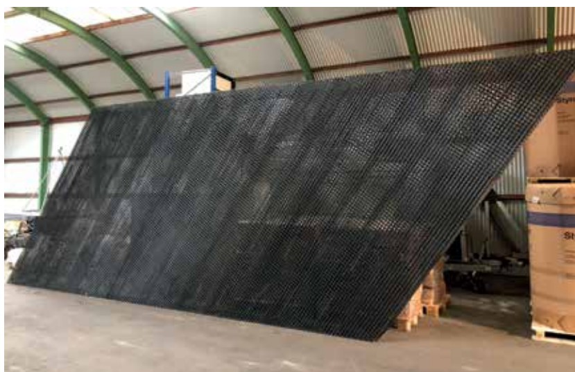
Bild 16 Fertiggestellter Bewehrungskorb
