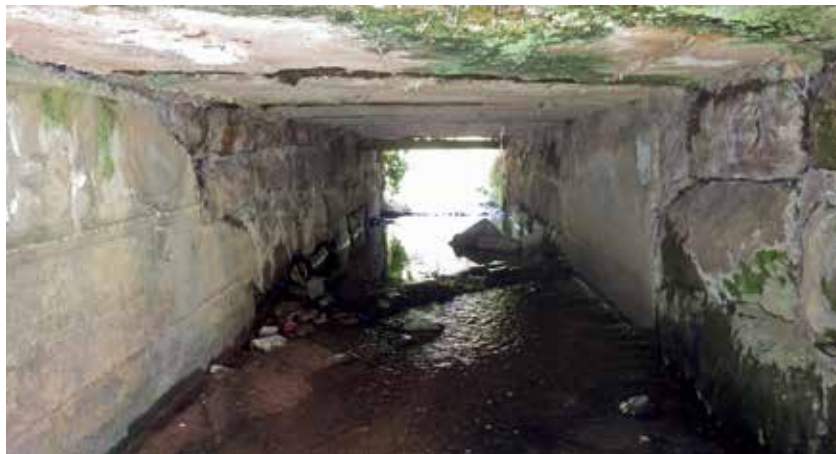
Bild 3 Ansicht der Unterseite einer der Brücken in Gaggenau
