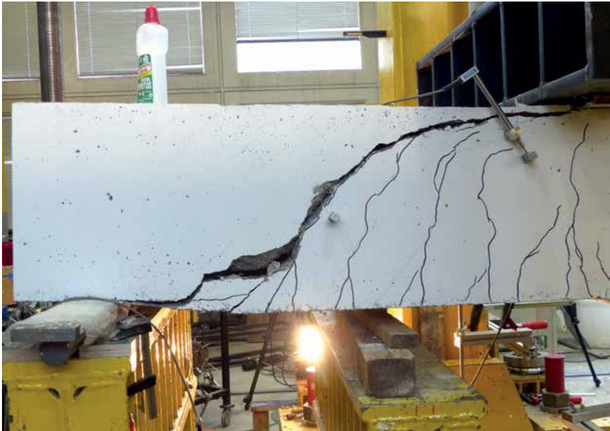
Bild 13 Versuchskörper im Bruchzustand
