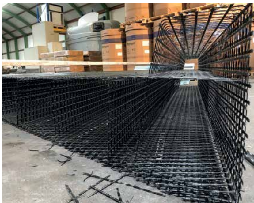
Bild 15 Bewehrungskorb während des Zusammenbaus
