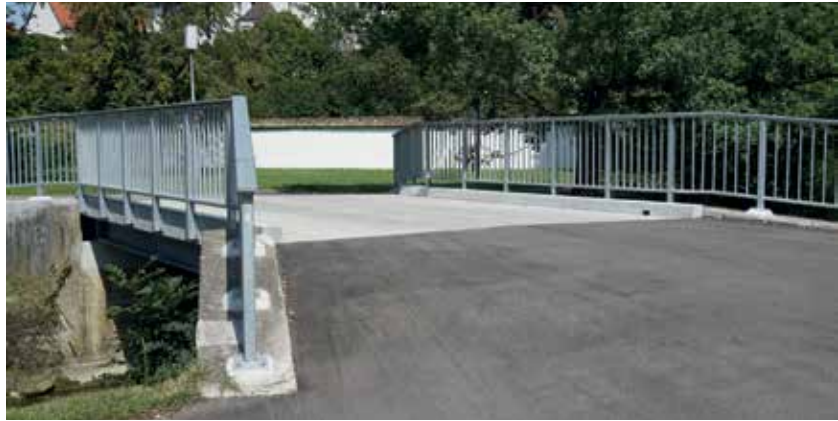
Bild 1: Ansicht der Carbonbetonbrücke in Margrethausen
