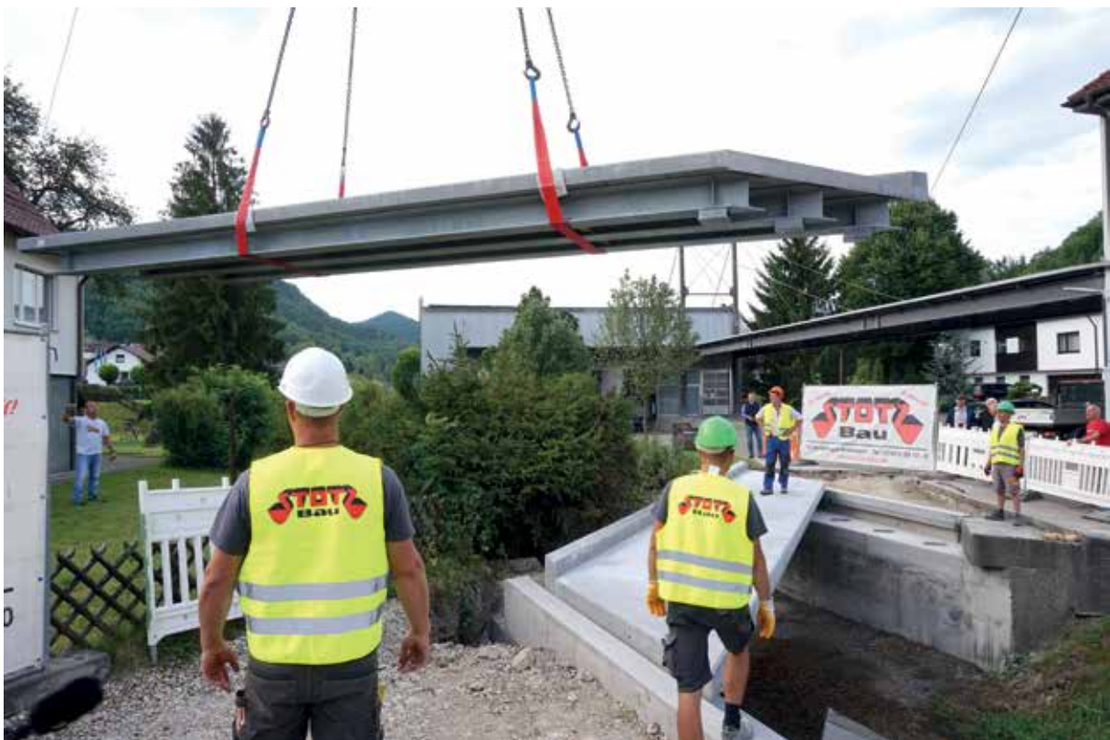
Bild 17 Montage der Brücke in Pfeffingen
