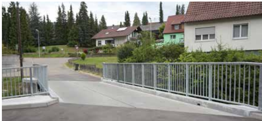
Bild 2: Ansicht der Carbonbetonbrücke in Pfeffingen
