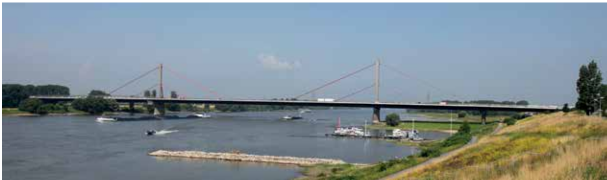
Bild 1 A1, Rheinbrücke Leverkusen, Bestandsbauwerk
