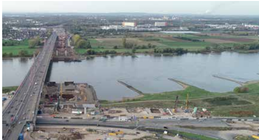
Bild 9 Bauausführung Rheinbrücke, Oktober 2019
