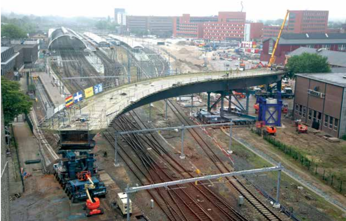
Bild 15 Einfahren beim Übergang von Phase 1 zu Phase 2 (die Mittelstütze wird ausgefahren)
