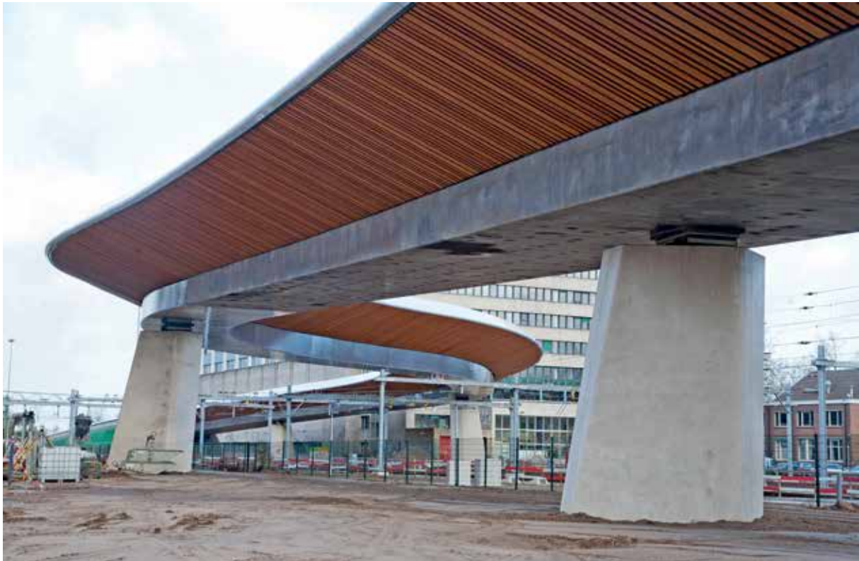
Bild 2 Untersicht der Brückenmitte aus Richtung Süden
