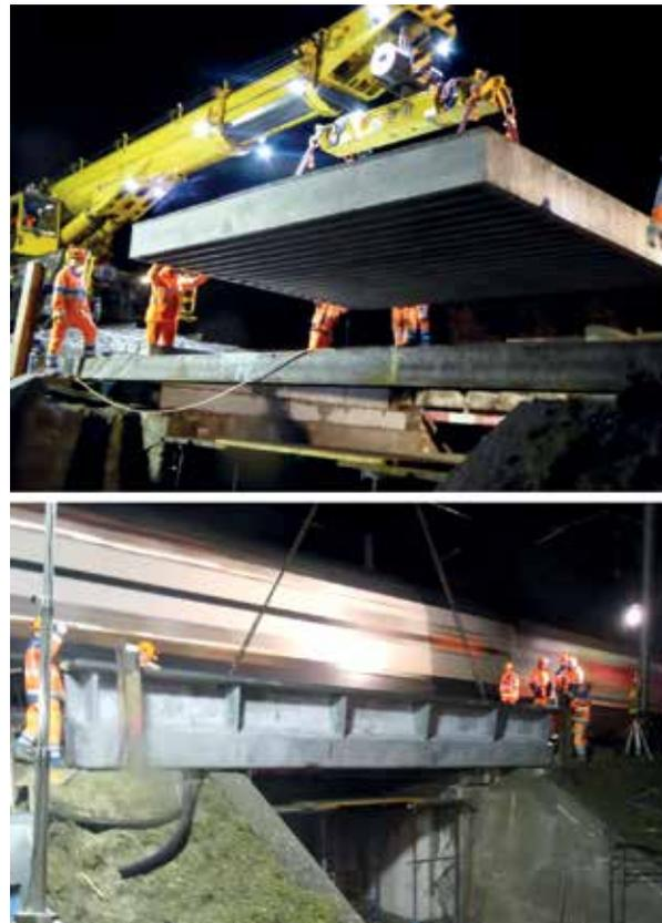
Bild 10 Versetzen der vorgefertigten UHFB-Rippenplatte und des Randträgers (bei Zugdurchfahrt auf dem benachbarten Gleis) auf die Widerlager
