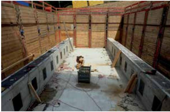
Bild 12 Verschubbahnen für Querverschub
