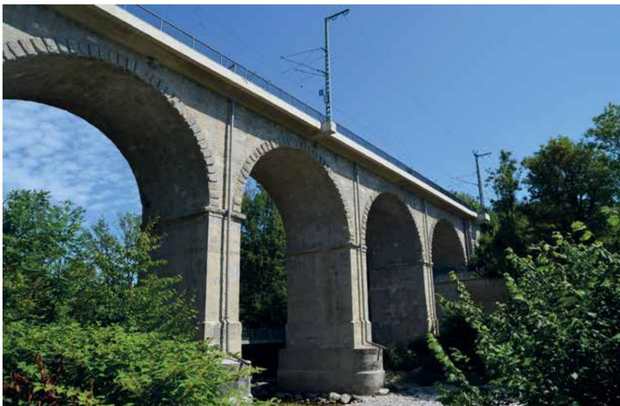
Bild 4 Sanierte Gewölbebrücke in Traunstein mit Fahrbahnwanne
