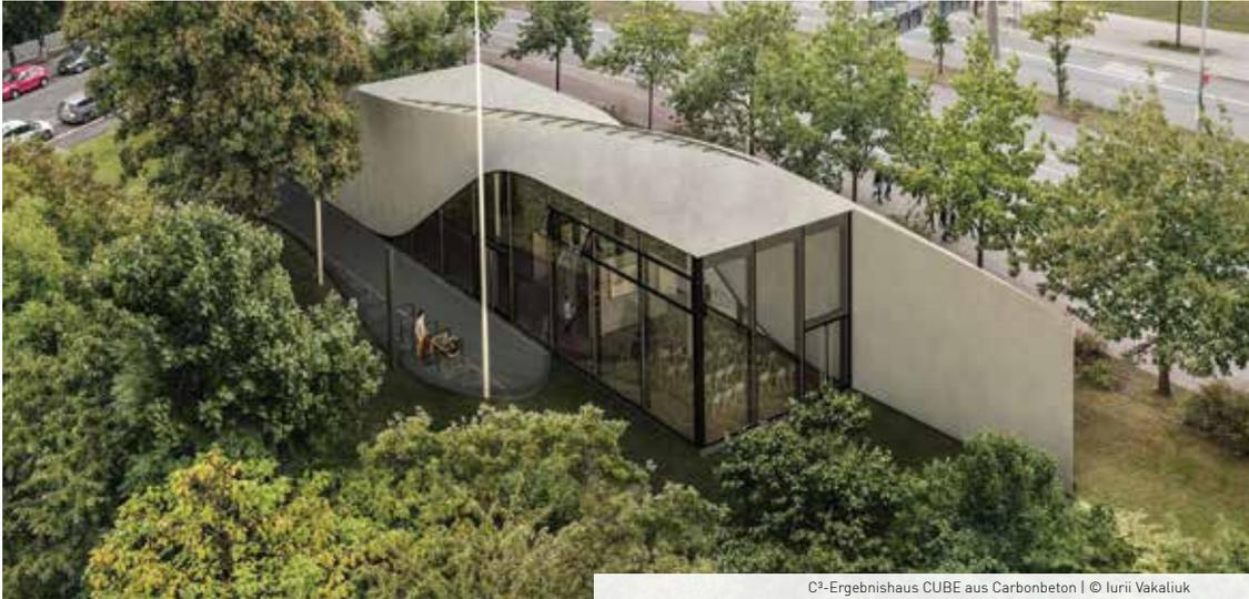
C<sup>3</sup>-Ergebnishaus CUBE aus Carbonbeton | © Iurii Vakaliuk
