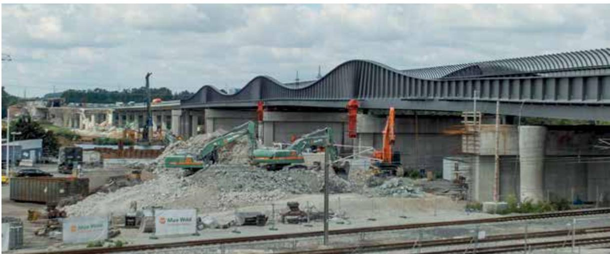
Bild 5: Neubau der Neckartalbrücke – vorläufige Seitenlage des Überbaus
