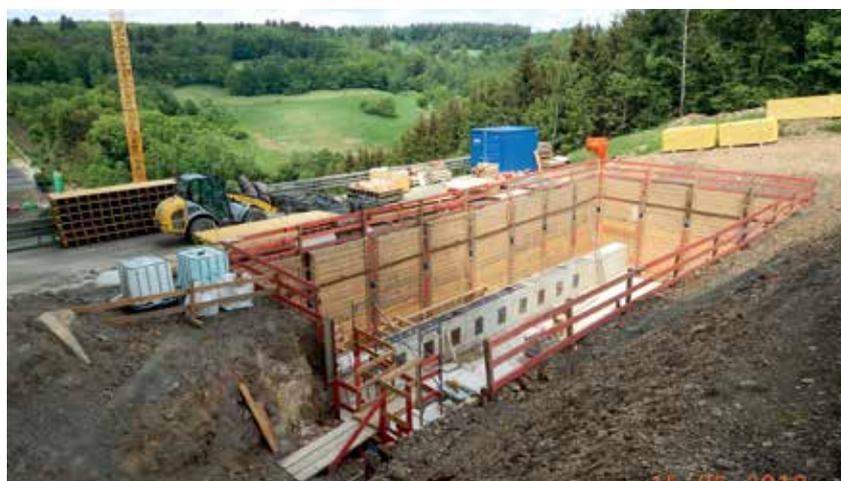
Bild 11 Baugrube der Verschubbahn
