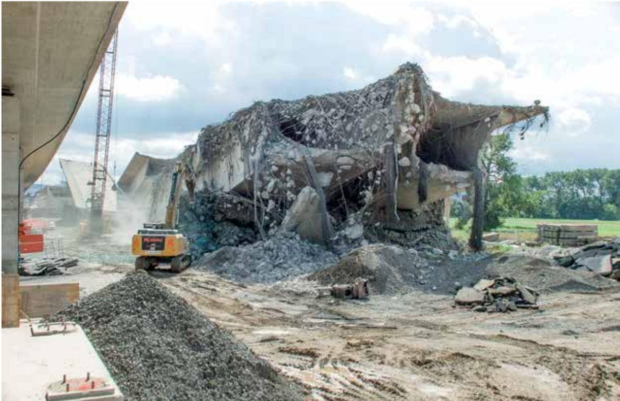
Bild 4: Rückbau der sogenannten Durchstichbrücke über den Neckar aus den 1960er Jahren
