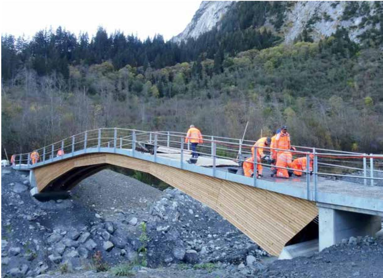
Bild 13 Gletschersandbrücke bei Grindelwald, Schweiz, eine Holz-UHF-Verbundbaubrücke
