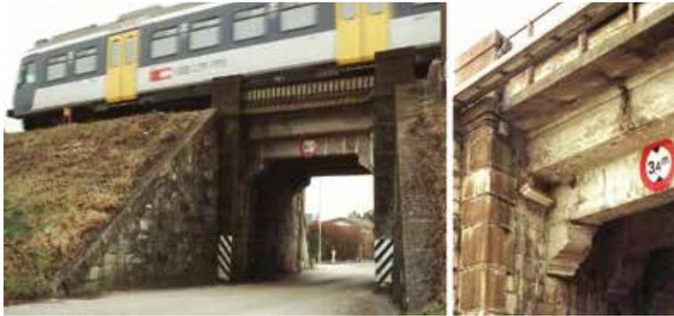
Bild 3 Straßenerunterführung „Creux-du-Mas“ (1897), erste Bahnbrücke in der Schweiz aus Eisenbeton; links Ansicht und rechts Detailaufnahme Fotos: E. Brühwiler (1996)
