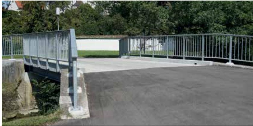
Bild 1: Ansicht der Carbonbetonbrücke in Margrethausen
