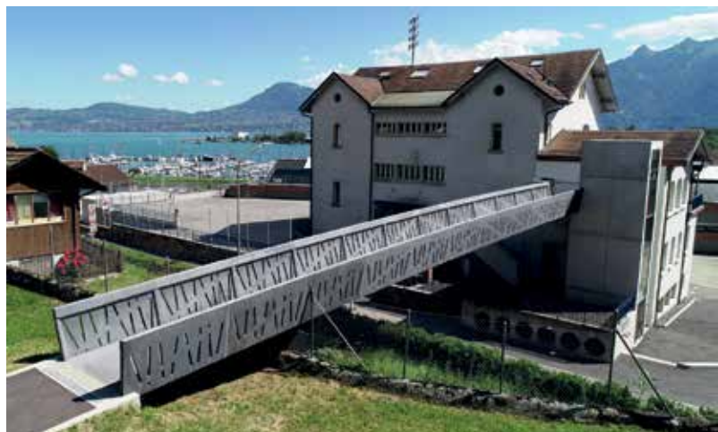
Bild 3 Stahl-UHFB-Fußgängerbrücke in Le Bouveret (2018): die Gestaltung des Brückenträgers wird durch die länglichen Aussparungen im Steg dominiert, die eine Transparenz und ein Lichtspiel bewirken Foto: Sollertia SA
