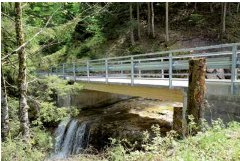
Bild 6 Fruttlibrücke in UHFB-Holz-Verbundbauweise (2020) Foto: E. Kälin
