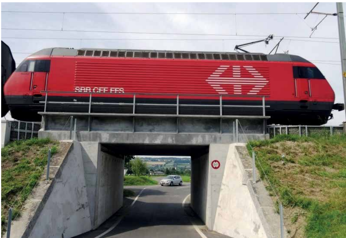
Bild 1 Straßenunterführung Unterwalden der Schweizer Bundesbahnen SBB Foto: E. Brühwiler (2018)
