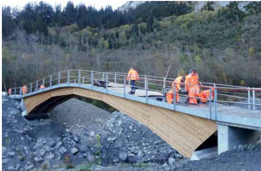
Bild 5 Gletschersandbrücke bei Grindelwald, Schweiz – eine Holz-UHFB-Verbundbaubrücke (2018); das Foto zeigt die Arbeiten der Splittkieseinstreuung Foto: E. Brühwiler
