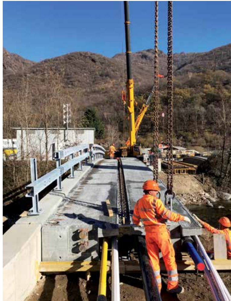
Bild 7 Stahl-UHFB-Straßenbrücke: Aufnahme der Montage des Zweiten von vier Fertigteilträgern Foto: L. Boiron
