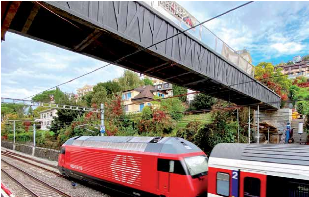
Bild 4 Stahl-UHFB Fußgängerbrücke „Chaumény“ in Montreux (2020) mit Steggestaltung, nach Montage mit einem Pneukran in der Nacht vom 10. auf den 11. Oktober 2020 Foto: E. Brühwiler
