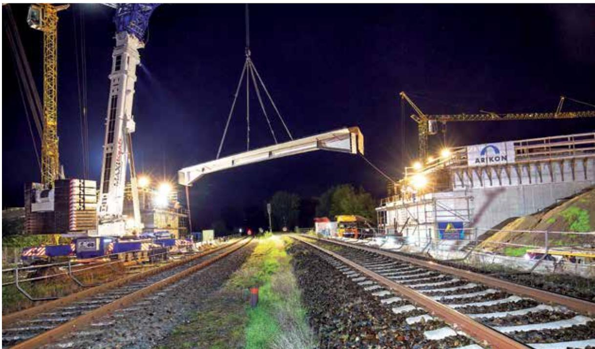
Einheben eines Verbund-Fertigteil-Trägers (VFT)
