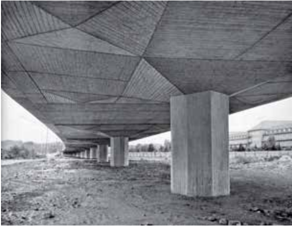
Bild 12 Die 440 m lange Weidetorbrücke in Hannover ist eines der schönsten Beispiele der pilzartigen Hochstraßen von Dywidag aus den 1960er Jahren.
