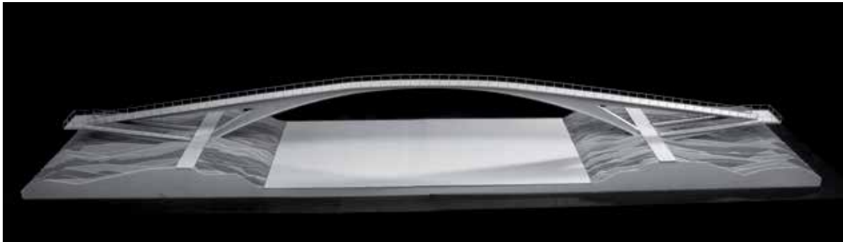
Bild 13 Eine der Besonderheiten der Dyckerhoff-Brücke Schierstein (1964) sind die beidseitigen, weit auskragenden Rampen. Modell und Modellfoto: Privatarhiv Oliver Fritz
