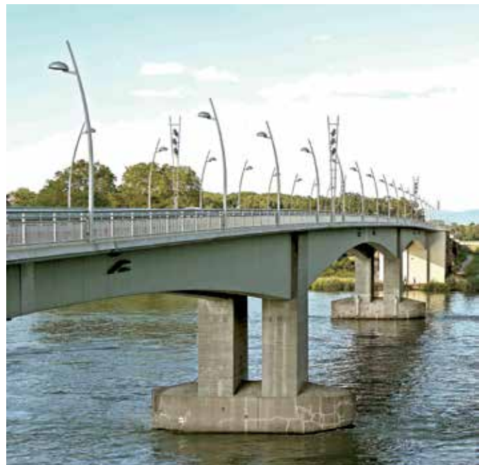
Bild 8 Der zu enge Abstand der neuen Leuchten mit ihrer peitschenförmigen Form beeinträchtigt das Erscheinungsbild der Nibelungenbrücke ganz erheblich, vgl. Bild 6
