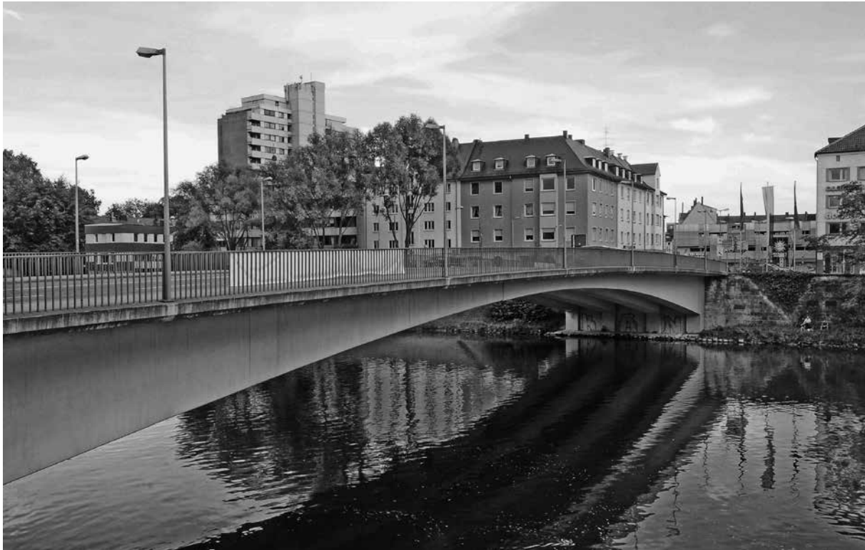
Bild 4 Die 1950 fertiggestellte Gänstorbrücke in Ulm soll 2024 abgebrochen und durch einen Neubau ersetzt werden.
