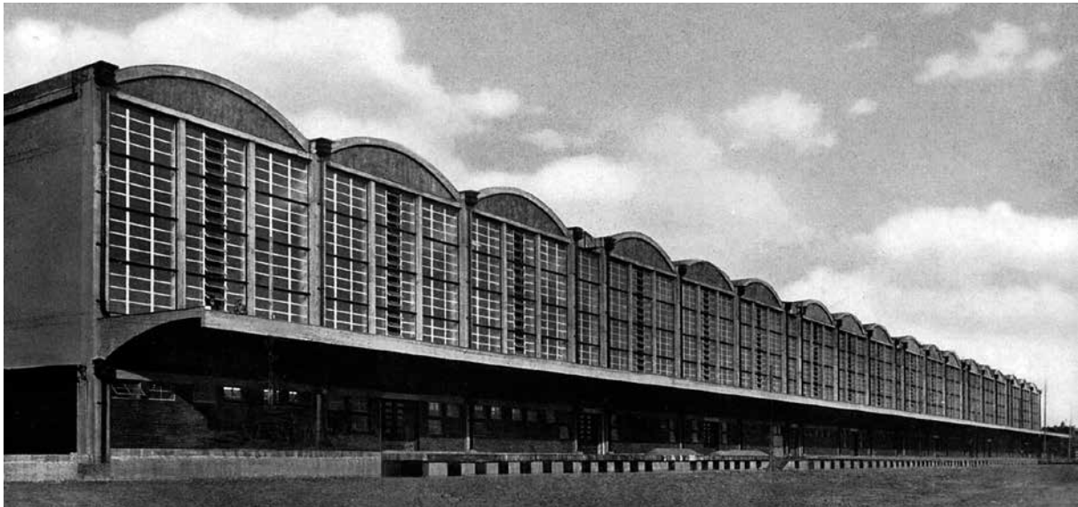
Bild 23 Mit Zeiss-Dywidag-Schalen 1931 in Budapest fertiggestellte Markthalle verfällt zurzeit von Jahr zu Jahr, weil für sie keine geeignete Nutzung und kein Betreiber gefunden werden kann.
