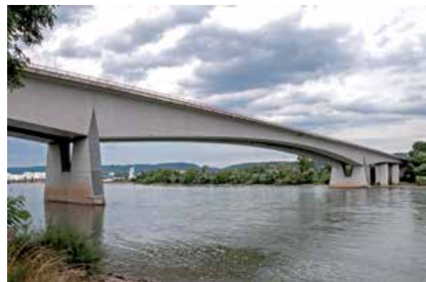
Bild 11 Die elegante Rheinbrücke Bendorf steht auch bereits auf der Abrissliste. In 10 bis 15 Jahren wird es soweit sein.
