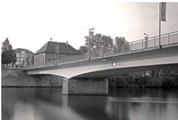
Bild 10 Es ist geplant, auch die Mainbrücke in Schweinfurt ab 2027 durch einen Neubau zu ersetzen. Foto: Dicleli (2018)
