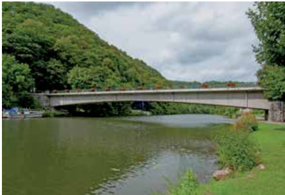
Bild 9 Lahnbrücke Balduinstein – die erste Spannbetonbrücke der Welt, die 1951 im Freivorbau errichtet wurde – wird bald abgerissen und durch einen Neubau ersetzt. Foto: Dicleli (2008)
