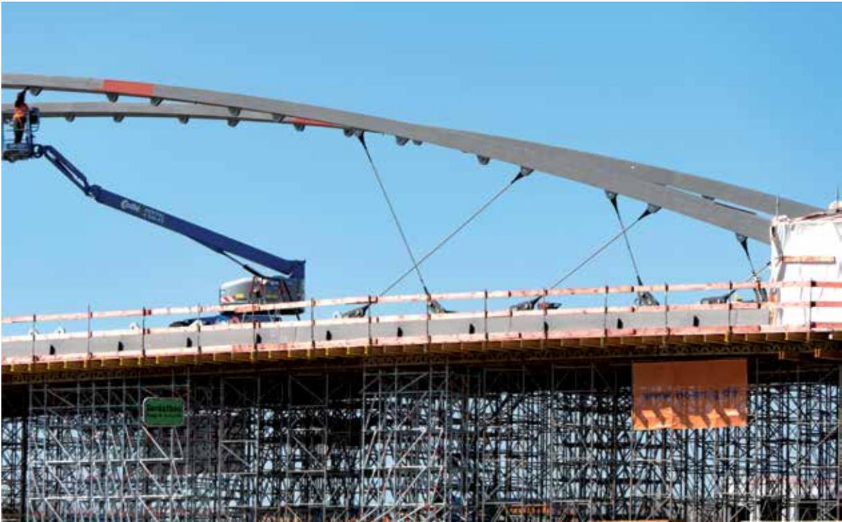
Bild 16 Montage der Hängerseile aus Carbon
