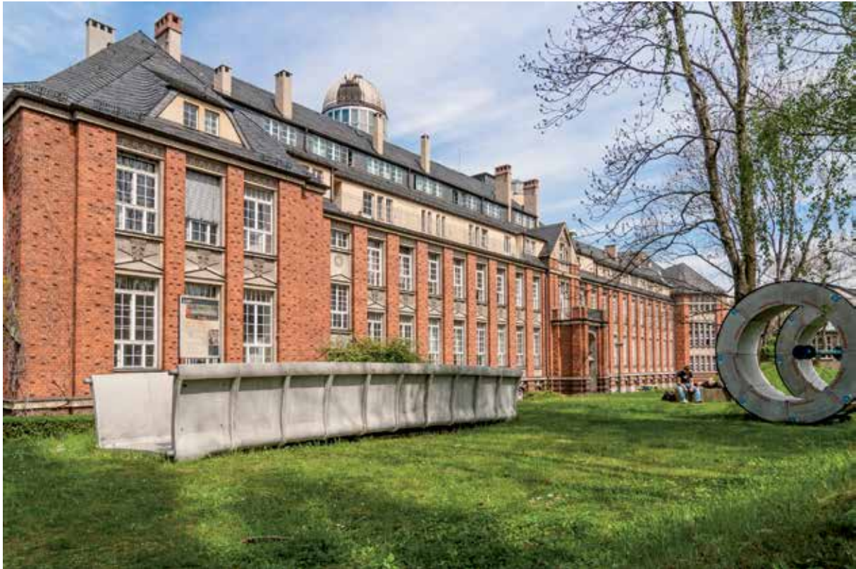
Bild 3 Wiese hinter dem Beyer-Bau mit Prototyp der ersten Brücke aus Textilbeton und dem Textilbeton-Rad DREHSDEN (2008) Foto: Ulrich van Stipriaan
