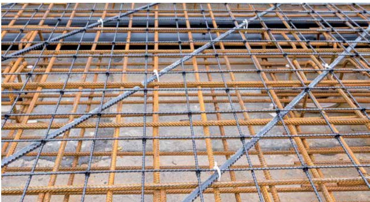
Bild 14 Verlegte Carbonbewehrung – solidian REMAT
