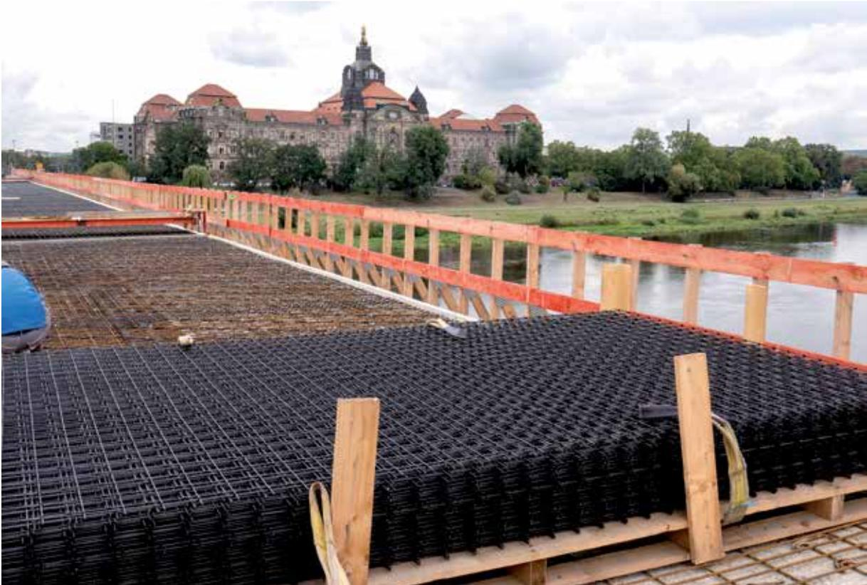
Bild 12 solidian REMAT fertig zum Einbau
