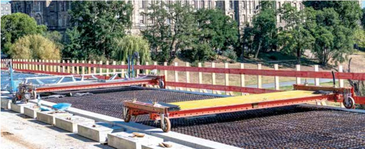
Bild 15 Betonierplattformen und Rüttelbohle
