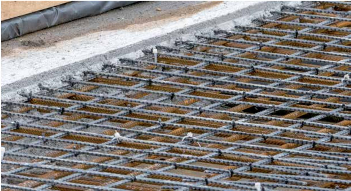
Bild 13 Verlegte Basaltbewehrung – Basalt T4
