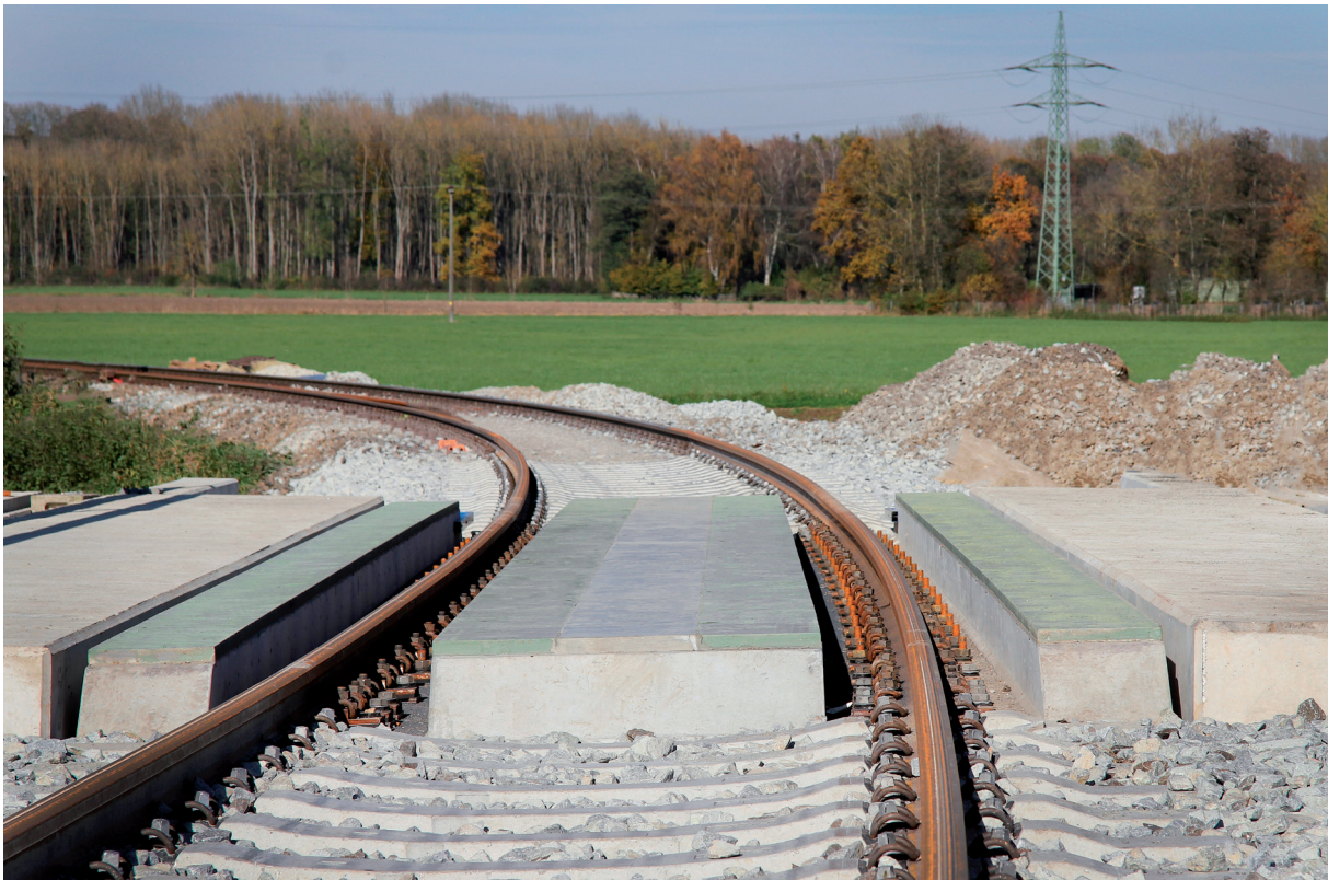
Bild 6 Fertiggestellte VFT-Rail-Brücke bei Langenbach/Obb. mit einem Gleisradius von 300 m © SSF Ingenieure AG
