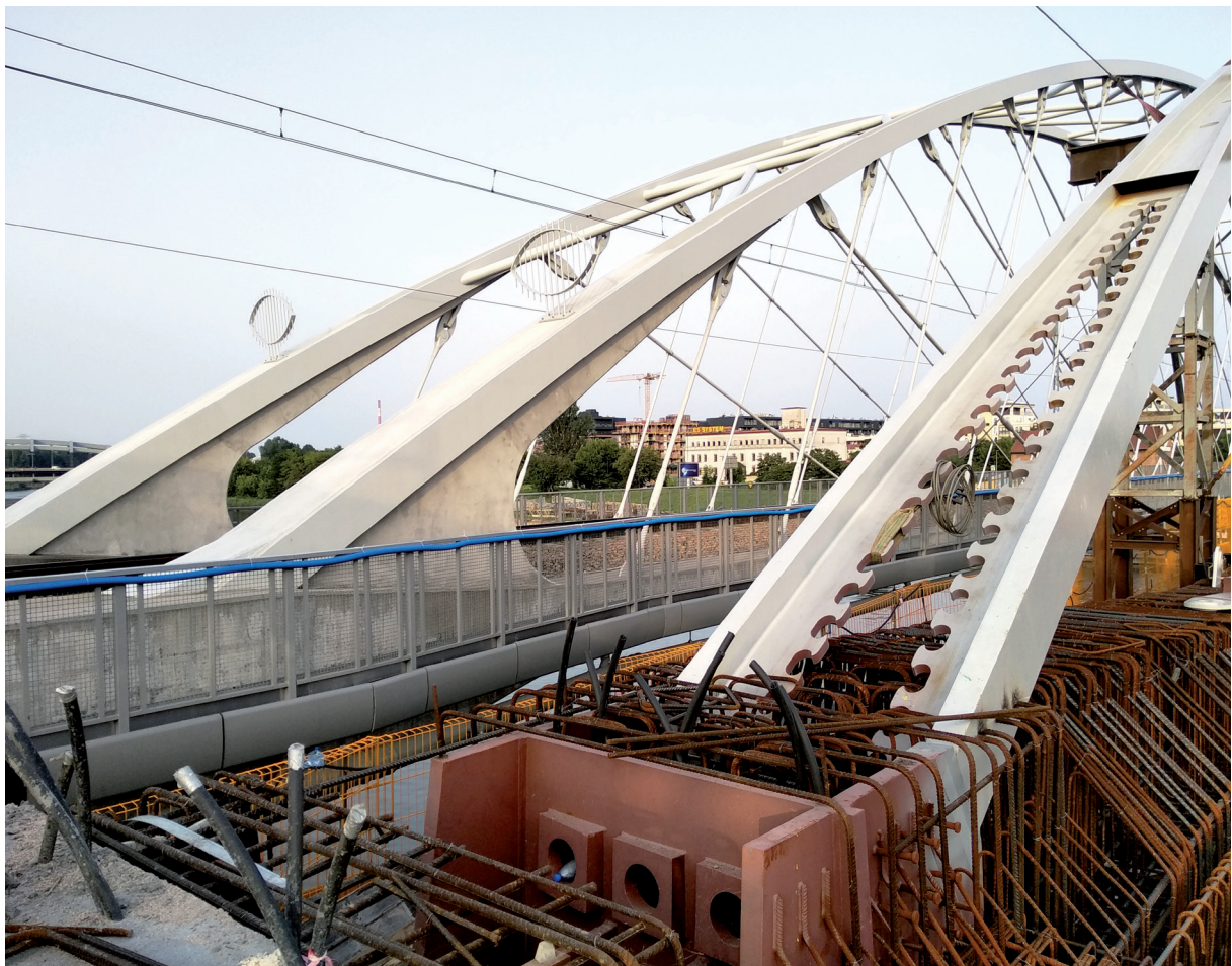
Bild 10 Fußpunkte der Netzkorbbrücken
