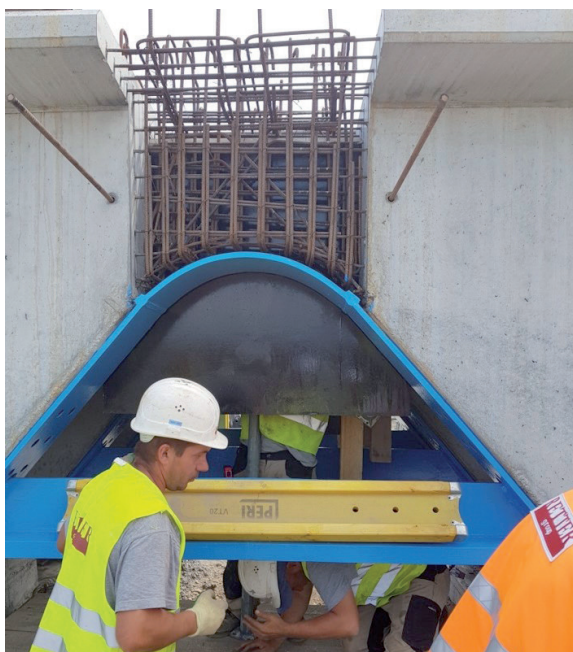
Bild 14 Vorbereiteter Trägerstoß © Victor Schmitt
