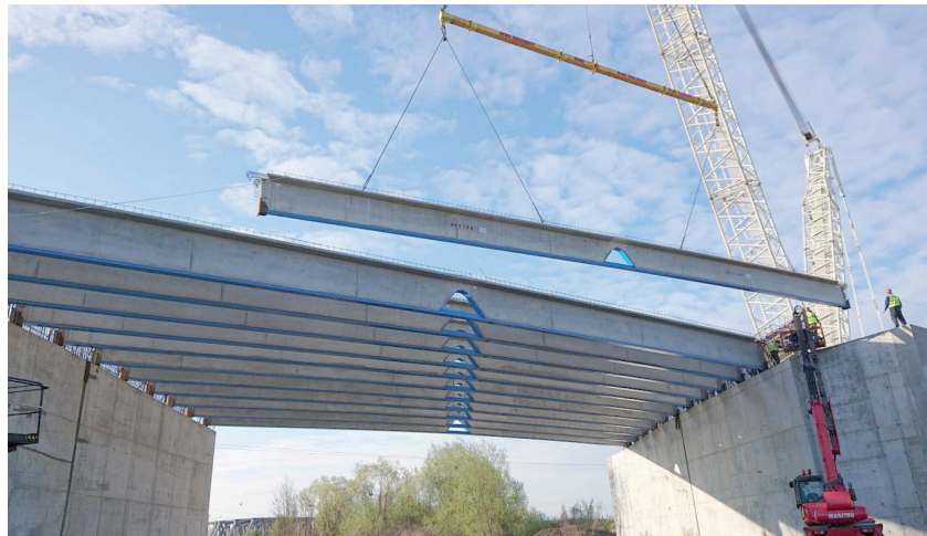
Bild 15 Verlegte Träger (A-Bauwerk)
