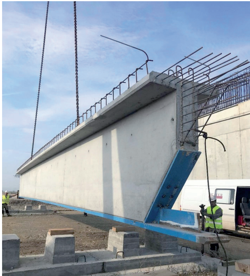
Bild 13 Trägerhälfte des Verbundfertigteils auf der Baustelle
