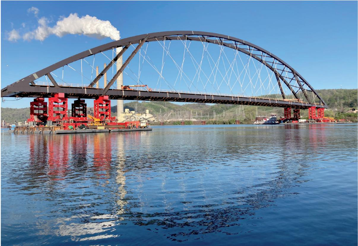
Bild 12 Montagezustand eines Netzwerkbogens mit Bogenaussteifung im Bereich der temporären Auflager
