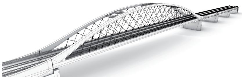
Bild 5 Tragwerk der Oderbrücke Küstrin, Netzwerkbogen mit monolithisch angeschlossenen Seitenfeldern © schlaich bergemann partner
