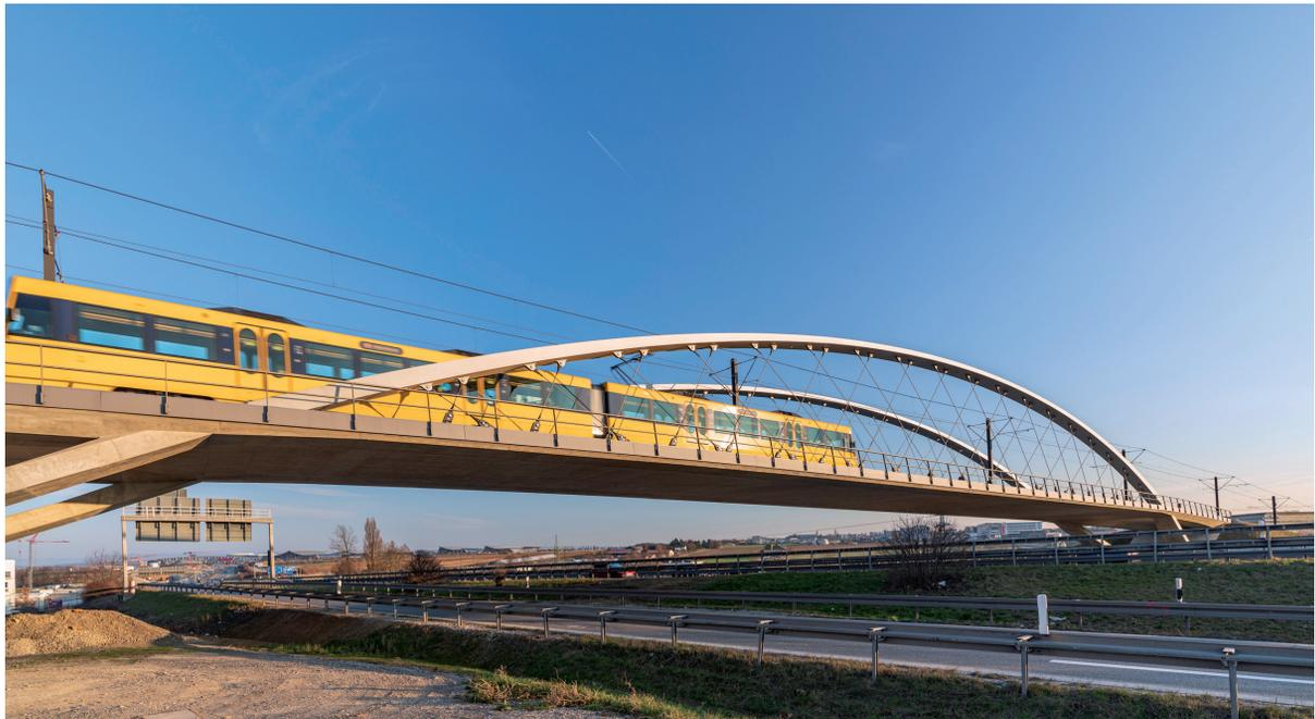
Bild 3 Stadtbahnbrücke – Netzwerkbogen mit Hängern aus Carbon, Inbetriebnahme 2021
