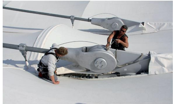
Bild 6 Bolzenverbindungen für Carbon-Zugglieder; links: Bolzenverbindung an einem oberen Radialseil im Dachtragwerk des Nationalstadions Warschau, rechts: Haftreibungsmoment an der Bolzenverbindung eines vollverschlossenen Seils VVS85
