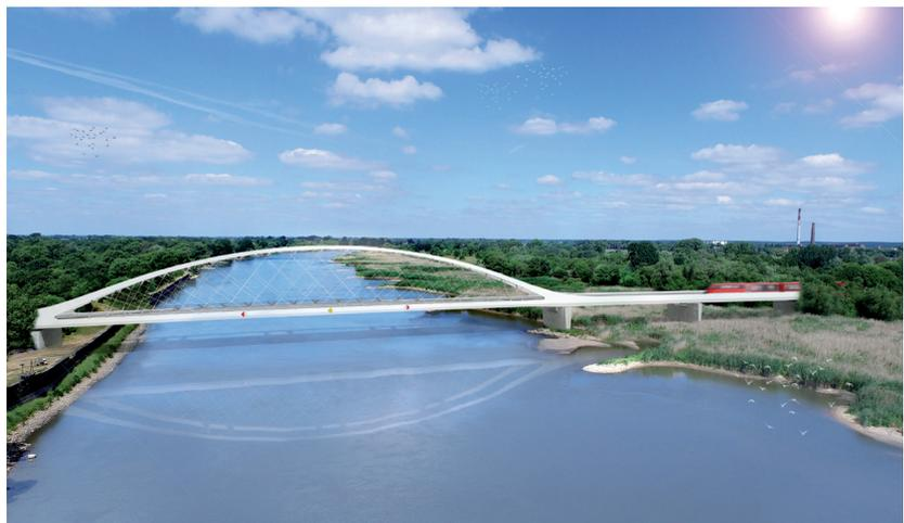
Bild 4 Oderbrücke Küstrin, gestalterischer Entwurf Schüßler-Plan Generalplanungsgesellschaft/Knight Architects; hier dargestellt: technische Alternativlösung mit Hängern aus Carbon nach dem Konzept von sbp © schlaich bergemann partner
