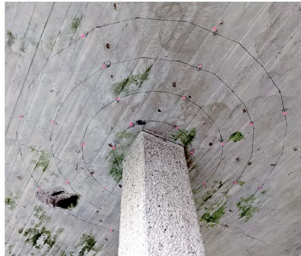
Bild 12 Angezeigte Einbaupunkte der Durchstanzverstärkung um die Stützen nach vorangegangener Bewehrungsdetektion mittels zerstörungsfreier Prüfverfahren
