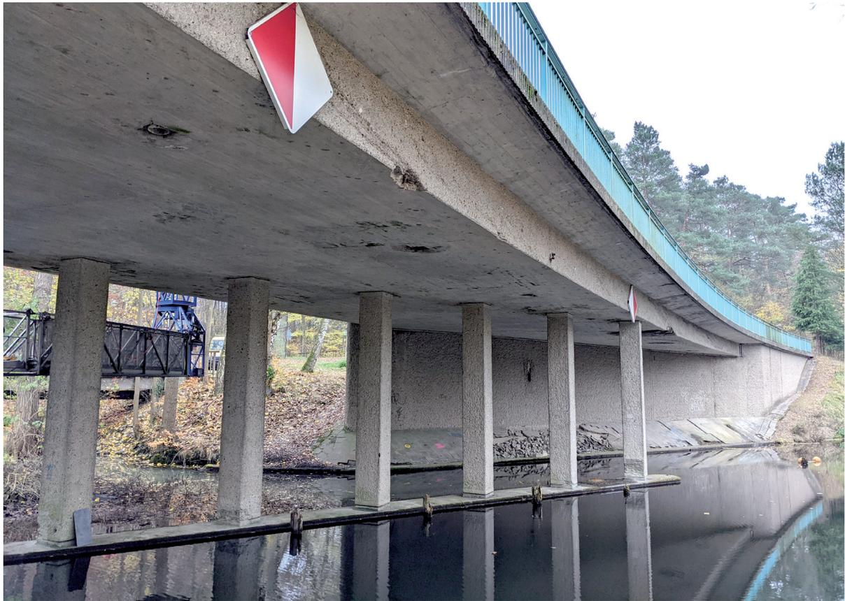
Bild 11 Plattenbrücke über drei Felder mit punktgestützten Zwischenauflagern
