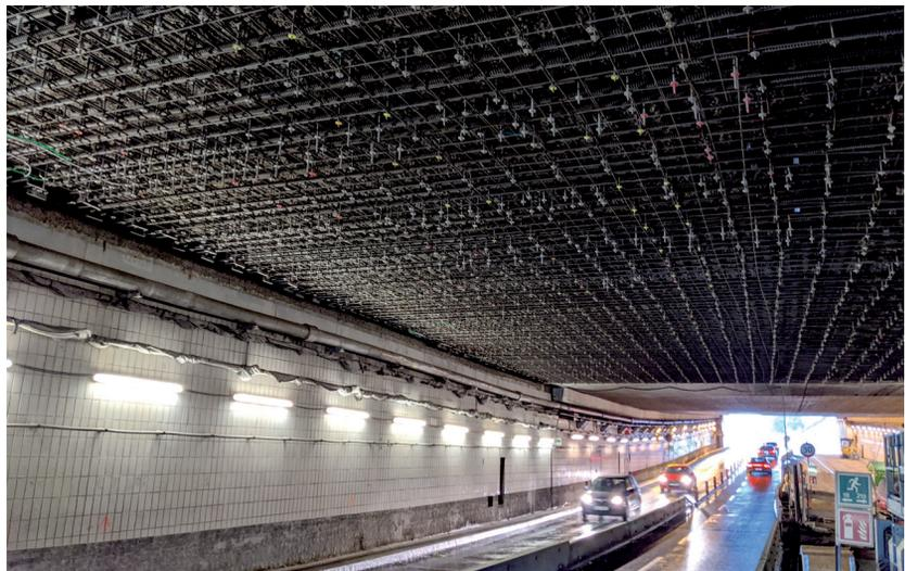
Bild 14 Installation der nachträglichen Querkraftverstärkung und der Biegezugbewehrung im Tunnel unter Aufrechterhaltung des Verkehrs in umgelegten Fahrspuren
