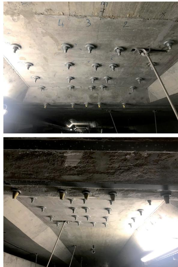
Bild 10 Eingebaute Querkraftverstärkung im Obergurt des Hohlkastens
