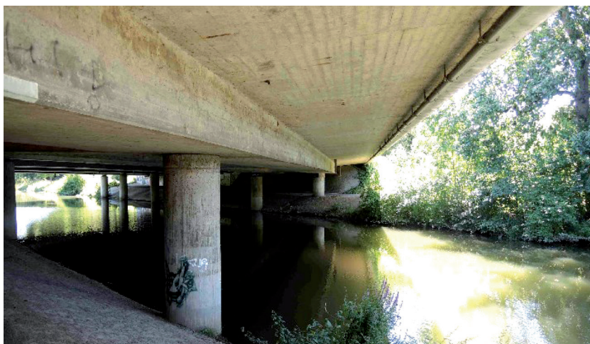
Bild 10 Untersicht Teilbauwerk 3 – Brückenzug über die Nidda
