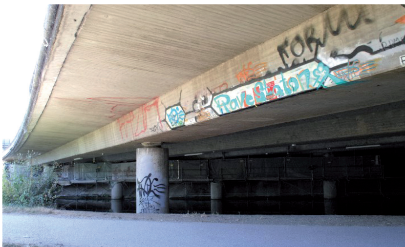
Bild 8 Untersicht auf den Überbau des südlichen Teilbauwerks 1,
