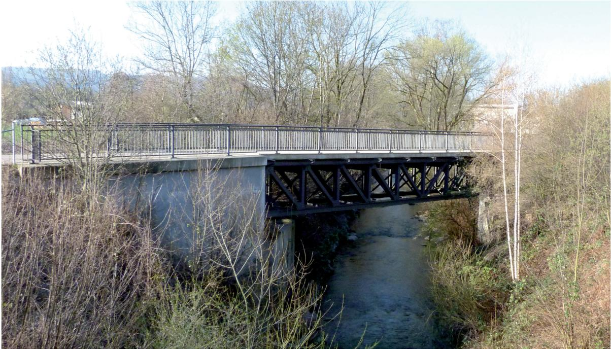
Bild 6 EÜ bei Süßen als Radwegbrücke (1901, Spannweite 21,6 m)
