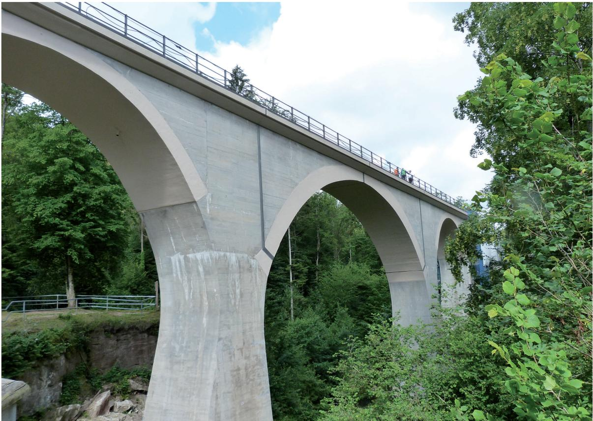
Bild 12 Eisenbahnbrücke Laufenmühle-Viadukt (1909, max. Spannweite 28 m)
