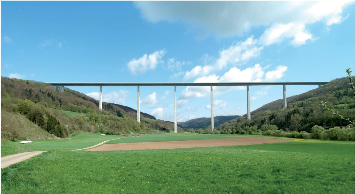
Bild 5 Kochertalbrücke (1979, längste Spannweite 138 m)
