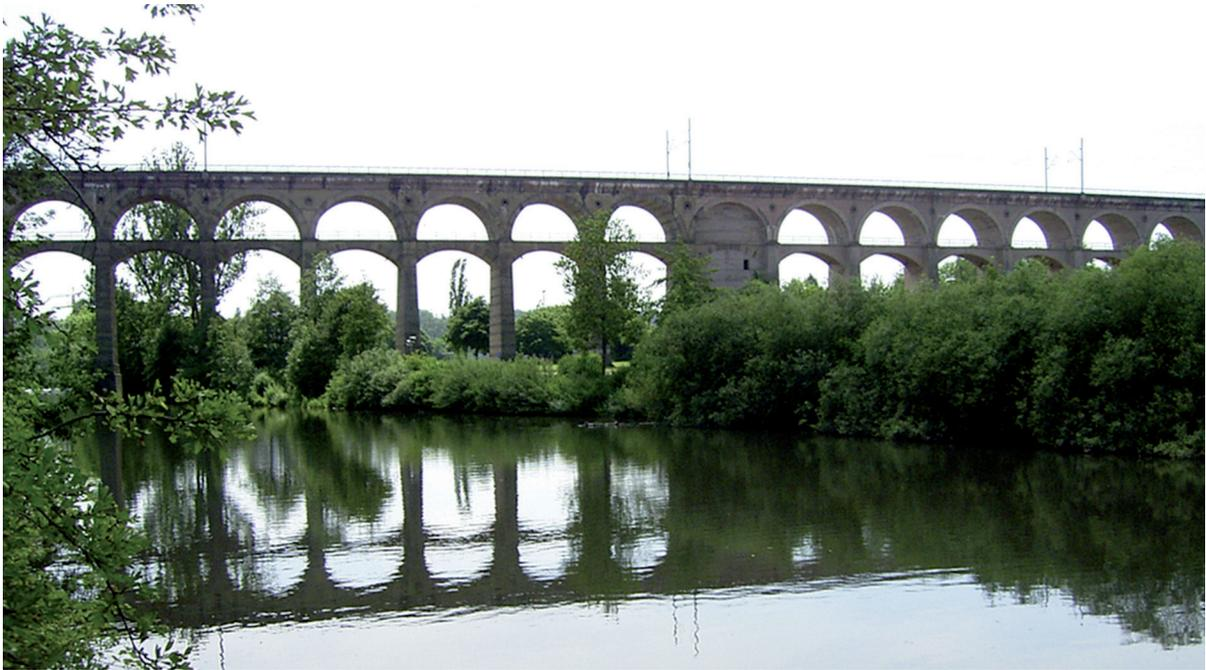
Bild 2 Enztalviadukt der Eisenbahn bei Bietigheim (1853, Spannweite  $21 \times 11,20$  m)
