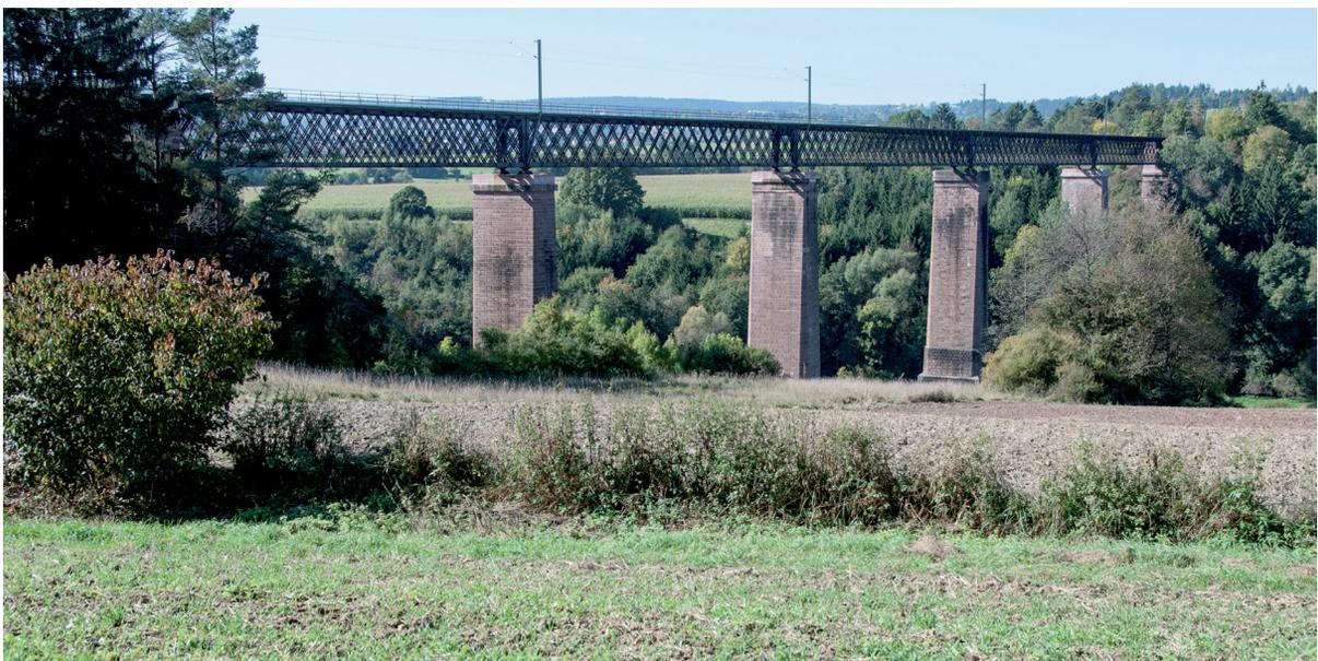
Bild 3 Kübelbachviadukt der Eisenbahn bei Dornstetten (1879, Spannweite u. a.  $3 \times 60$  m)
