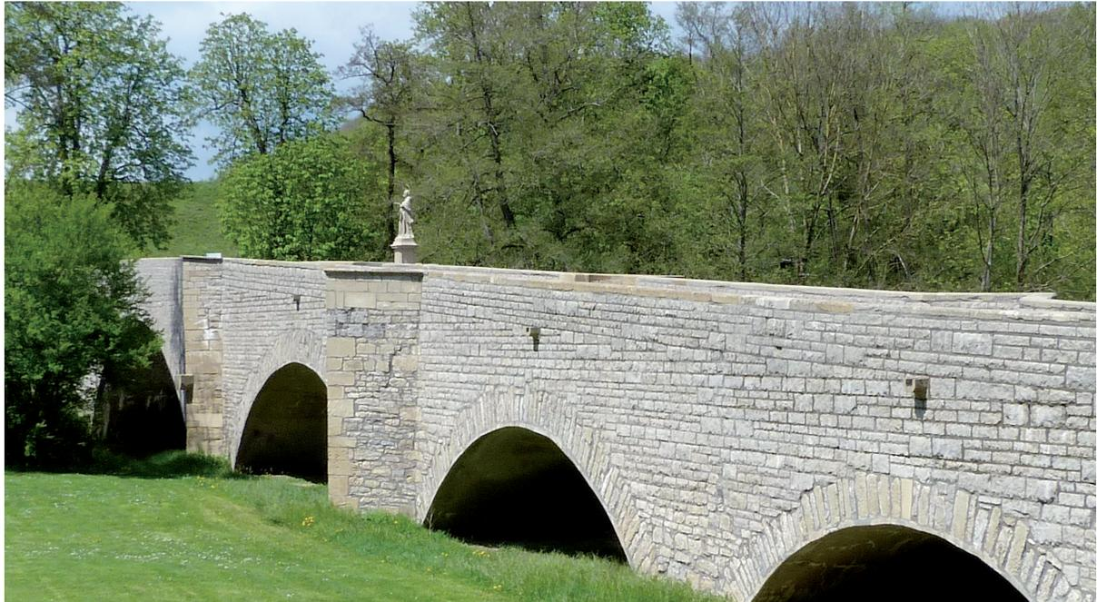
Bild 8 Jagstbrücke noch ohne Geländer (1609, größte Spannweite heute etwa 25 m)
