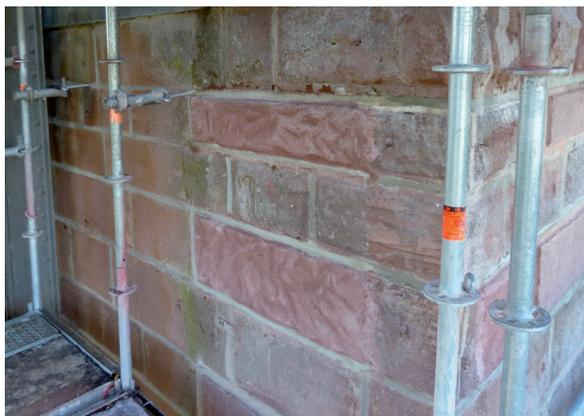
Bild 7 Kübelbachviadukt, Detail Natursteinpfeiler mit Betonergänzungen
