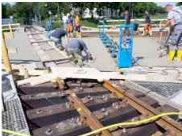
Bild 8 Betonage der Fahrbahnplatte am Schienentrog
