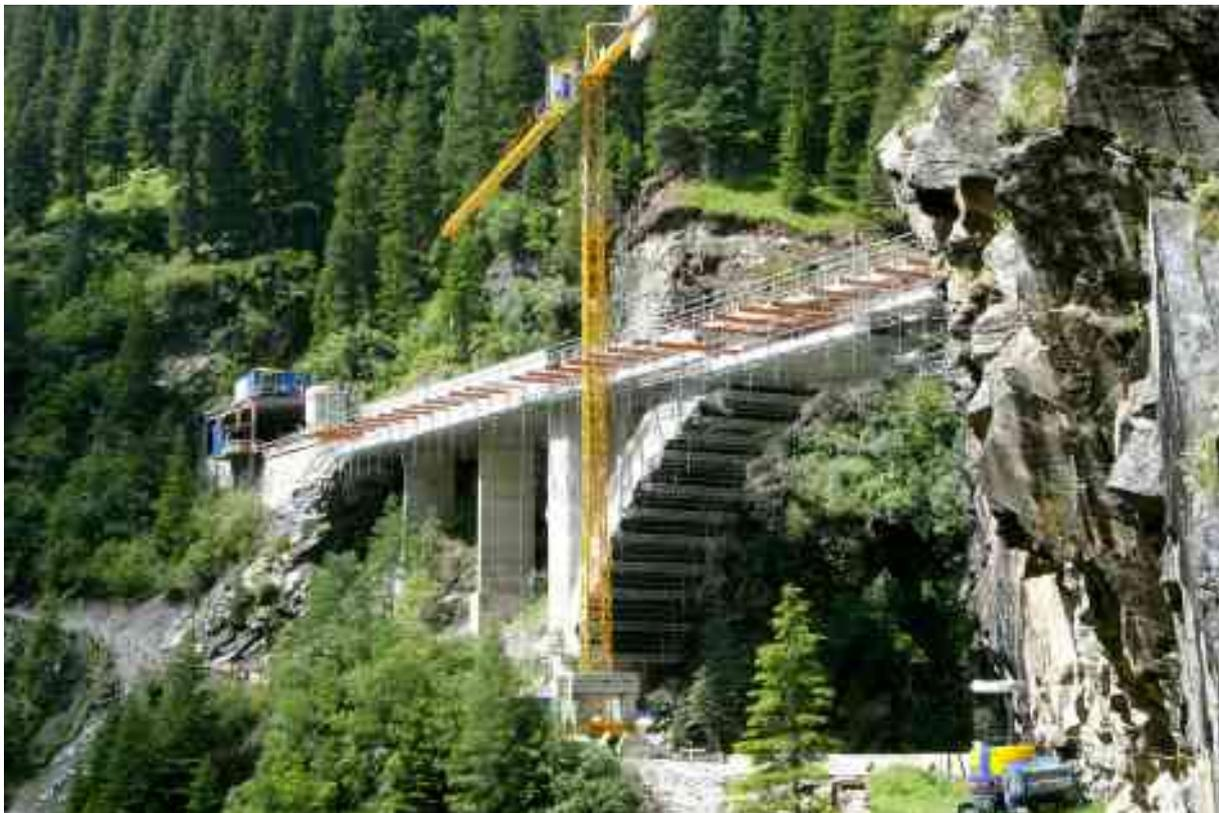
Bild 4 Verbreiterung und Verstärkung der Punt Reno di Lei im Aversertal
