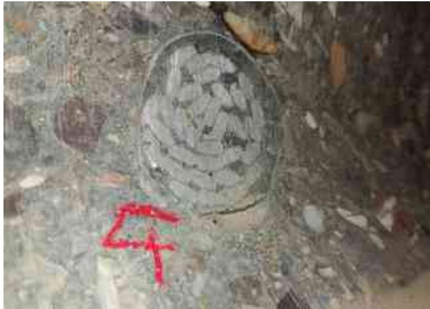
Bild 4 Geringer Schlupf der Spannlitzen am Trennschnitt im nachträglich verankerten Spannglied Foto: Johannes Diers, MKP
