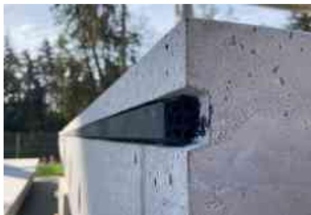
Bild 3 Fertiggestelltes direkt befahrbares Fahrbahnmodul im Werk mit Blick auf die geschliffene Stirnfläche (links) und Detail der eingelegten Tübbingdichtung (rechts)
