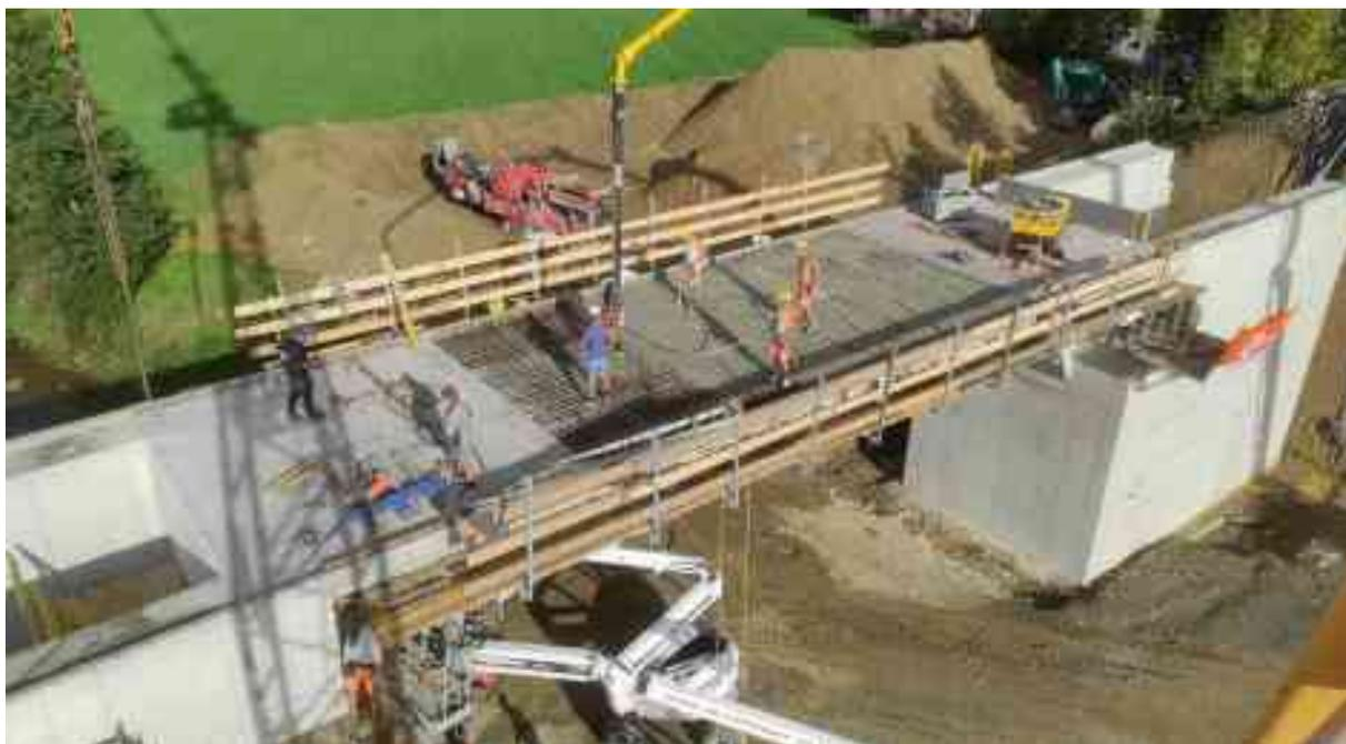
Bild 8 Herstellen des mittleren Teils der Aufbetonschicht auf den Fahrbahnplattenelementen
