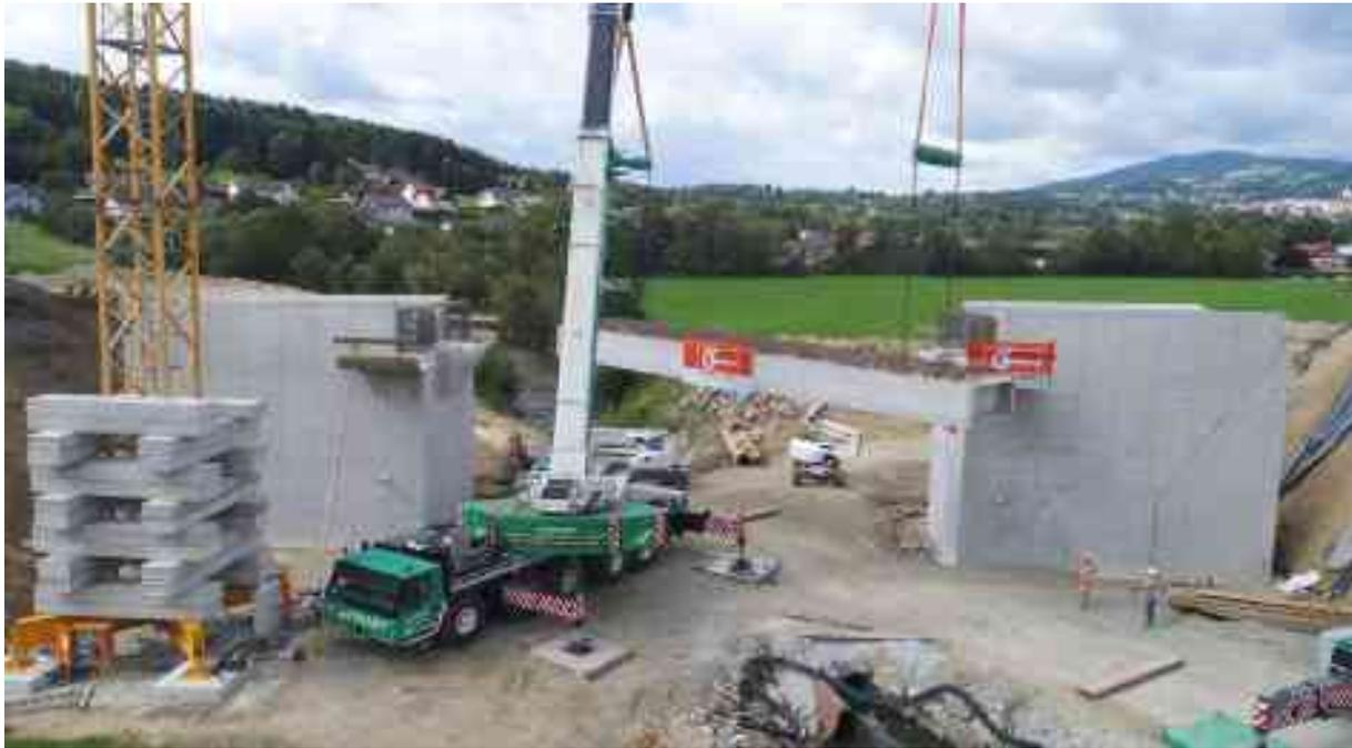
Bild 6 Einheben des Längsträgers der Pinkabachbrücke
