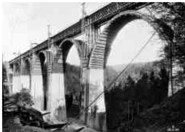
Bild 2 Verstärkung leichter Stahlbrücken; links: Linthbrücke bei Weesen (1859–1969), verstärkt mit einem Stabbogen 1896/97; rechts: Grandfey-Viadukt (1862) in Düdingen, Umbau 1926–1927
