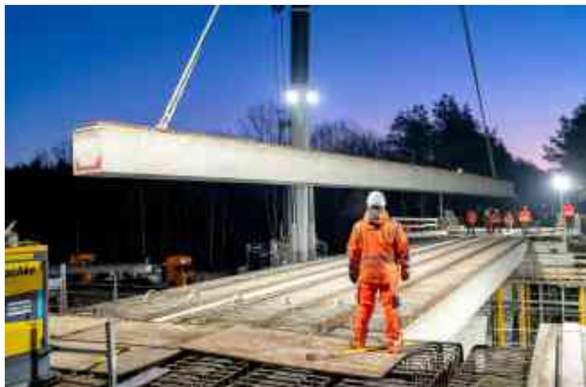
Bild 5 Fertigteilmontage
