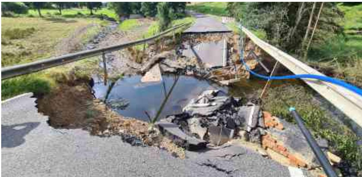
Bild 13 Schäden am Bauwerk L113/8 über den Houverather Bach
