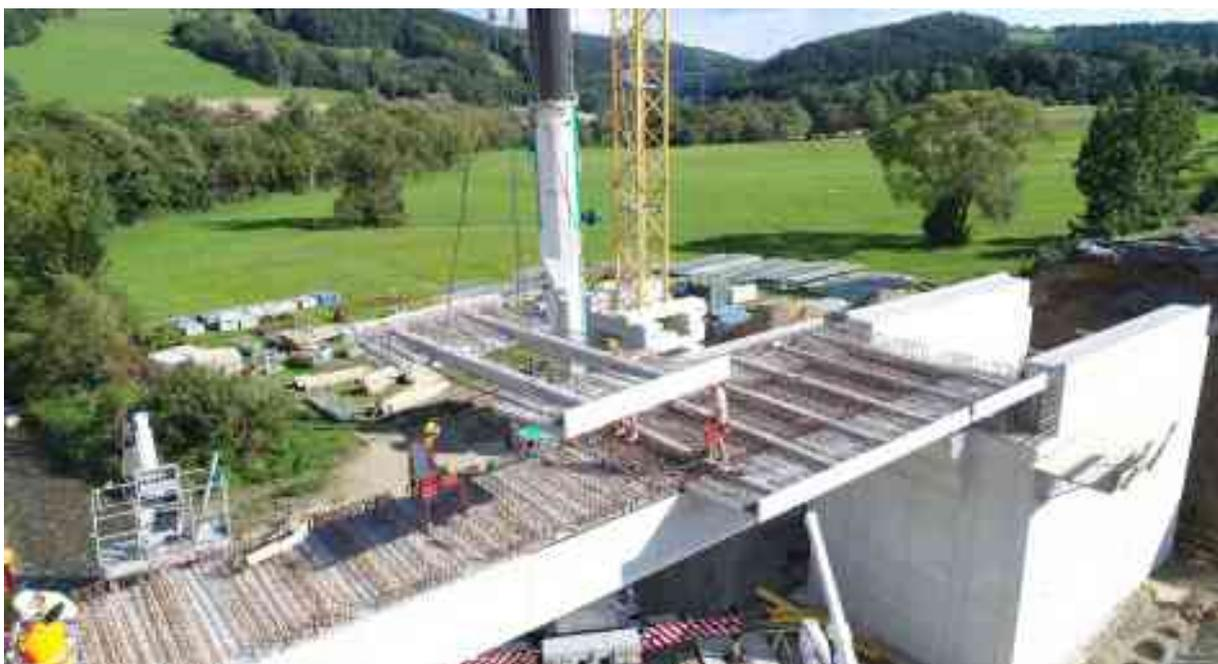
Bild 7 Einheben eines Fahrbahnplattenelements bei der Pinkabachbrücke
