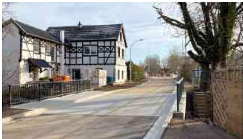
Bild 15 Fertiggestelltes Bauwerk mit modularen direkt befahrenen Platten über den Veybach
