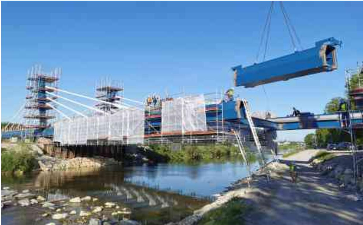
Bild 4 Lückenschluss Stahlüberbau
