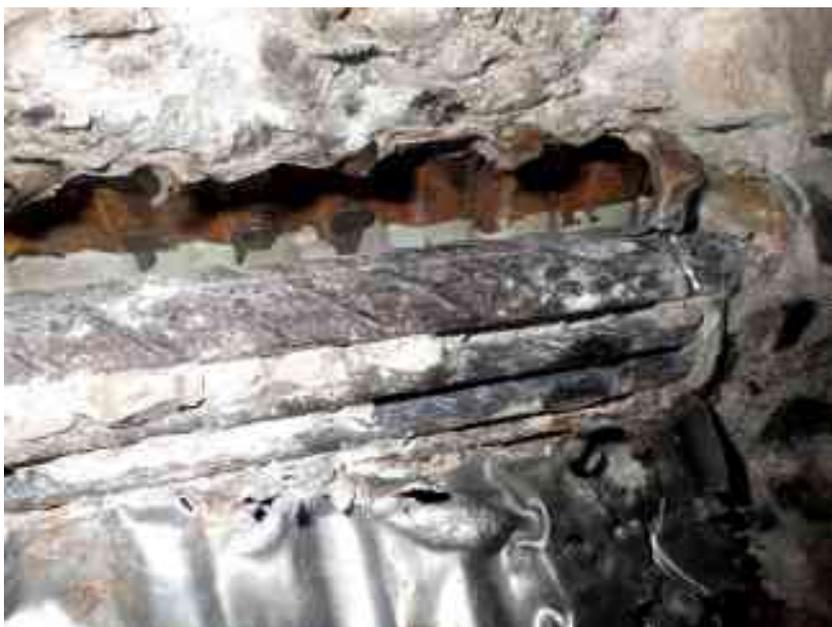
Bild 3 Öffnung eines Spannglieds mit mangelhaftem Verpresszustand
