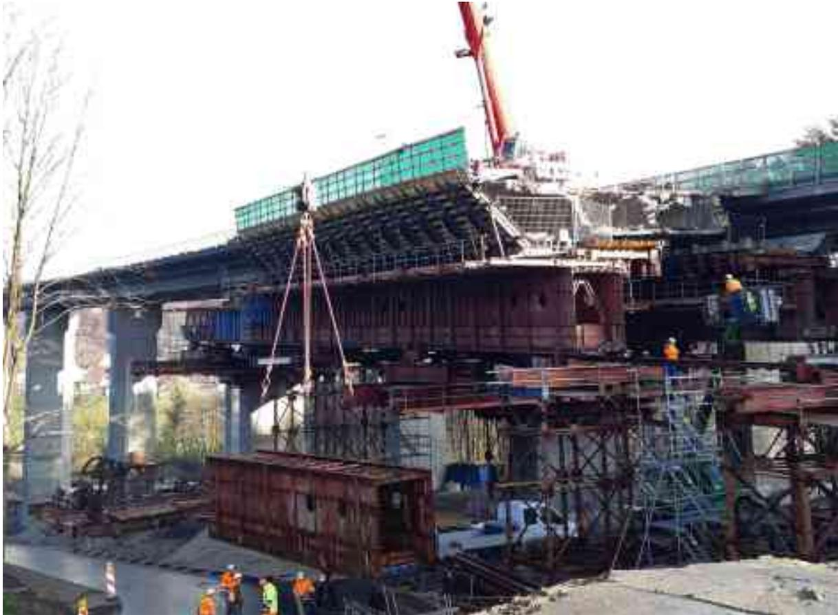
Bild 2 Mobilkran auf Überbau zum Einheben der Rüstung
