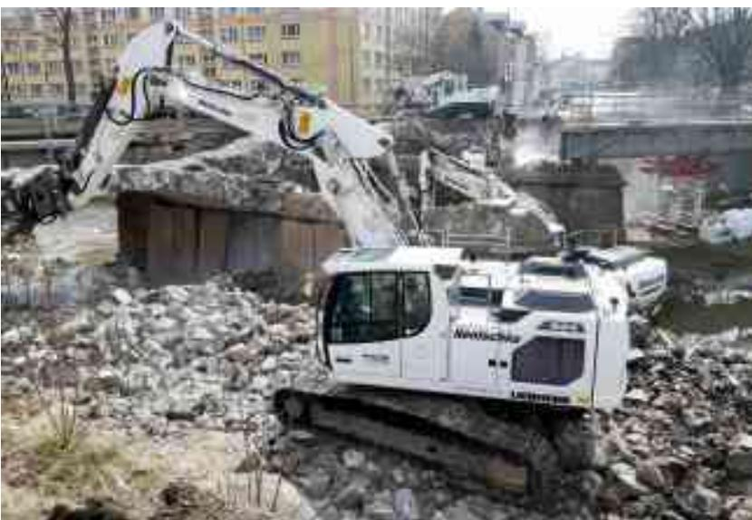
Bild 6 Streifenweiser Abbruch der drei Bögen
