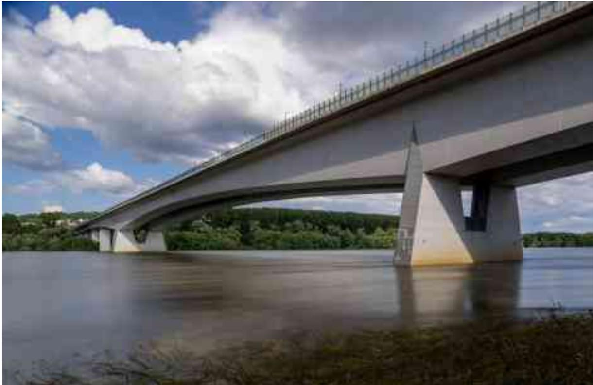
Bild 12 Rheinbrücke Bendorf: Der elegante Entwurf von Finsterwalder, Schambeck und Lohmer war nicht nur die preisgünstigste Lösung, sondern hielt auch den Weltrekord als weitest gespannte Betonbalkenbrücke
