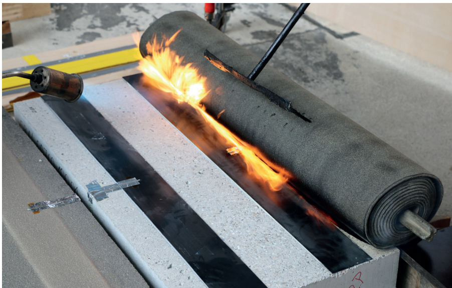
Bild 7: Aufbringen der PBD
