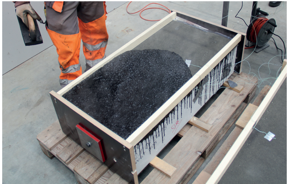
Bild 8: Einbau des Gussasphaltes
