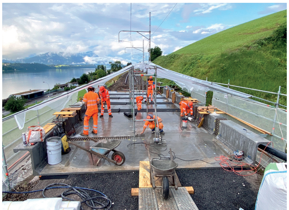
Bild 7: UHFB-Fahrbahntrög auf der Bahnstrecke von Luzern nach Immensee in der Schweiz
