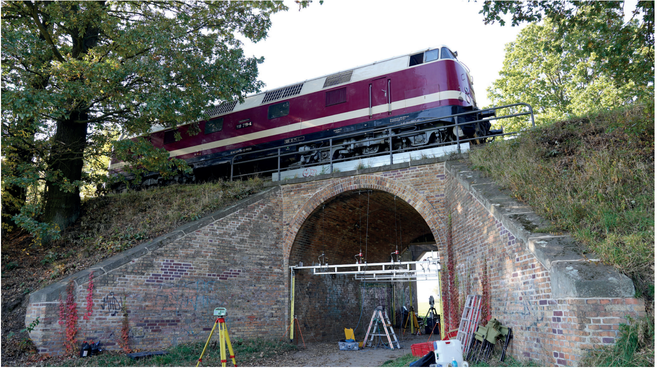
Bild 5: Versuchsaufbau für die Messung der Reaktionen von Eisenbahnlasten an einer Gewölbebrücke
