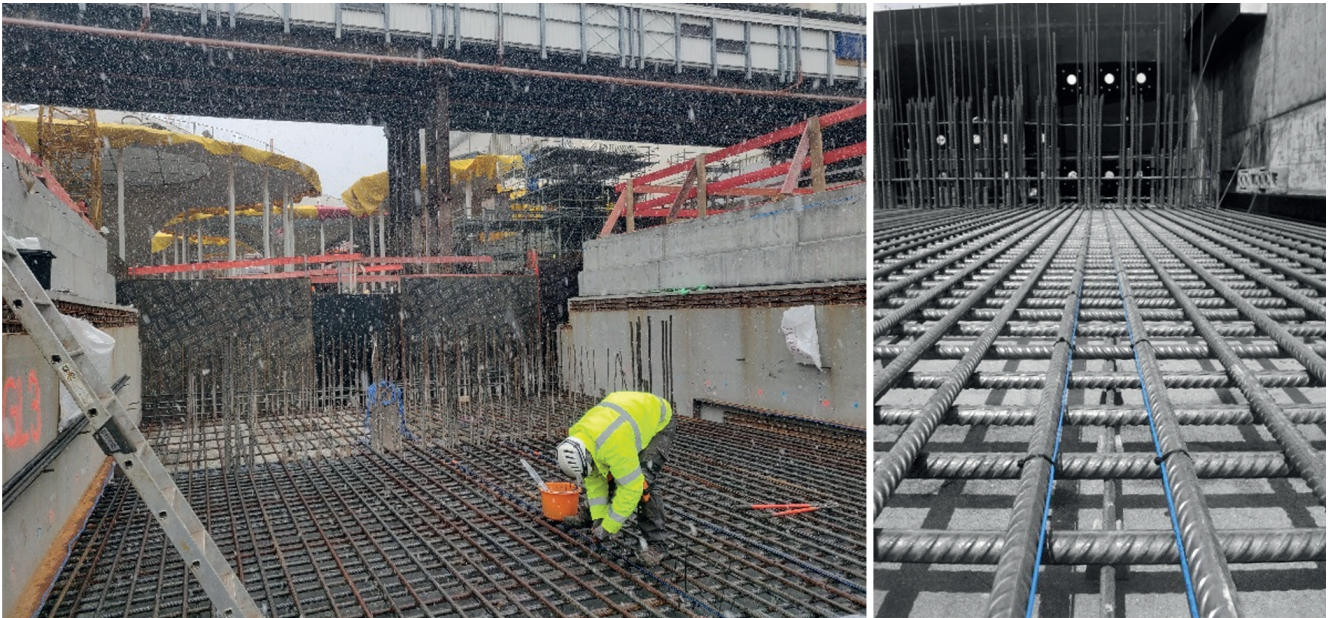
Bild 10: Installation der faseroptischen Sensorkabel (links) und Fixierung mit Kabelbindern (Dehnungsschleife, rechts) Fotos: Fabian Buchmayer, ACI Monitoring GmbH
