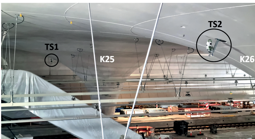
Bild 7: Totalstationen TS1 und TS2 des geodätischen Monitoringkonzeptes (September 2025)
