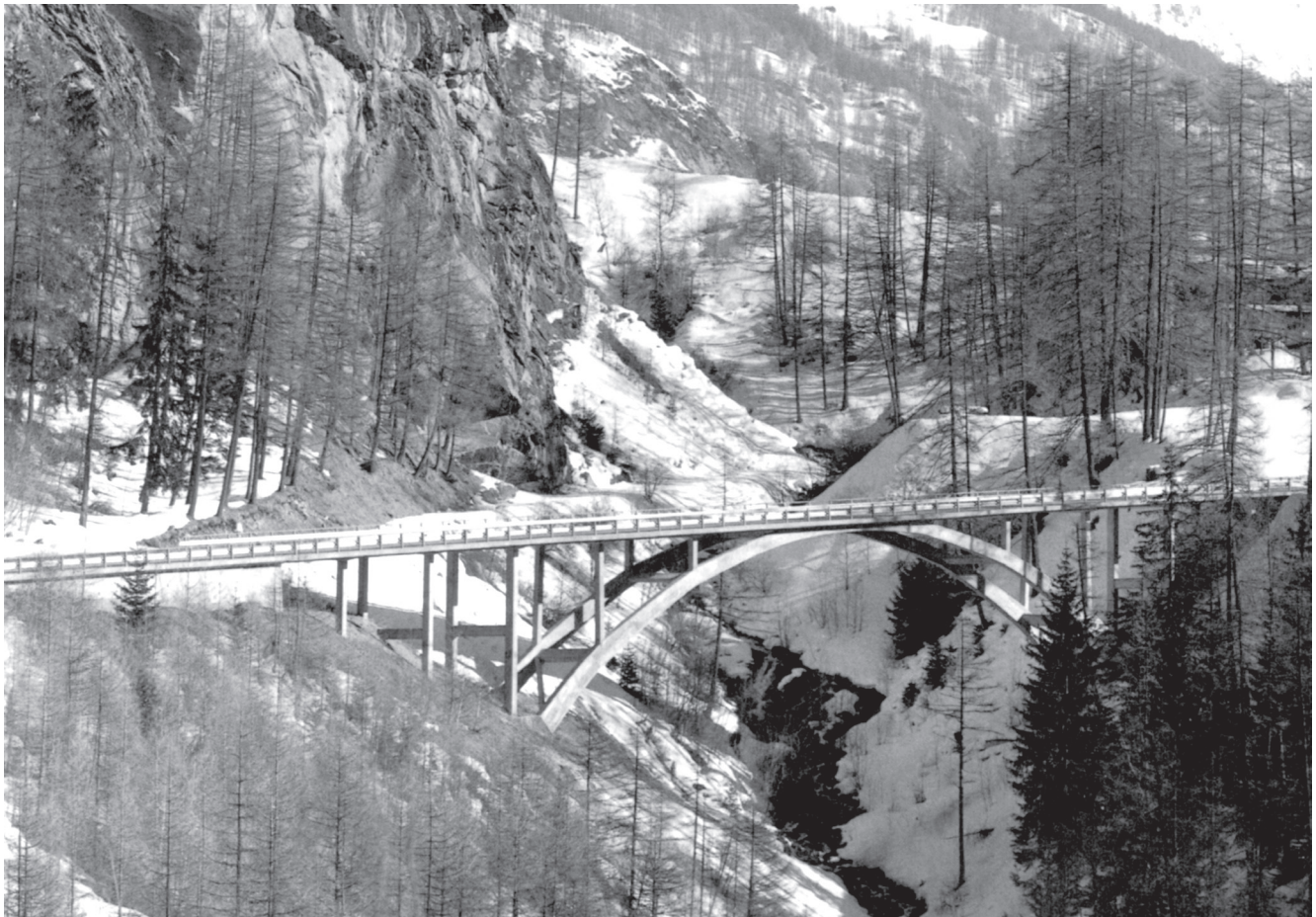
Bild 18: Ansicht der Sarrasin-Brücke in Evolène
