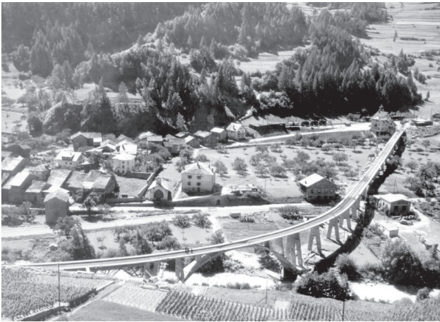
Bild 20: Bahnviadukt der Linie Martigny-Orsières in Sembrancher, 1952/53 Büro A. Sarrasin (Archiv Ph. M.)
