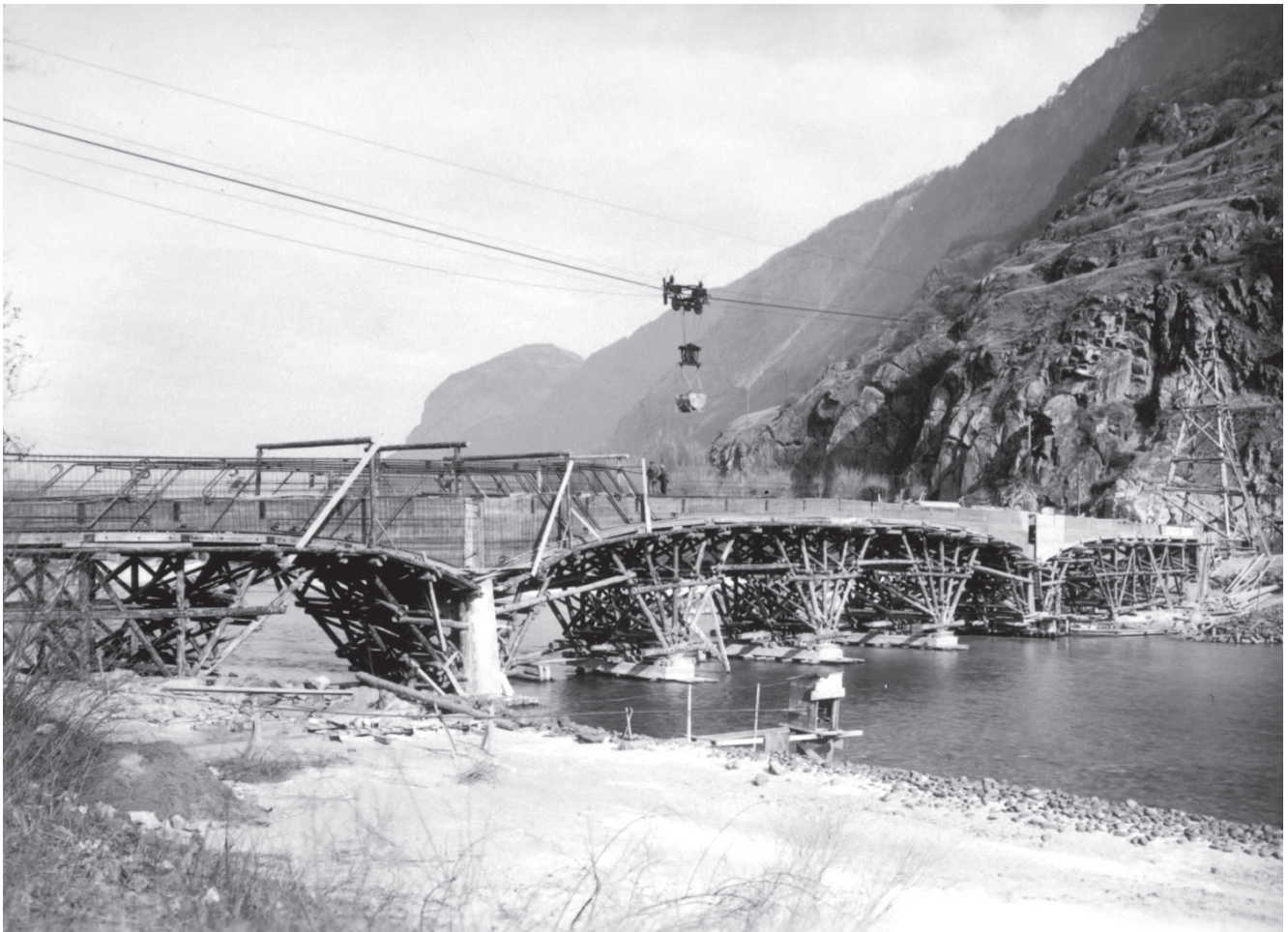
Bild 7: Bau der Dorénaz-Brücke 1932/33
