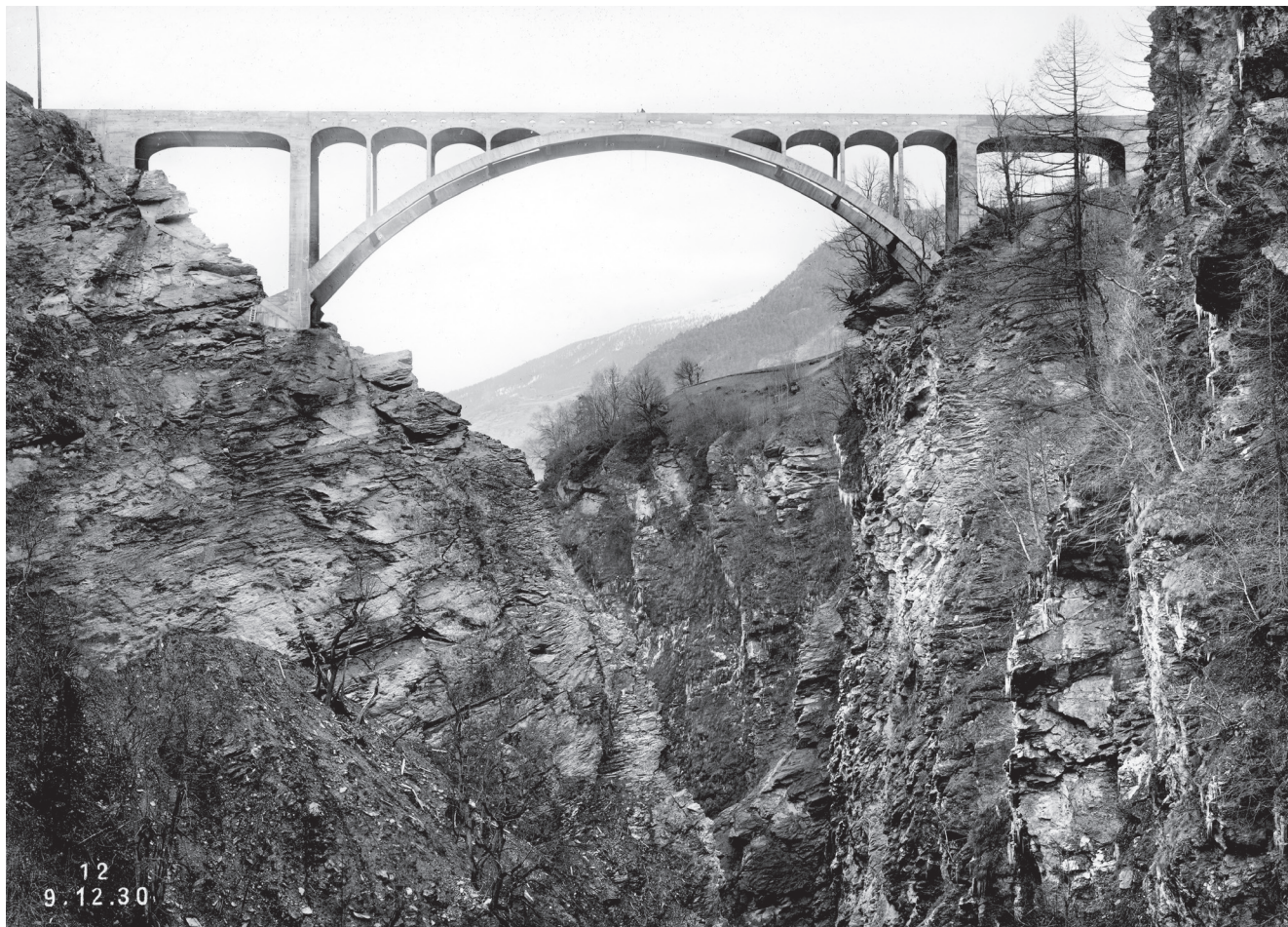
Bild 3: Meryen-Brücke über dem Vispertal in Stalden 1928–1930
