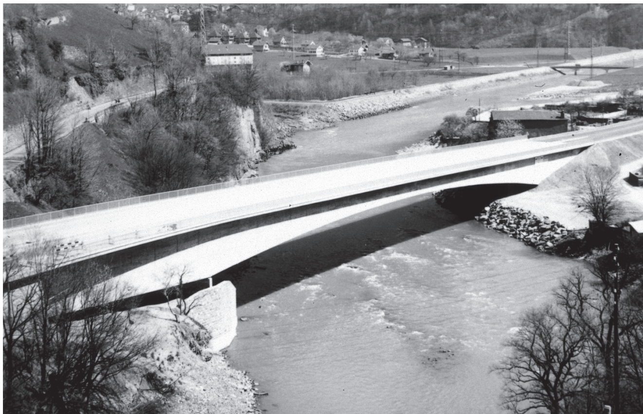
Bild 23: Fertiggestellte Rhonebrücke in Saint-Maurice vor ihrer Inbetriebnahme
