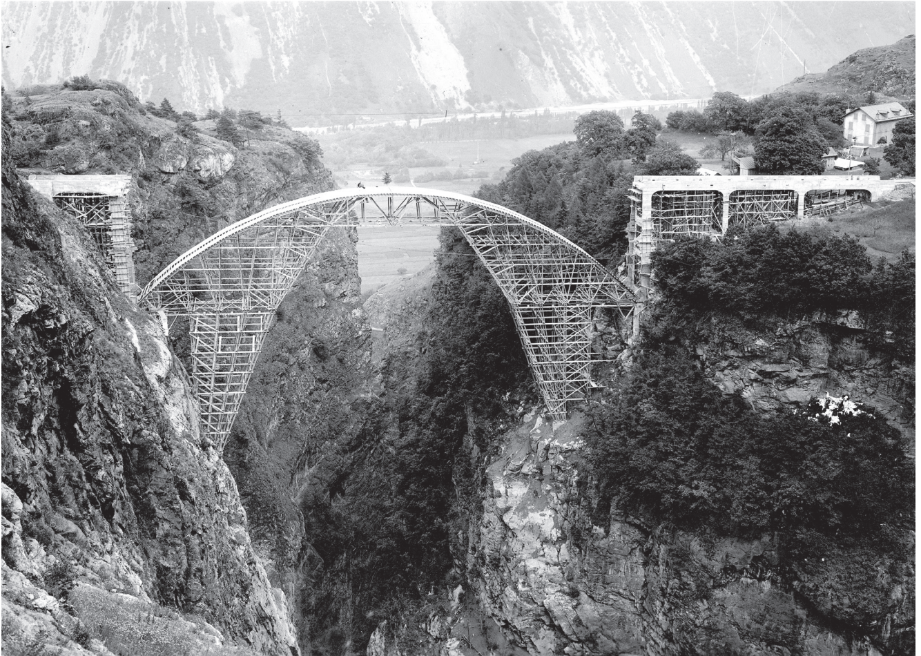
Bild 2: Gerüst für die Gueuroz-Brücke, errichtet von dem Gerüstbauer Richard Coray
