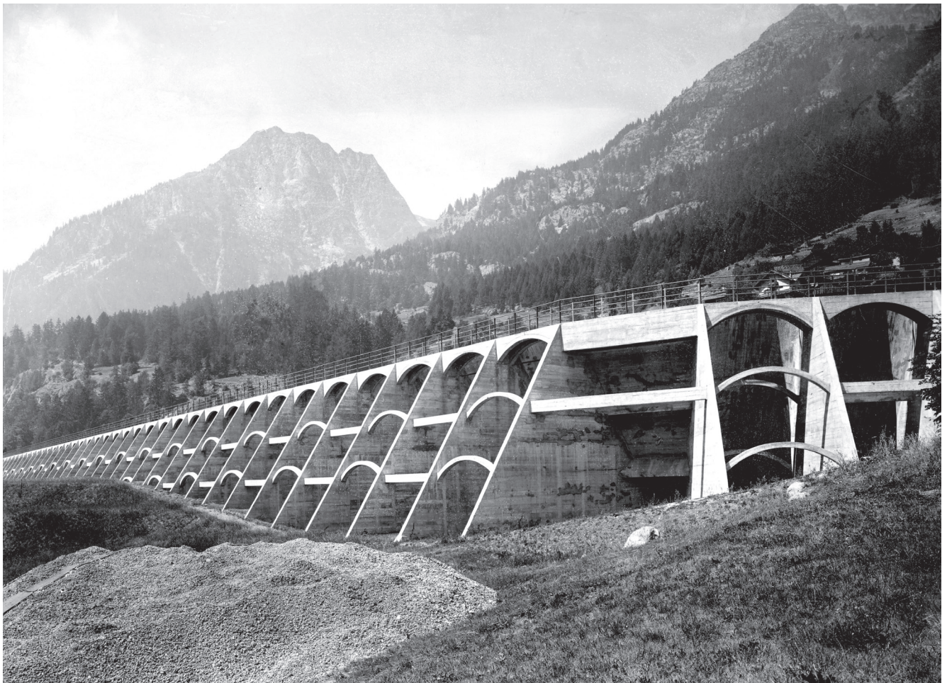
Bild 10: Staumauer um das Ausgleichsbecken von Les Marécottes (Salvan), 1926 – das Wasserkraftwerk Barberine erzeugte Strom für die Elektrifizierung der Schweizerischen Bundesbahnen (SBB) (Bild aus Schweizerische Bauzeitung 113 (1939) 19, S. 233)
