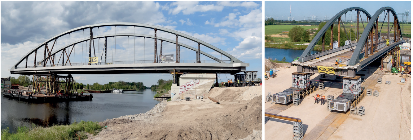
Bild 8: Ausschwimmen des Überbaus (links) und vorbereitete Montagefläche mit Verschubbahn und seitlicher Kranaufstellfläche (rechts)
