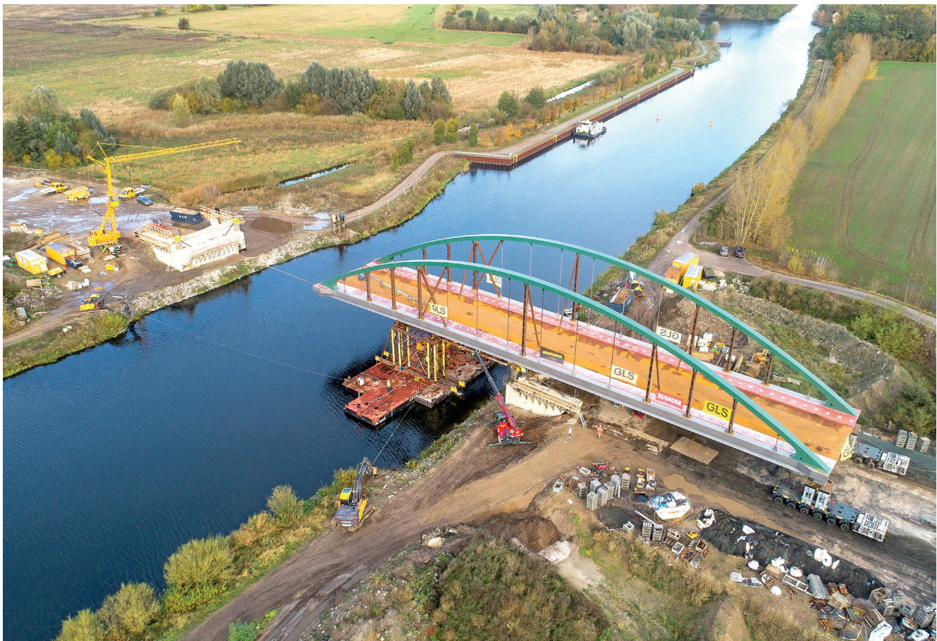
Bild 11: Einschwimmen der verbreiterten Stabbogenbrücke
