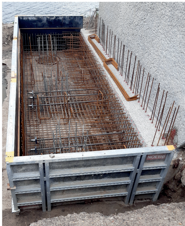
Bild 4: Herstellung der Kernbohrungen (links) und Bestandsunterbauten mit Anschlussbewehrung und GEWI-Stäben (rechts)
