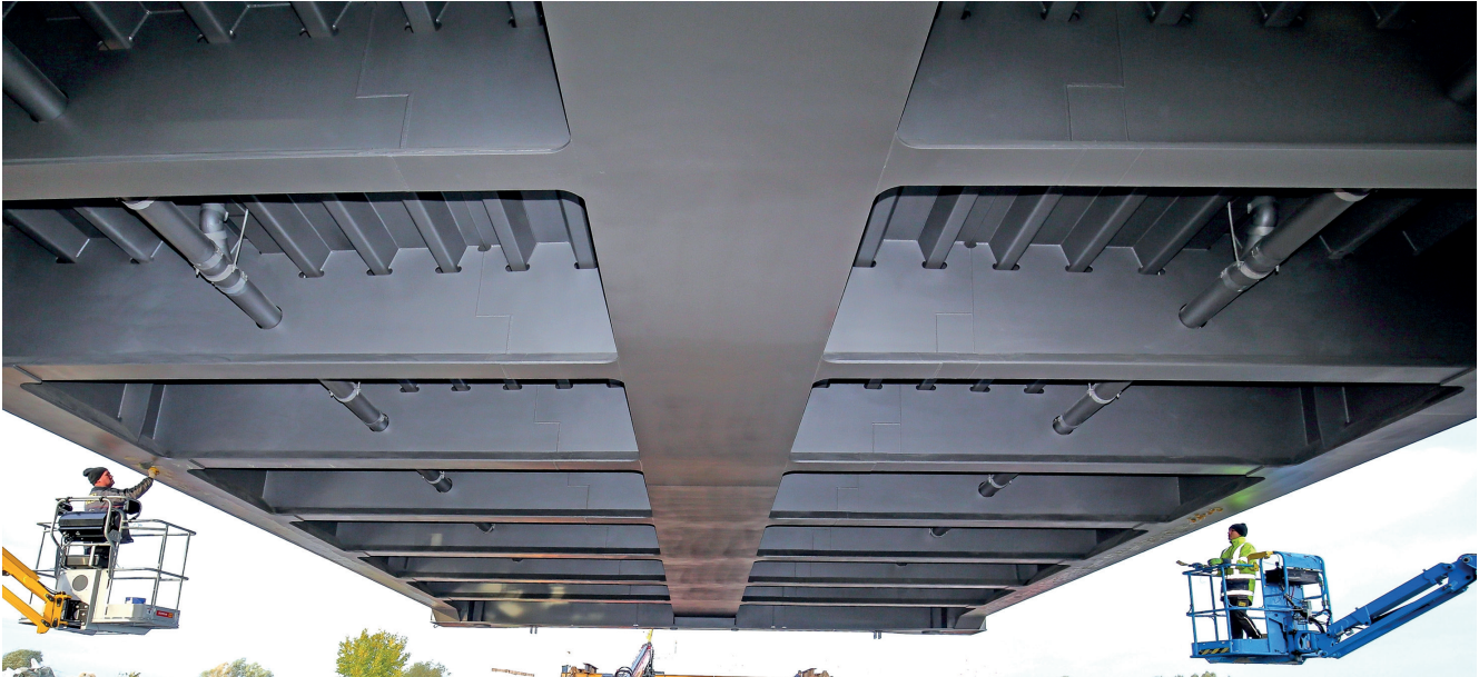
Bild 10: Untersicht des verbreiterten Überbaus kurz vor dem Einschwimmen
