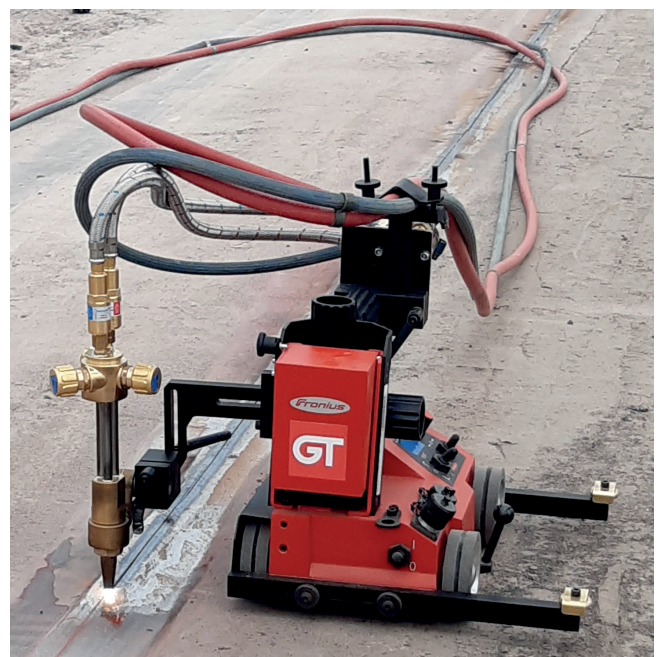
Bild 9: Einsatz eines Schweißroboters zum Auftrennen des Fahrbahnblechs
