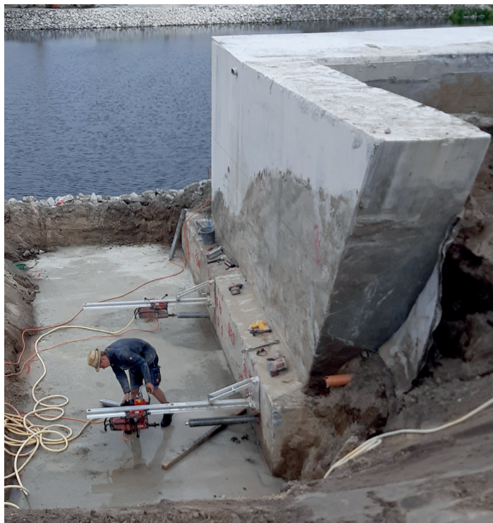
Bild 4: Herstellung der Kernbohrungen (links) und Bestandsunterbauten mit Anschlussbewehrung und GEWI-Stäben (rechts)
