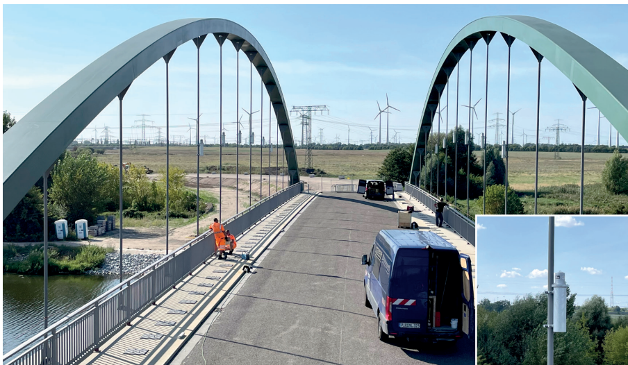
Bild 6: Montierte Schwingungstilger
