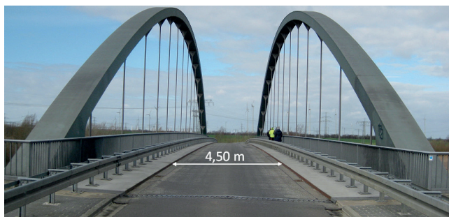
Bild 1: Ansicht des Brückenquerschnitts des Bestandsbauwerkes
