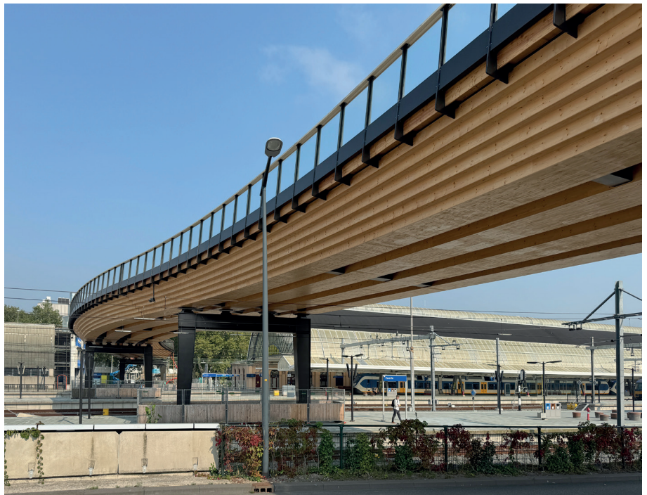
Bild 6: Fertigstellung des Überbaus während der einhundertstündigen Sperrpause der Bahn Foto: © Schmees/IB-Miebach
