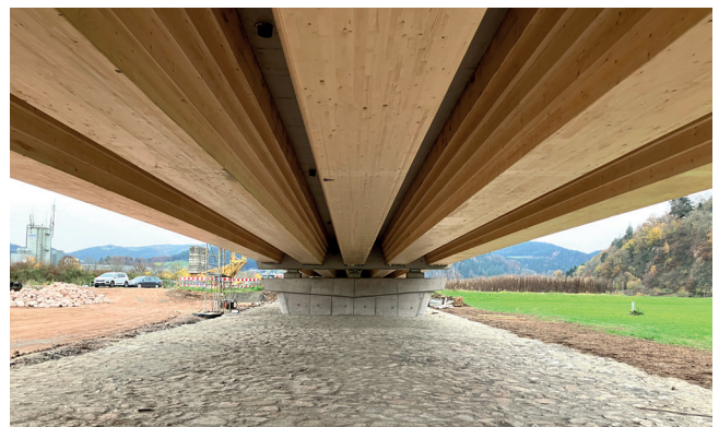
Bild 9: Untersicht der fertig montierten Brücke Foto: © IB-Miebach
