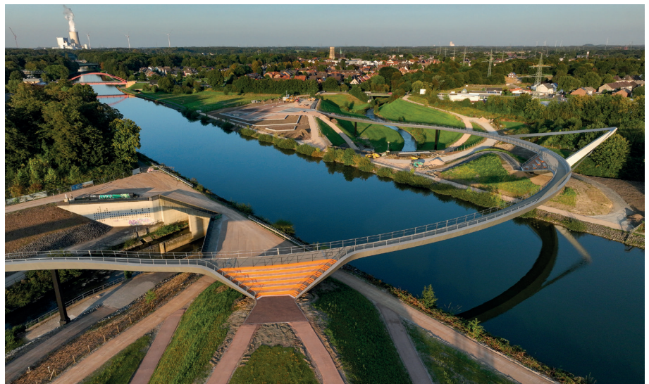
Bild 11: Der „Sprung über die Emscher“ ist fertiggestellt
