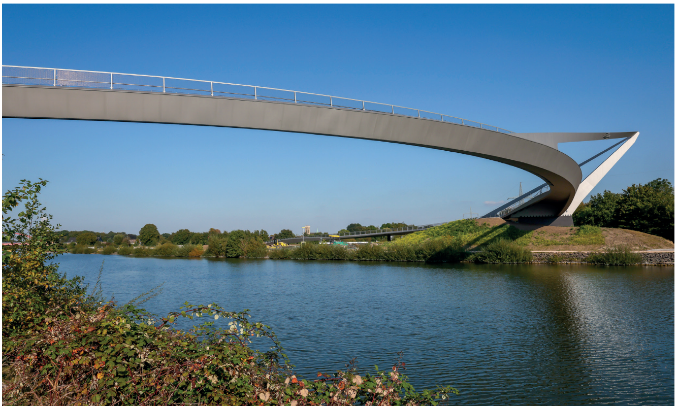
Bild 5: Pylon und Zügelgurte an der Querung des Rhein-Herne-Kanals
