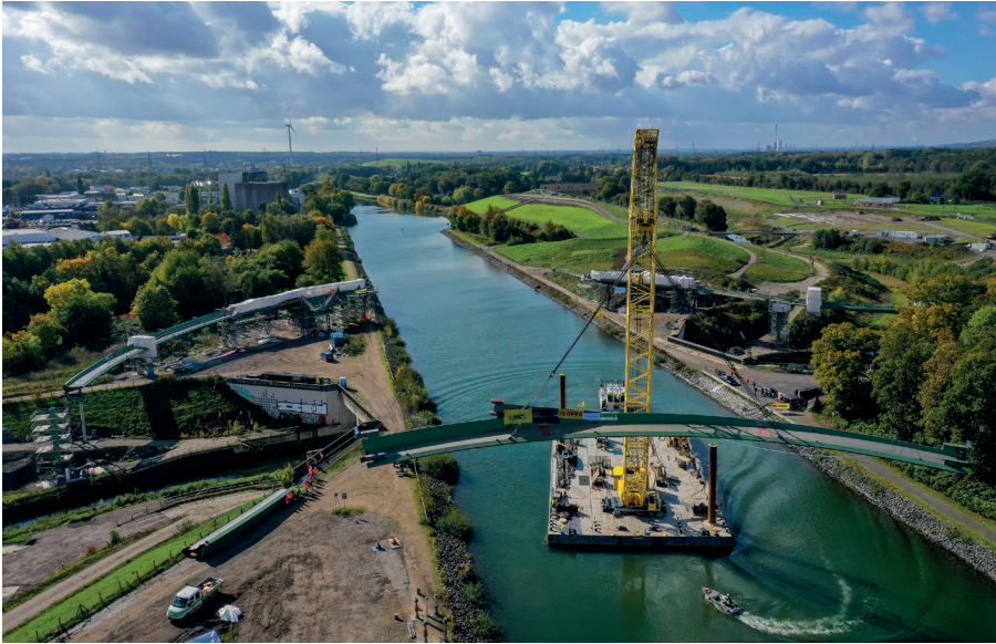
Bild 10: Montage von Segment 9 über dem Rhein-Herne-Kanal
