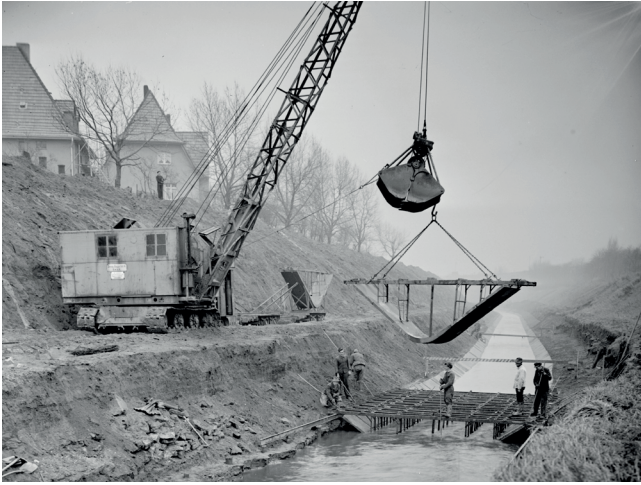
Bild 2: Verlegung von Sohlschalen am Hüller Bach, Herne Foto: EGLV
