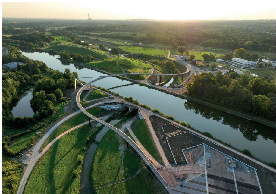
Bild 1: Der „Sprung über die Emscher“
