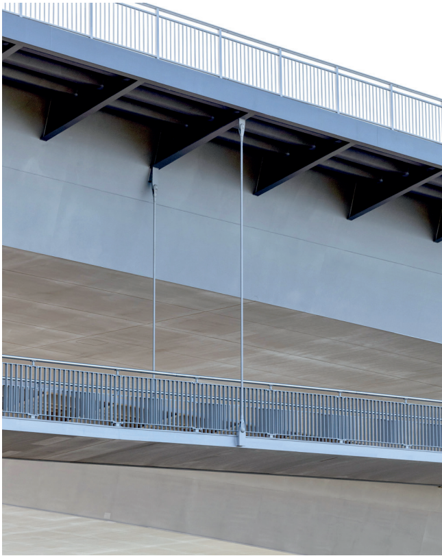
Bild 2: Unter dem Kragarm angebrachter Fuß- und Radweg © Frank Heinen, Sweco GmbH
