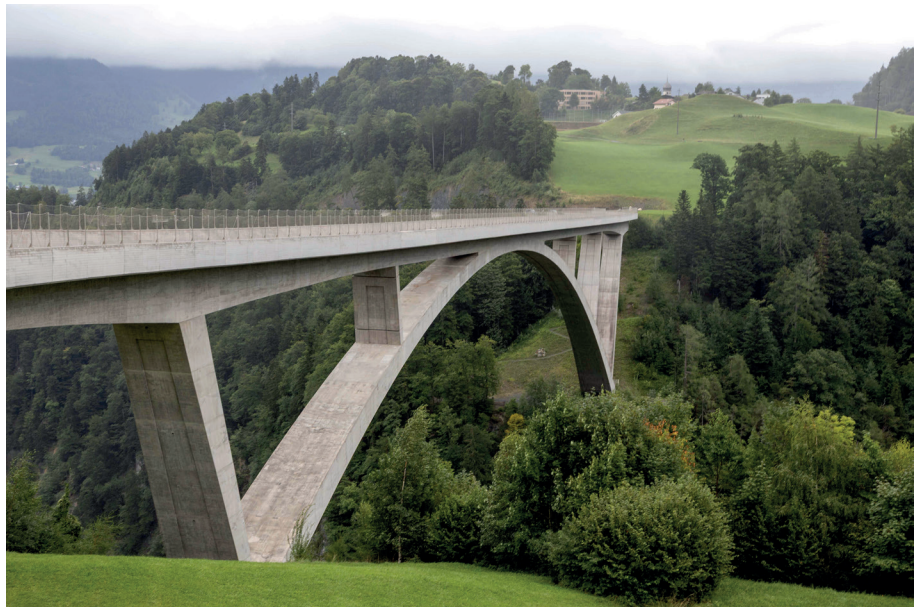
Bild 8: Taminabrücke bei Bad Ragaz
