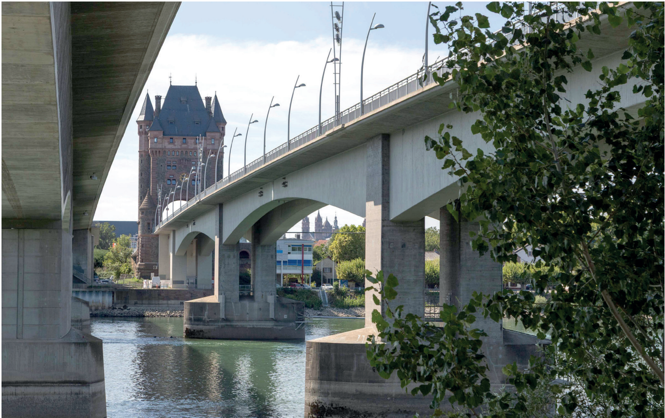
Bild 3: Ingenieurbaukunst à la Ulrich Finsterwalder – die Nibelungenbrücke in Worms
