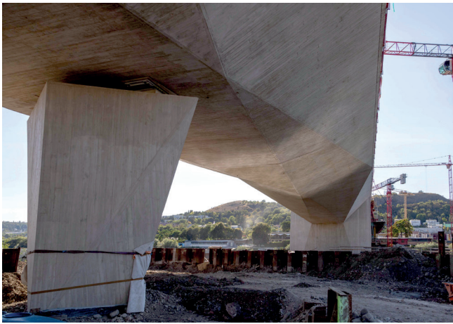
Bild 13: Bau der Dvorecký-Brücke in Prag Foto: Ferdinand Schulte zu Sodingen
