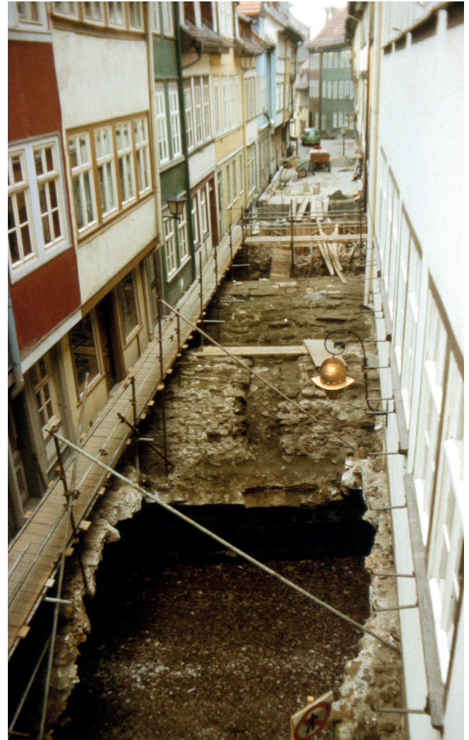
Bild 11: Erneuerung, Reprofilierung und Ertüchtigung des mittleren Teils der Naturstein-Gewölbekonstruktion zwischen den Häuserfluchten im Rahmen der Instandsetzung 1985/86
