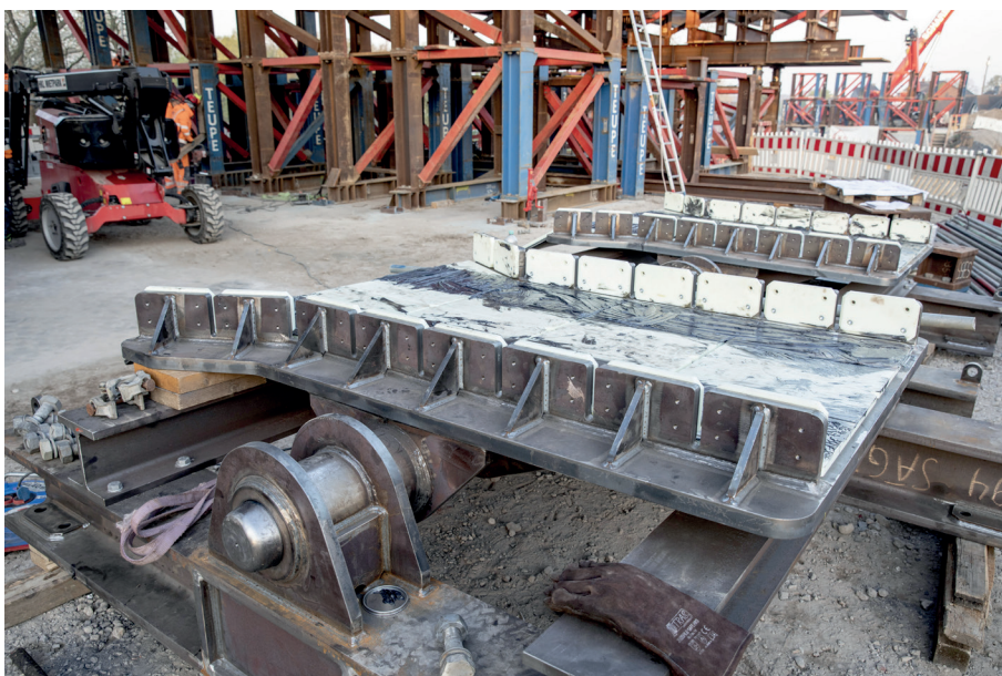
Bild 3: Eines der Wippenlager vor der Montage
