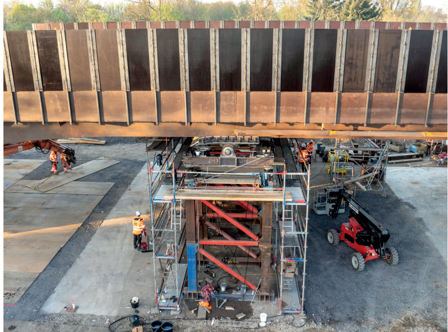
Bild 4: Beispielhafte Verschiebachse unter Last mit Wippenlagern auf den Bati-Türmen
