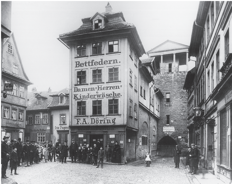
Bild 8: Blick vom Benediktspatz auf den zurückgebauten Turm der Benediktikirche um 1895
