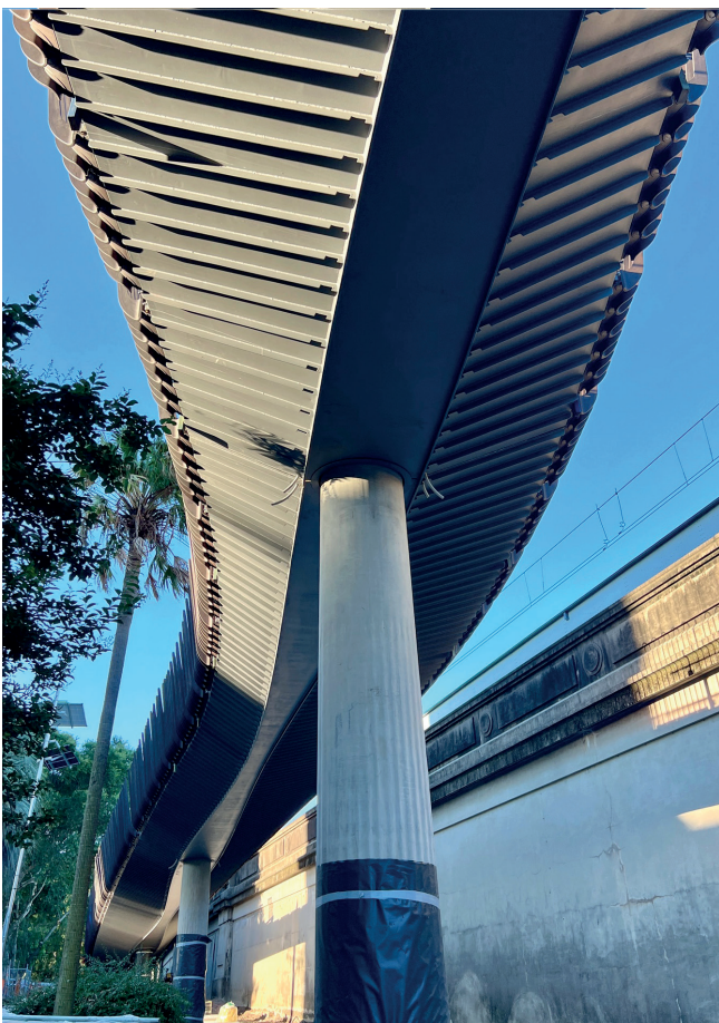
Bild 3: Untersicht der Brücke mit Fertigteilpfeilern Foto: Angus Murray, Stantec
