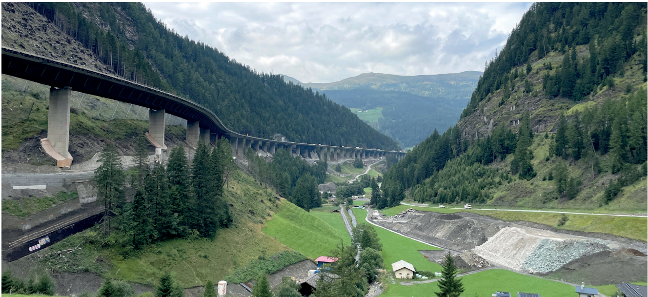
Bild 10: Luegbrücke – Blickrichtung Innsbruck
