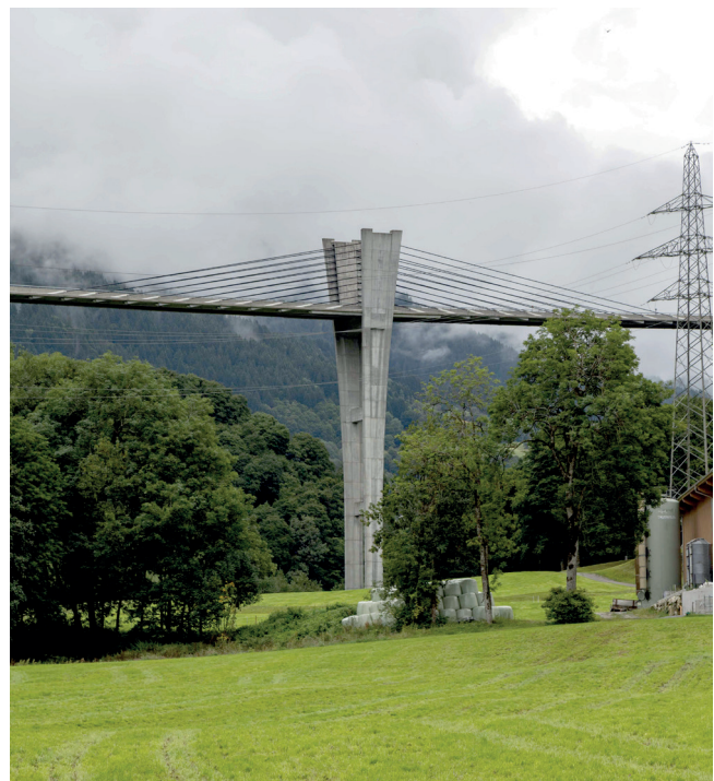
Bild 7: Charakteristisch gespreizte Pylone der Sunnibergbrücke
