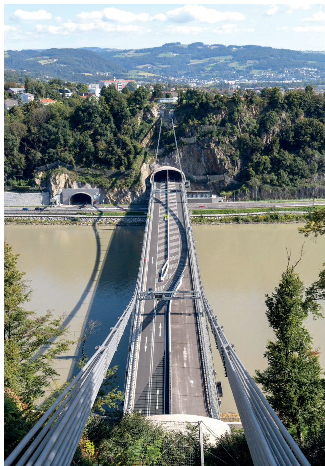
Bild 11: Donautalbrücke im Zuge der A 26 in Linz
