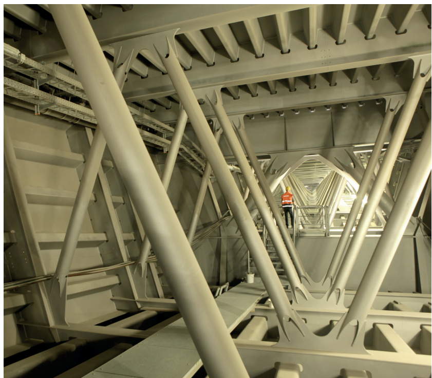
Bild 3: Orthotrope Platte
