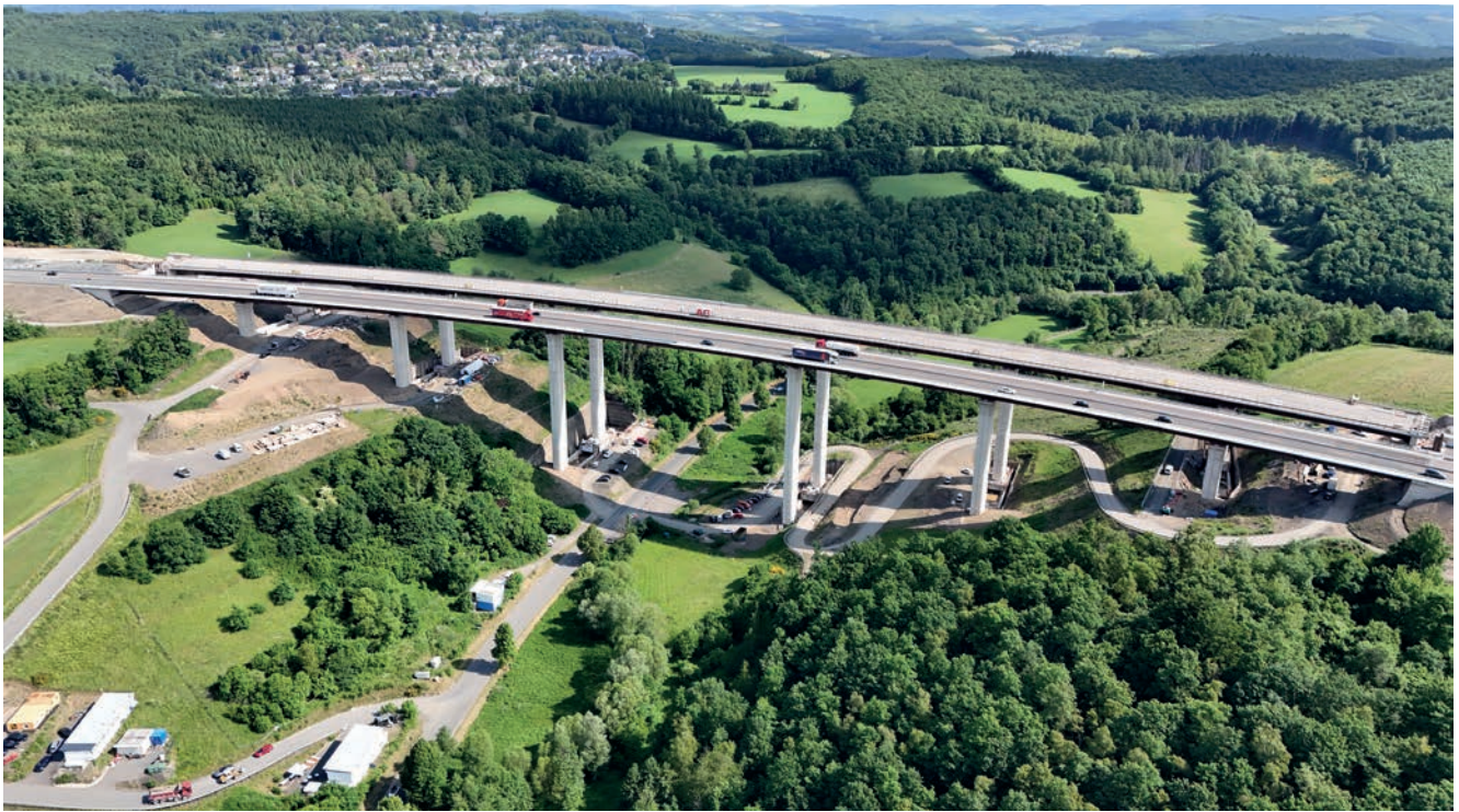
Bild 4: Luftbild Talbrücke Rinsdorf vor dem Querverschub
