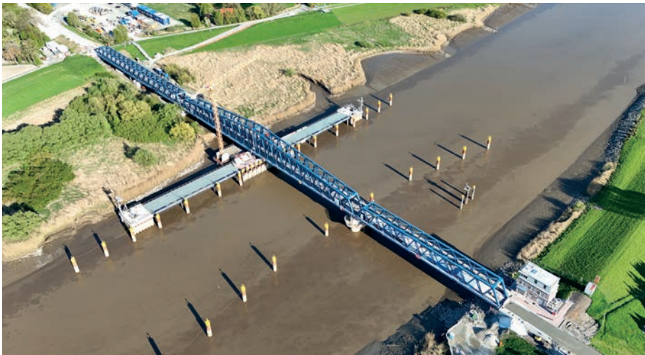
Bild 14: Fertigstellung der Friesenbrücke im Herbst 2025
