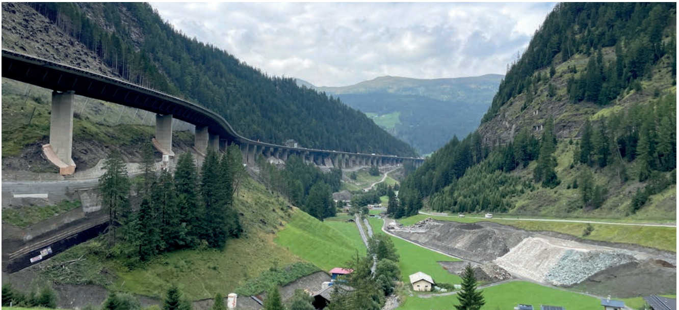
Bild 10: Luegbrücke – Blickrichtung Innsbruck
