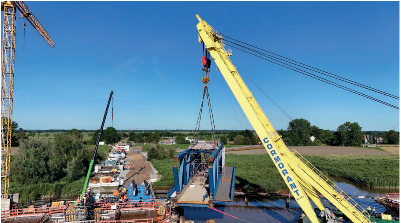
Bild 10: Übergabe der Bauteilkomponente Zweifeldbrücke auf der Baustelle
