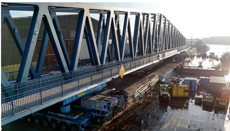
Bild 13: Hochstapeln und Überfahrt der Drehbrücke über die Kaikante
