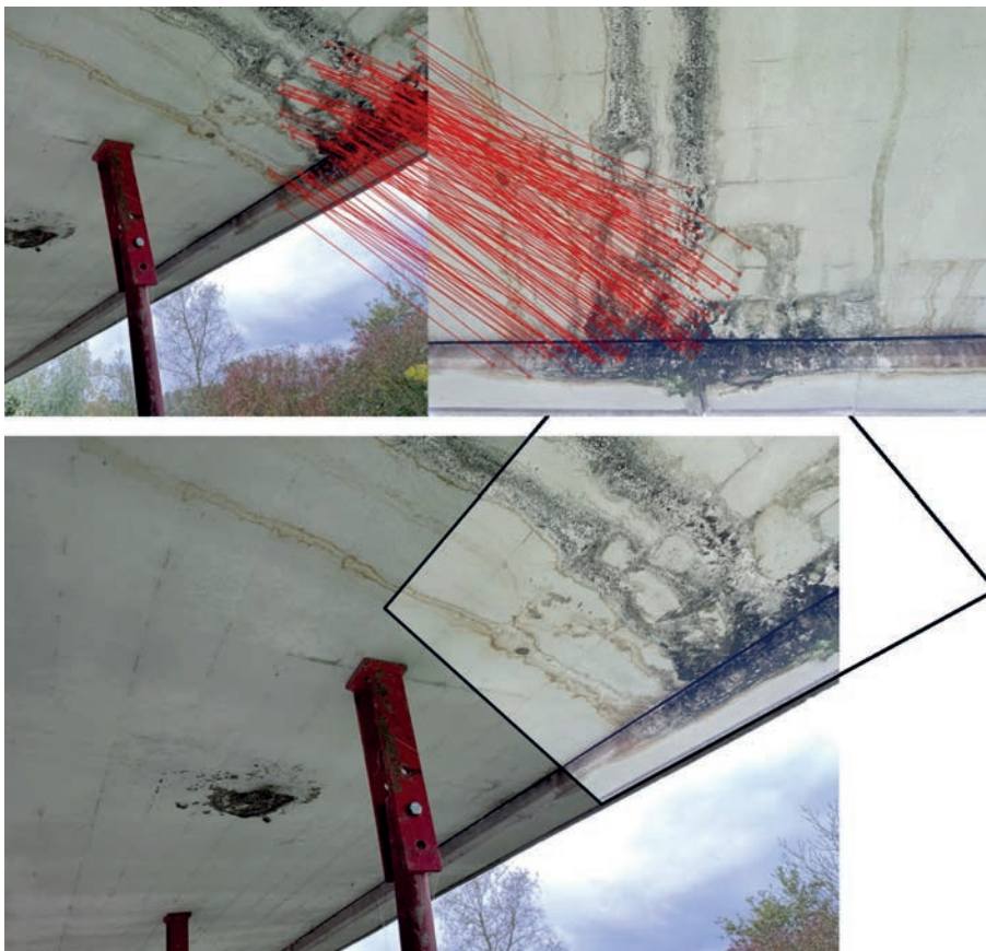
Bild 4: KI-basiertes Bildmatching anhand von Laserscans
