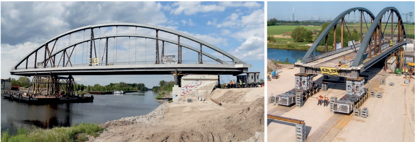
Bild 8: Ausschleppen des Überbaus (links) und vorbereitete Montagefläche mit Verschiebetrack und seitlicher Kranaufstellfläche (rechts)
