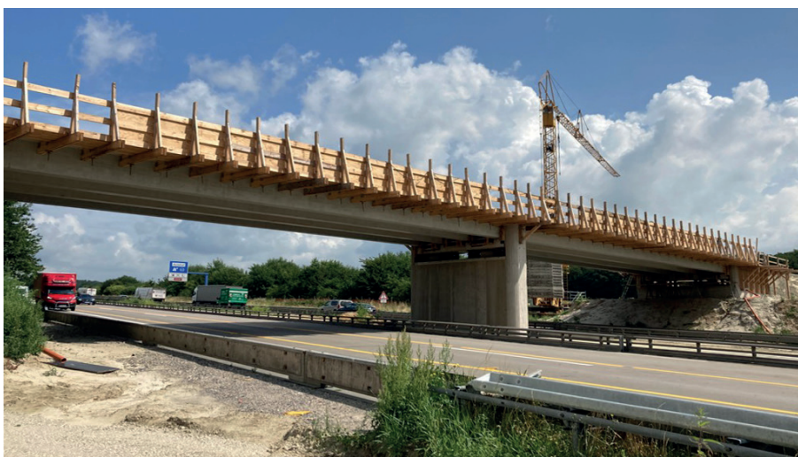
Bild 3: Ersatzneubau von Brücken über die sechsstreifige A 1 nördlich von Osnabrück; funktionale Ausschreibung (Paket von fünf Brücken) auf der Grundlage des vielseitig einsetzbaren Standardentwurfs „Spannbetonzweifeldträger in Fertigteilbauweise“
