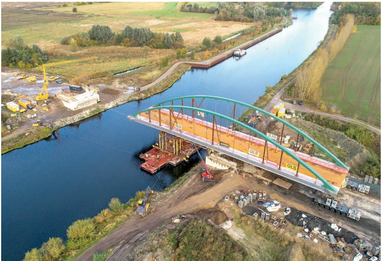
Bild 11: Einschwimmen der verbreiterten Stabbogenbrücke
