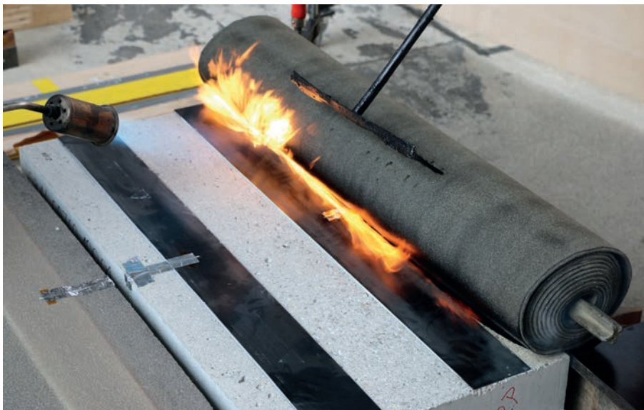
Bild 7: Aufbringen der PBD
