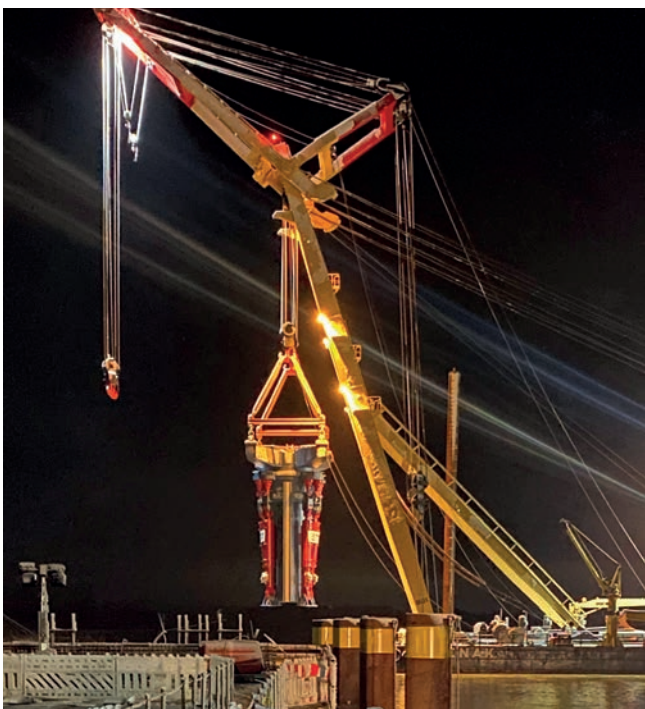
Bild 11: Einhub der Maschine in den Drehpfeiler
