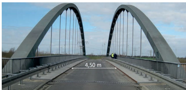
Bild 1: Ansicht des Brückenquerschnitts des Bestandsbauwerkes
