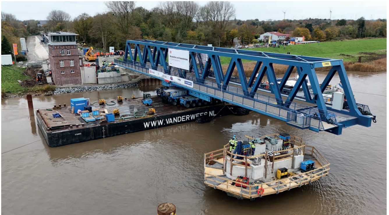
Bild 12: Drehung der Einfeldbrücke auf dem Ponton vor Ort
