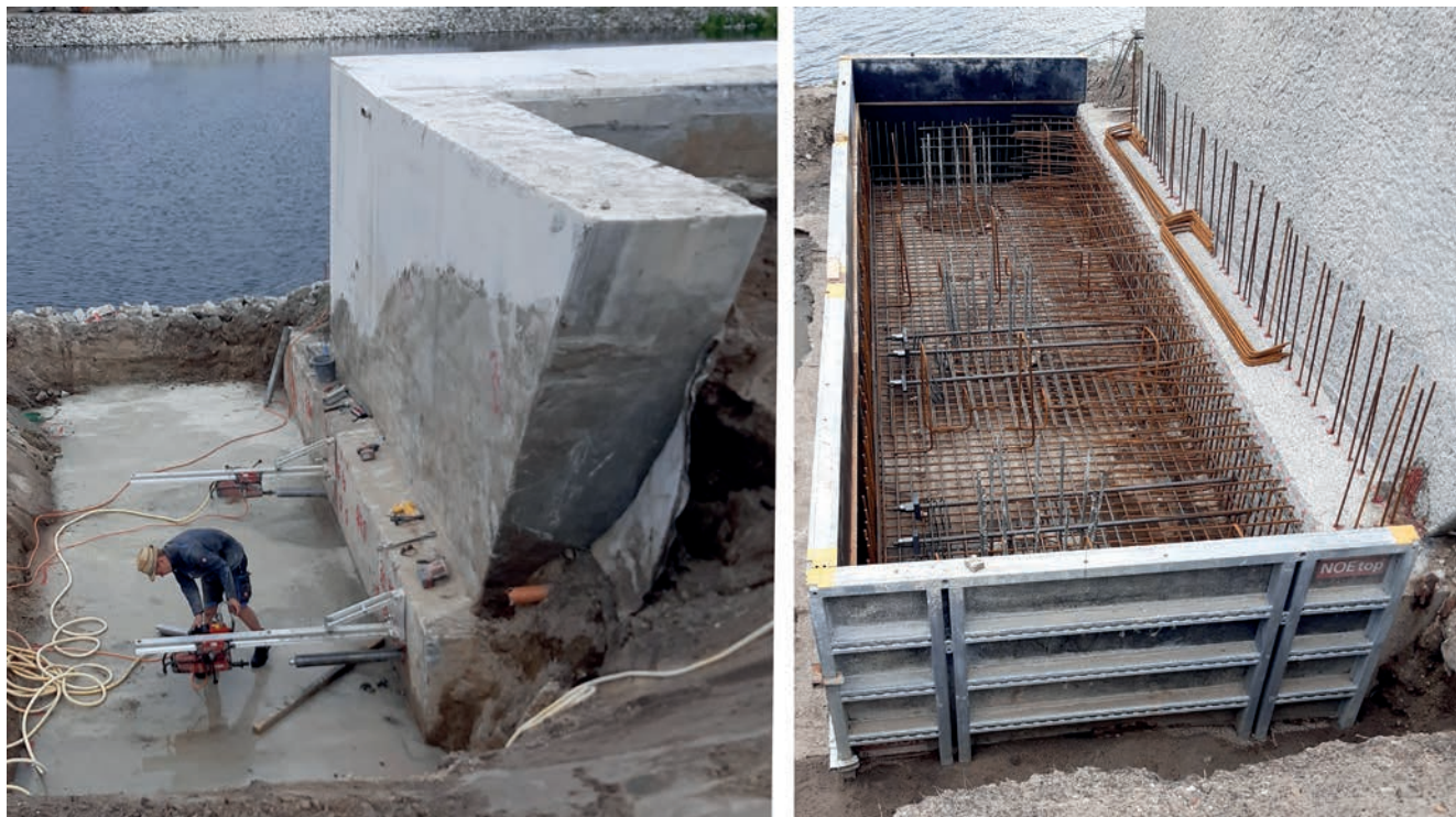
Bild 4: Herstellung der Kernbohrungen (links) und Bestandsunterbauten mit Anschlussbewehrung und GEWI-Stäben (rechts)
