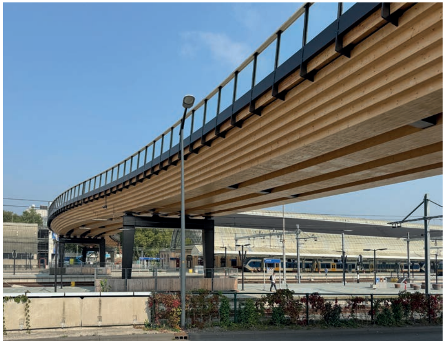
Bild 6: Fertigstellung des Überbaus während der einhundertstündigen Sperrpause der Bahn
