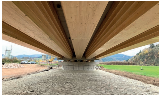
Bild 9: Untersicht der fertig montierten Brücke Foto: © IB-Miebach
