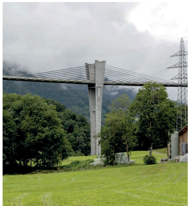
Bild 7: Charakteristisch gespreizte Pylone der Sunnibergbrücke
