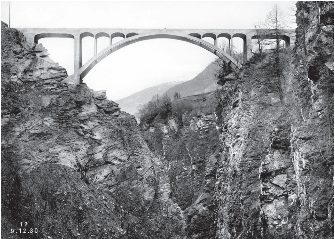
Bild 3: Meryen-Brücke über dem Vispertal in Stalden 1928–1930
