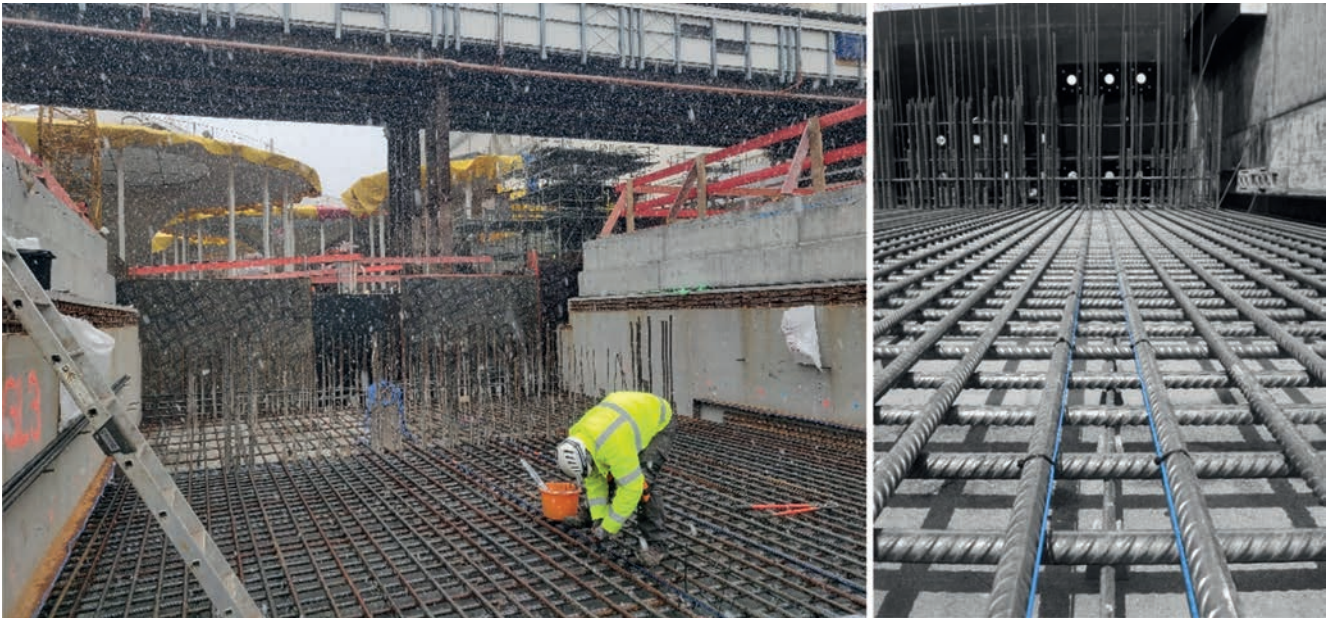
Bild 10: Installation der faseroptischen Sensorkabel (links) und Fixierung mit Kabelbindern (Dehnungsschleife, rechts)
