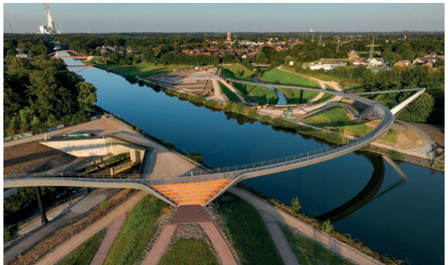
Bild 11: Der „Sprung über die Emscher“ ist fertiggestellt
