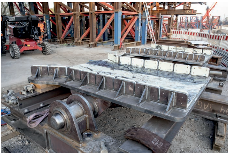
Bild 3: Eines der Wippenlager vor der Montage
