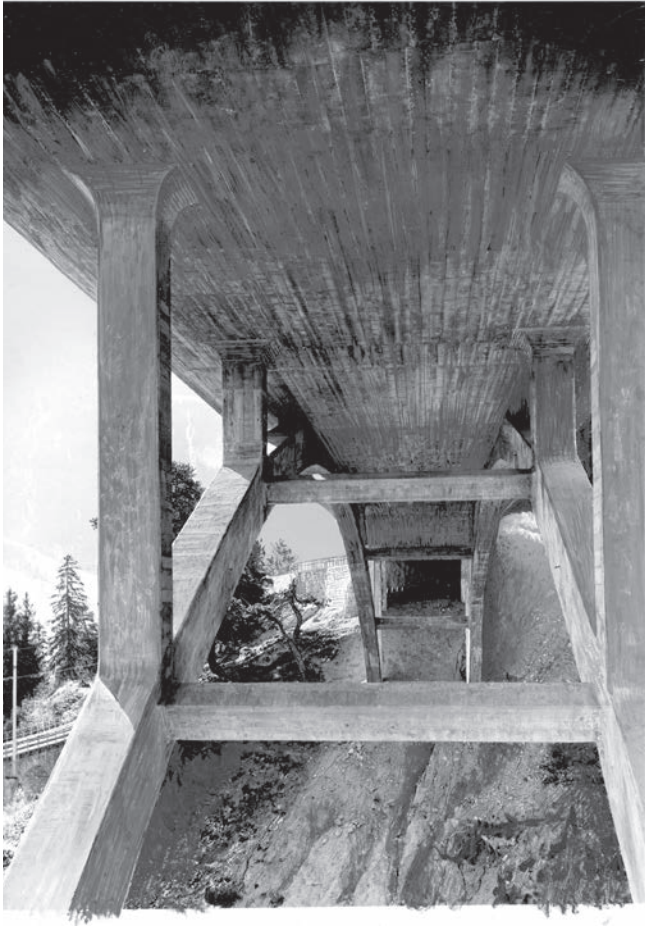
Bild 16: Laxgrabenbrücke in Lax (Furkastraße), 1942; hier Foto der Pilzdecke für eine Publikation Büro A. Sarrasin (Archiv Ph. M.)
