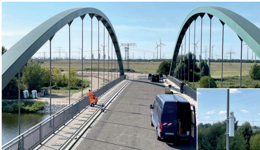
Bild 6: Montierte Schwingungstilger
