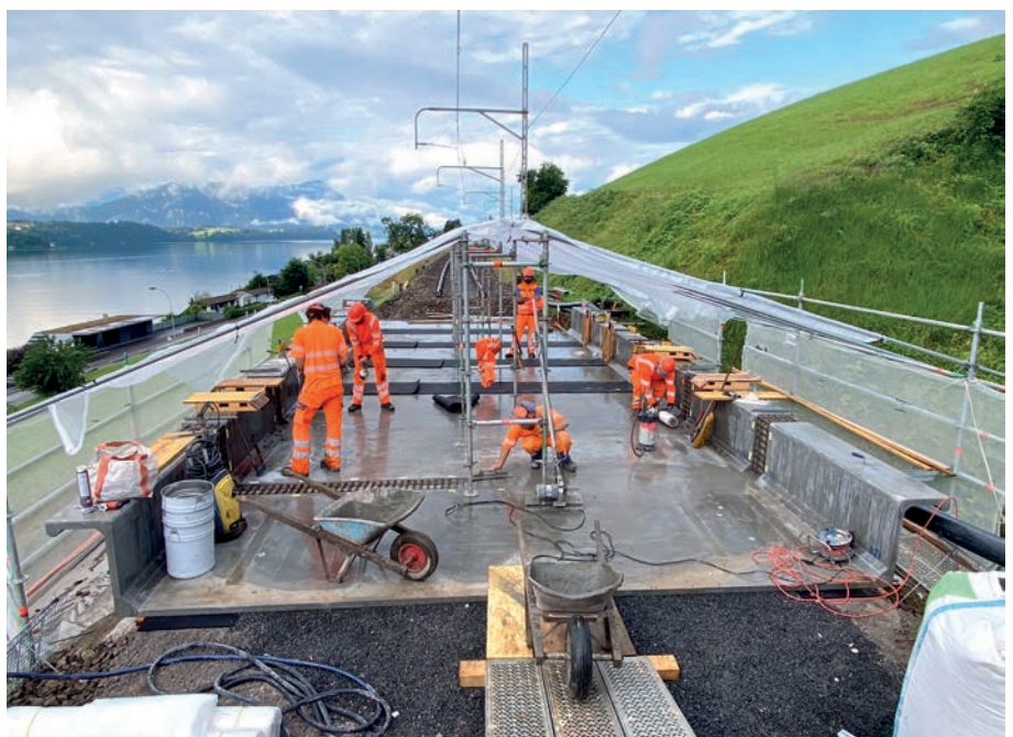
Bild 7: UHFB-Fahrbahntrog auf der Bahnstrecke von Luzern nach Immensee in der Schweiz
