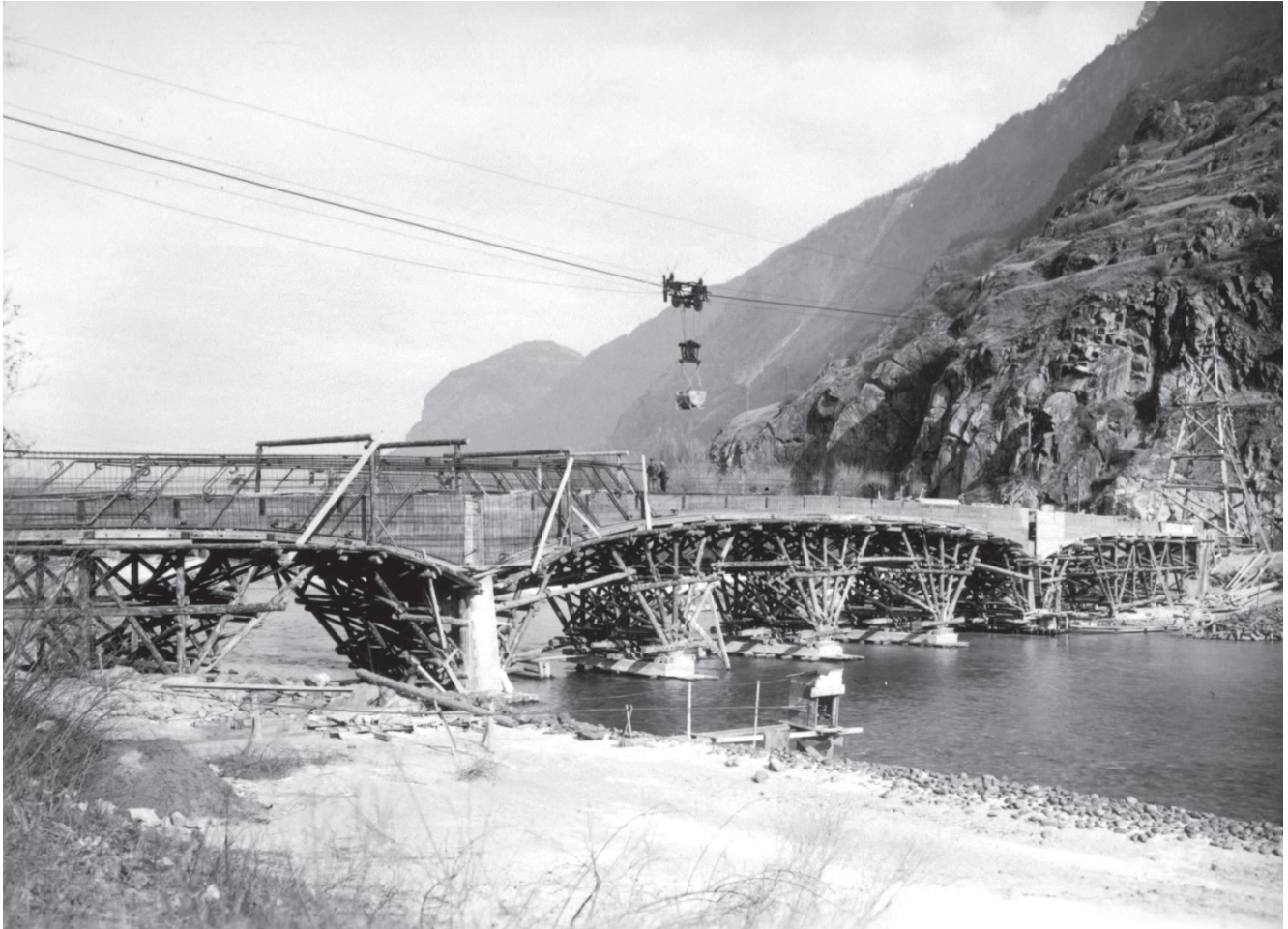
Bild 7: Bau der Dorénaz-Brücke 1932/33
