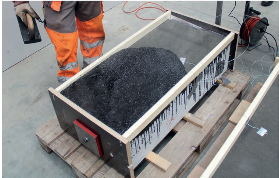
Bild 8: Einbau des Gussasphaltes
