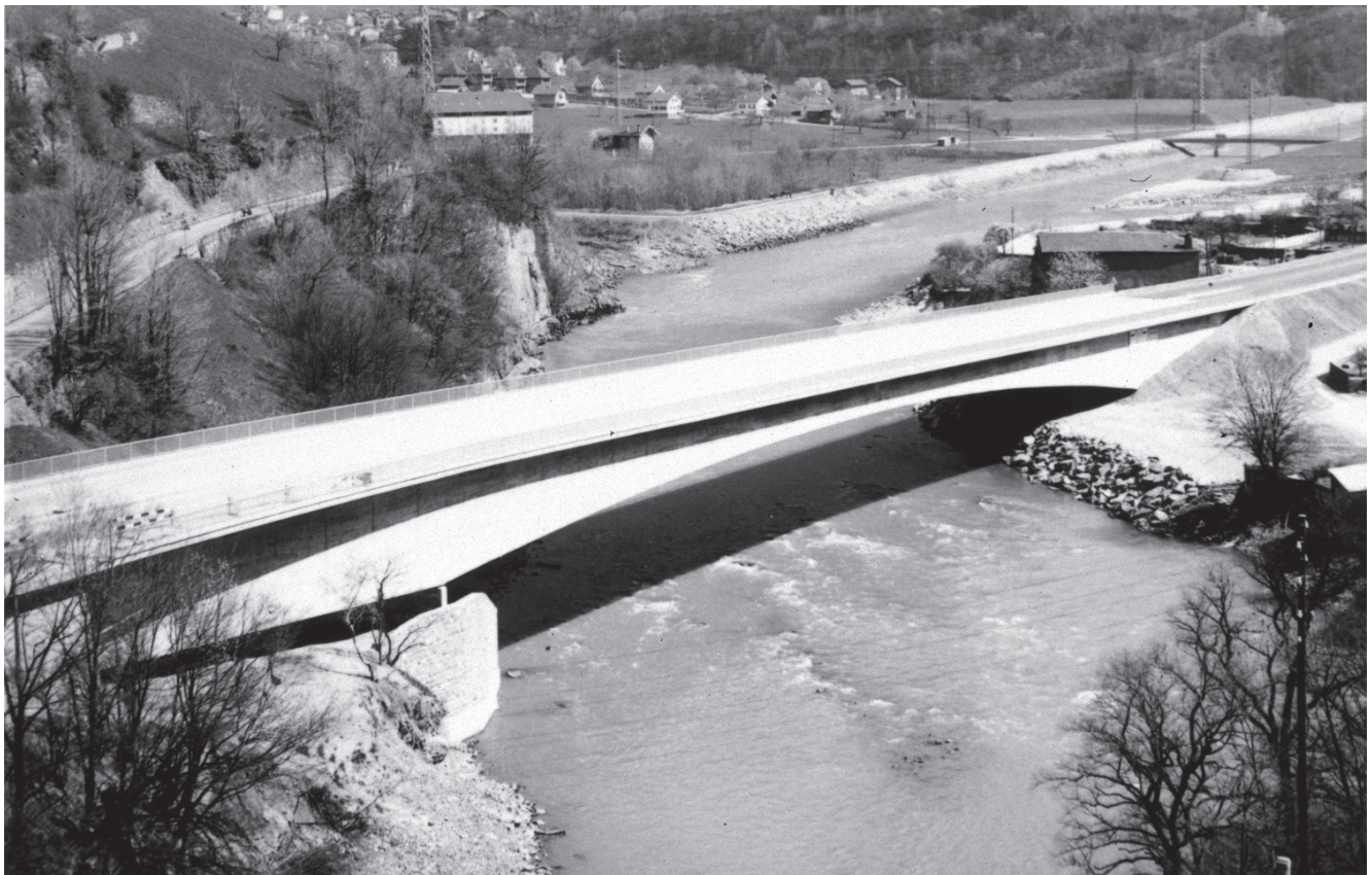
Bild 23: Fertiggestellte Rhonebrücke in Saint-Maurice vor ihrer Inbetriebnahme
