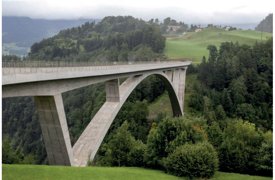
Bild 8: Taminabrücke bei Bad Ragaz
