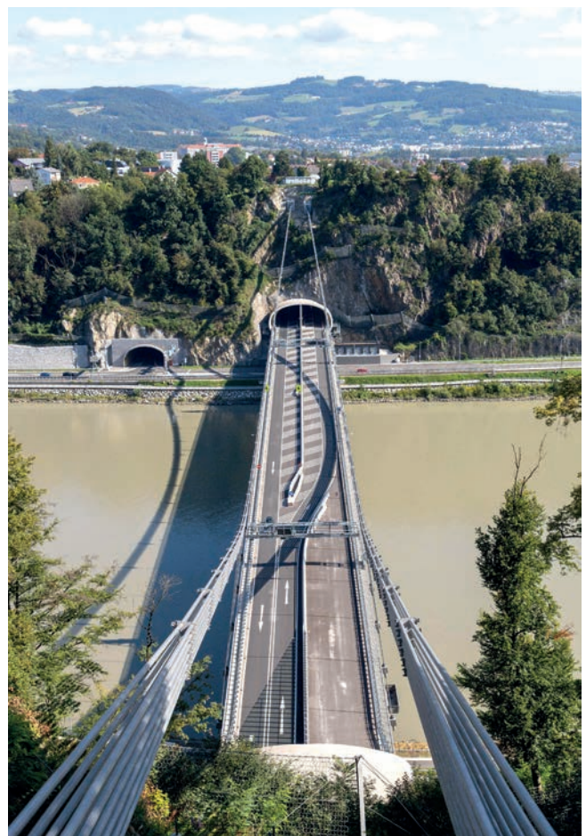
Bild 11: Donautalbrücke im Zuge der A 26 in Linz
