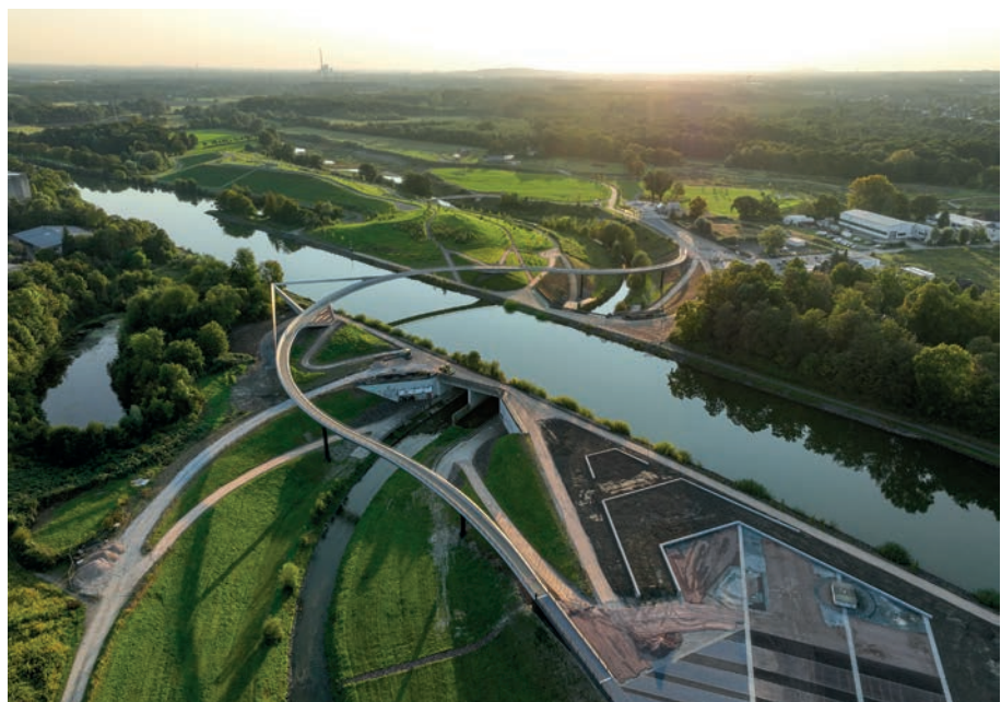
Bild 1: Der „Sprung über die Emscher“
