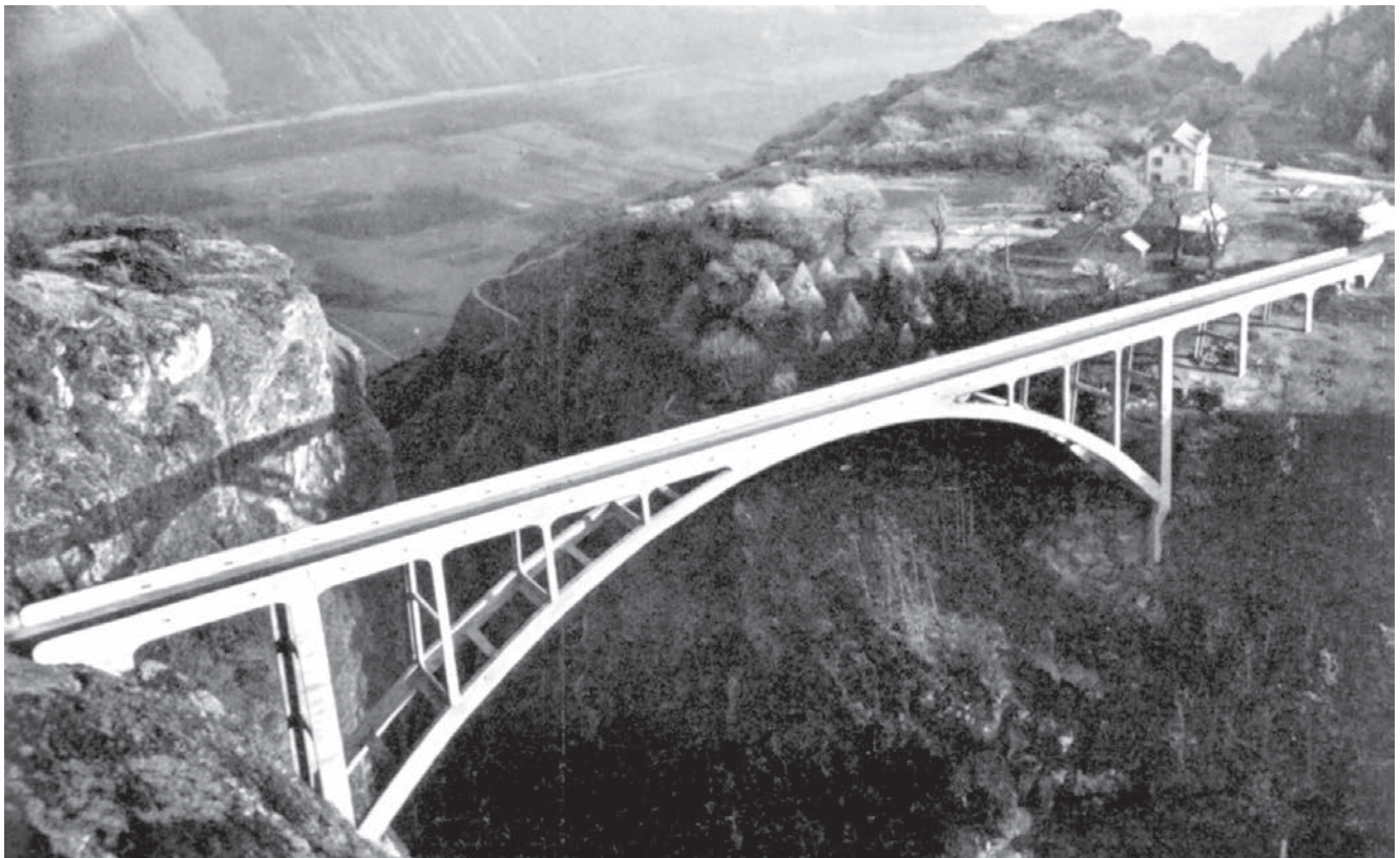
Bild 1: Ansicht der Gueuroz-Brücke 1934
