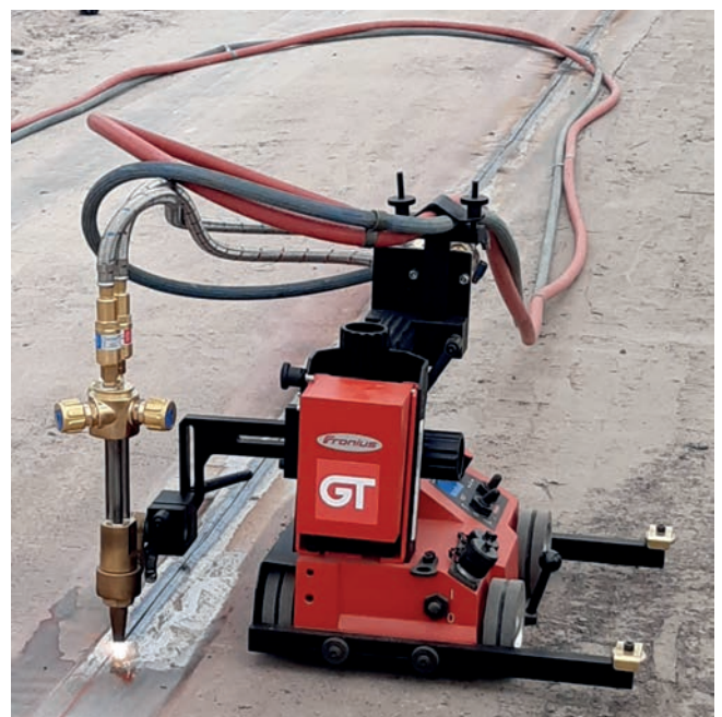
Bild 9: Einsatz eines Schweißroboters zum Auftrennen des Fahrbahnblechs
