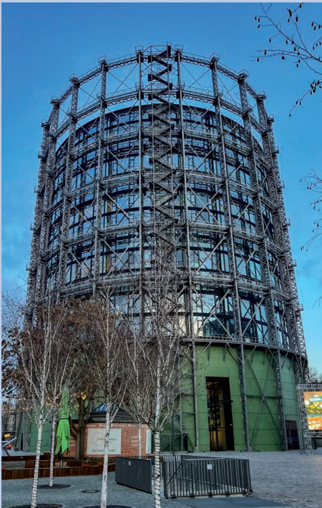
Industriedenkmal EUREF-Gasometer Berlin - Korrosionsschutz
