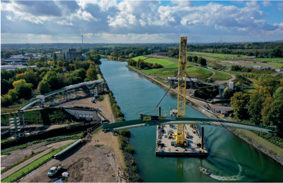
Bild 10: Montage von Segment 9 über dem Rhein-Herne-Kanal
