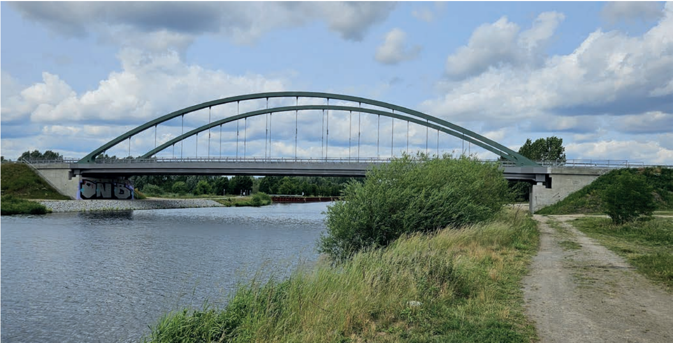
Bild 12: Kuhdammbrücke nach Verbreiterung im Juni 2025
