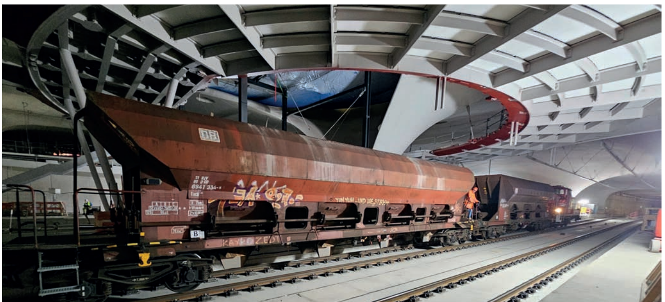
Bild 14: Belastungstest der Brückenkonstruktion mit Güterwaggons
