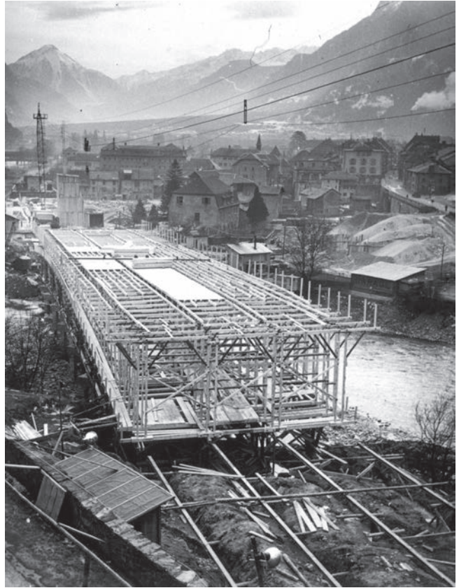
Bild 22: Baustelle der Rhonebrücke der Kantonsstraße in Saint-Maurice aus Stahlbeton mit Vorspannkabeln, 1956/57 Büro A. Sarrasin (Archiv Ph. M.)
