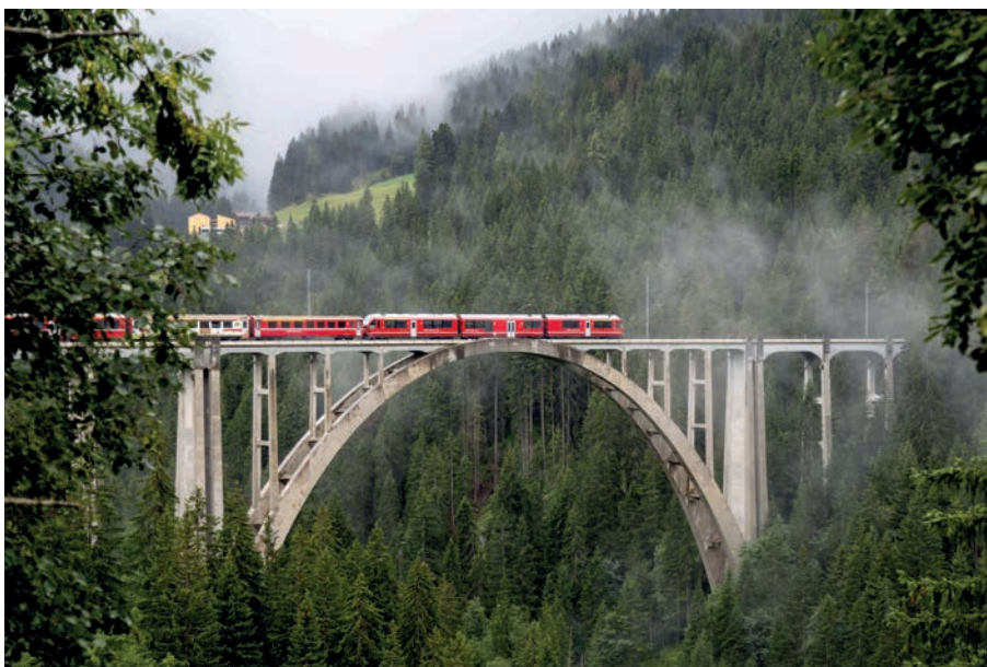
Bild 9: Langwieser Viadukt und Rhätische Bahn
