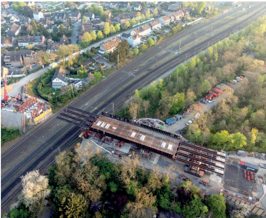
Bild 1: Gesamtansicht des Überbaus zu Beginn des horizontalen Verschubs inklusive Vorbau- und Nachlaufschubel; die Bati-Türme sind bereits mit einer Rückverankerung gegen horizontale Lasten ausgesteift Foto: Teupe Gruppe
