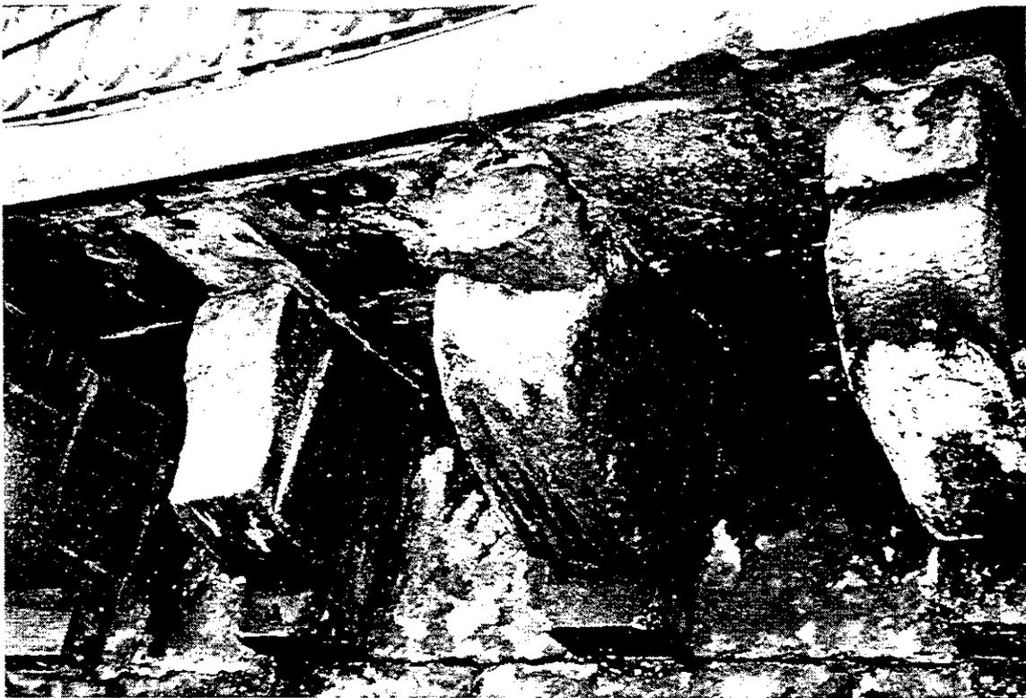
Bild 7 Verwitterte und zerstörte Konsolsteine
