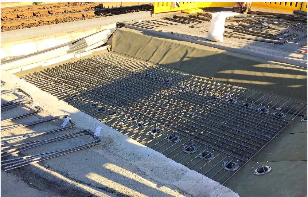
Bild 6: Einbau ‚Verankerungsblock‘ mit Tellerankern und unterer Bewehrungslage
