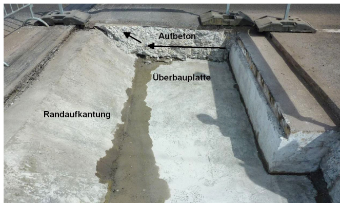
Bild 5: Überbaurandbereich nach teilweisem Ausbau des Aufbetons
