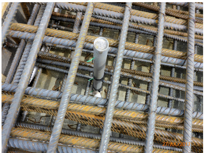
Bild 11: Sensorträger im Bewehrungskorb vor der Betonage
