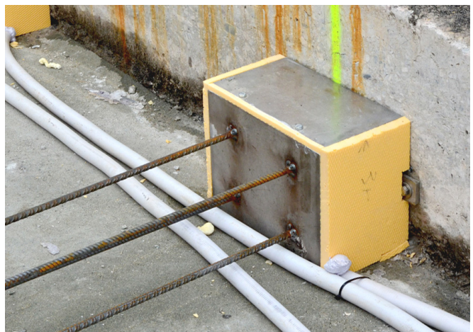
Bild 9: Gekapselte Kraftsensoren vor dem Bewehren
