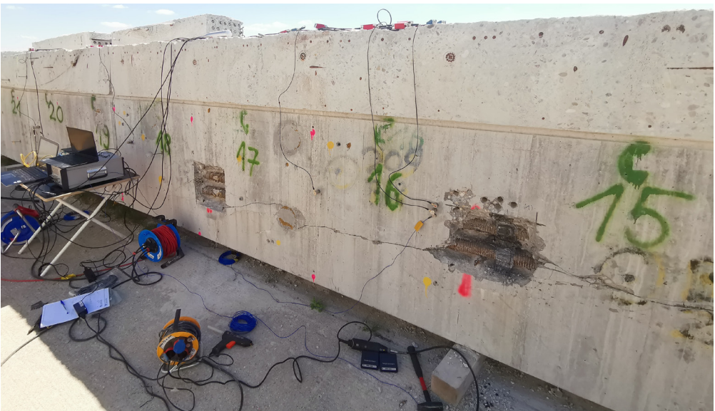
Bild 3: Trägerelement 1, Längsrisss im Bereich der Spannglieder
