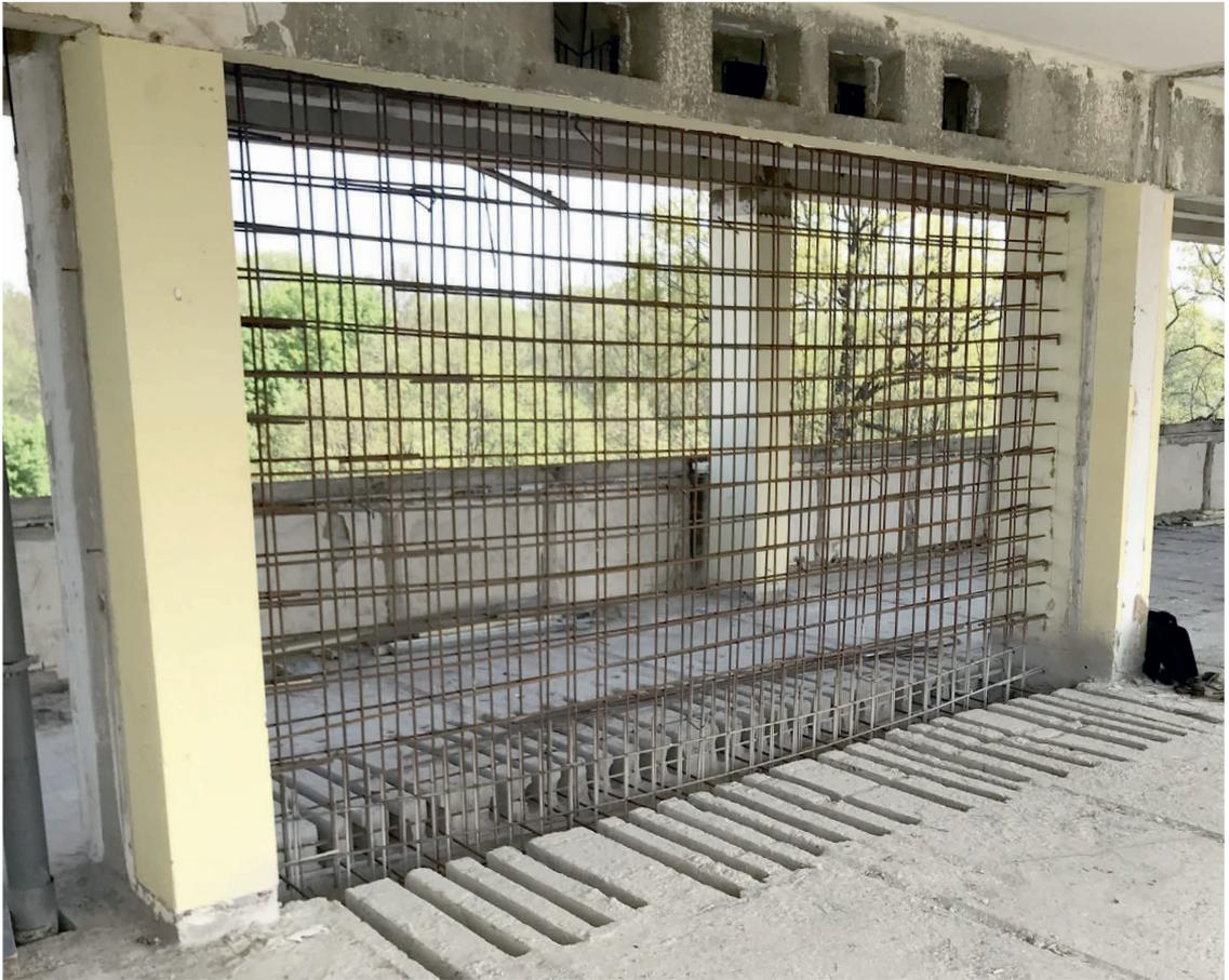
**Bild 3:** Unplanmäßig ausgeführter Bewehrungsanschluss
