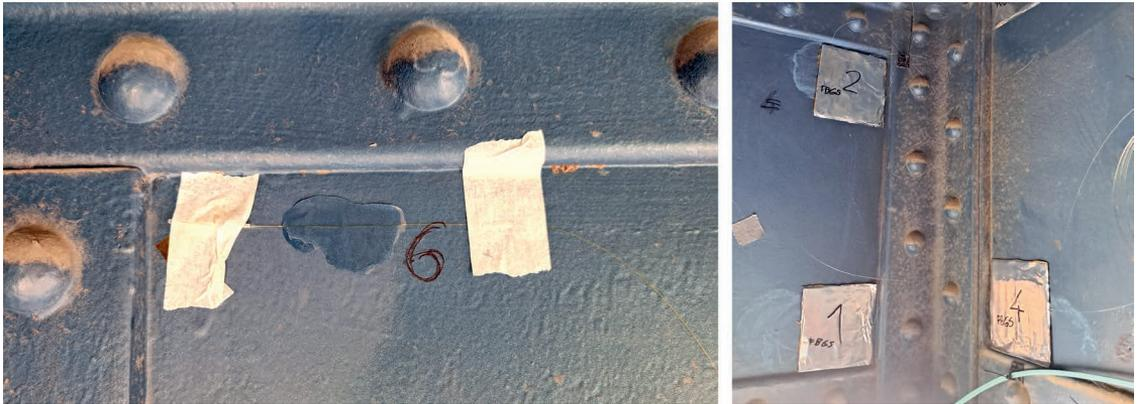
**Bild 5:** Sensorinstallation an der EÜ ESB; links optische Faser mit temporärer Fixierung am Rand und ausgehärteter Klebung in der Mitte; rechts drei abgedeckte Sensorpositionen am Übergang zwischen Haupt- und Querträger
