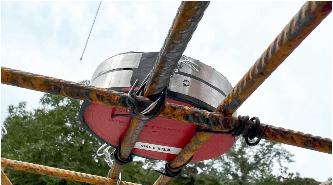
**Bild 2:** Befestigung der Feuchtesensoren bei einem Neubauprojekt mittels Rödeldrähten direkt an der Bewehrung
