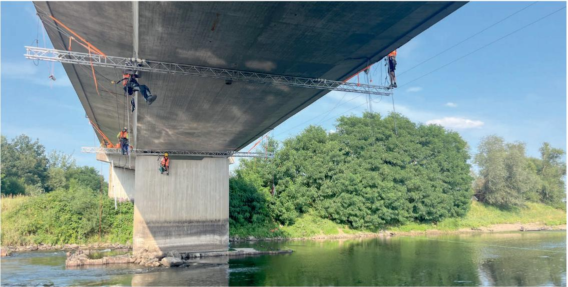
Bild 14: Industriekletterer bei der Sensorinstallation
