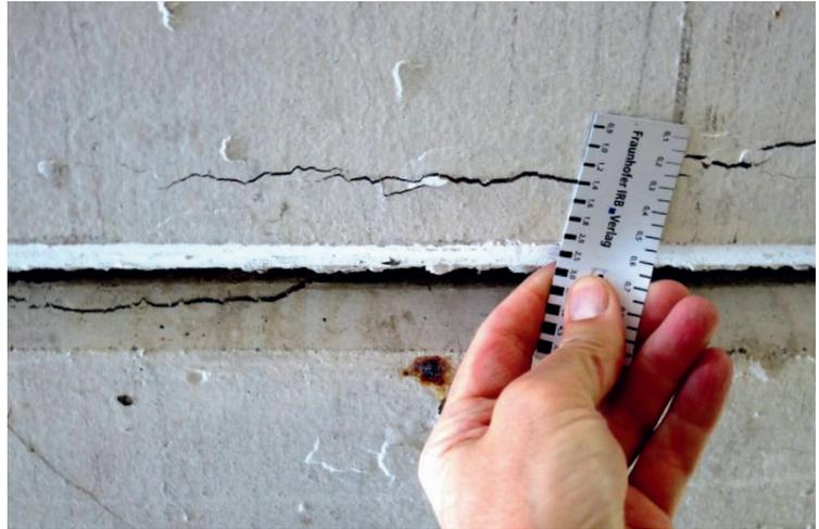
Bild 4: Rissbildung und Rostfahne an einer Bauwerksfuge
