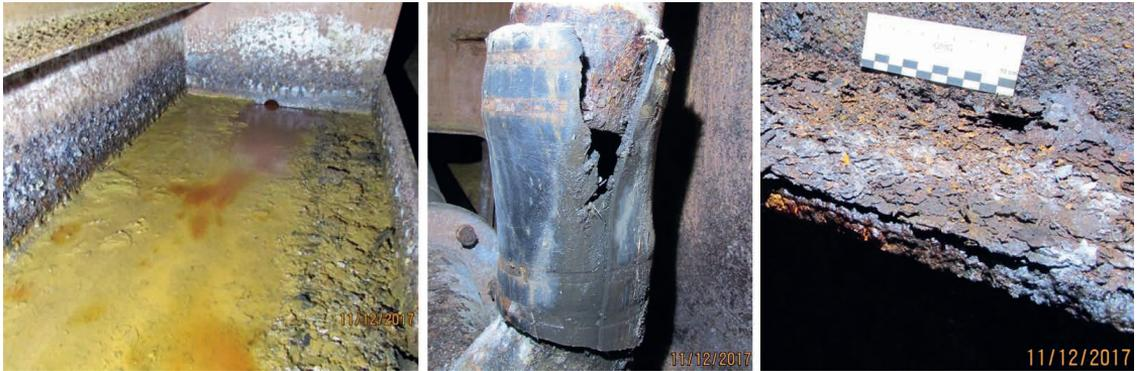
Bild 4: Korrosionsschäden infolge defekter Innenentwässerung im Hohlkasten
