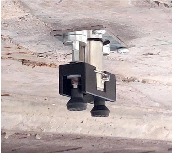
**Bild 3:** Schallemissionssensor VS30-SIC-0dB an der Bauwerksunterseite
