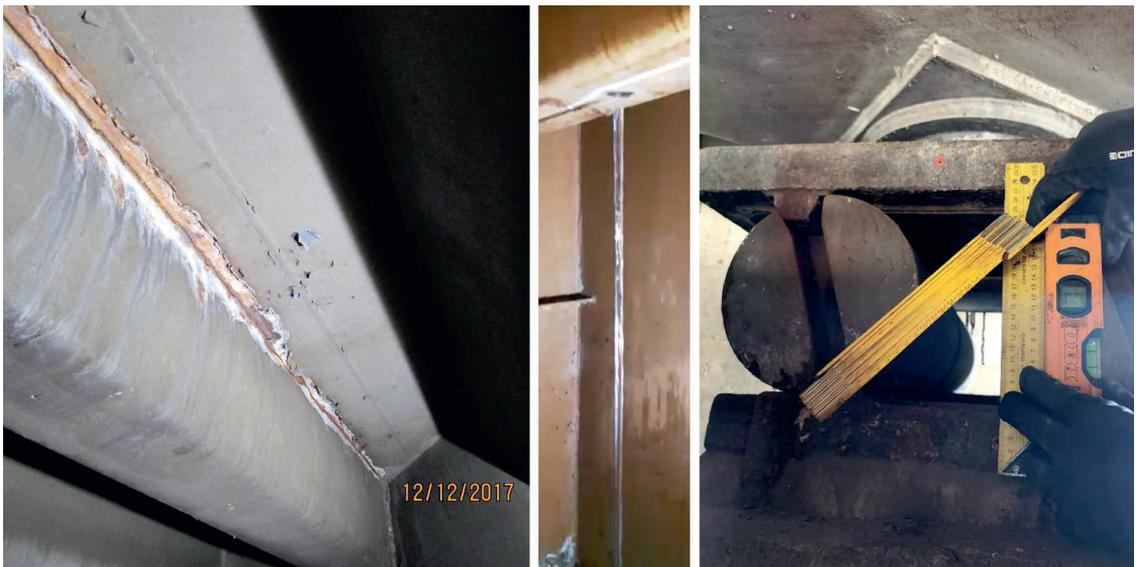
Bild 5: Schweißnaht an der Trapezhohlsteife (links), Wasser in der Trapezhohlsteife (Mitte), Lagerverkipfung (rechts)
