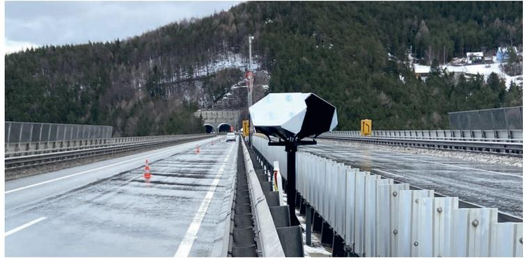
Bild 4: Cornerreflektor auf einer Brücke zur Verbesserung der Radarsatellitendaten
