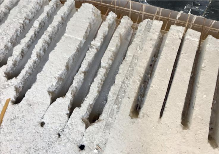
**Bild 4:** Herstellung der Öffnungen mittels Stemmverfahren (links) und mit Schneidverfahren (rechts)
