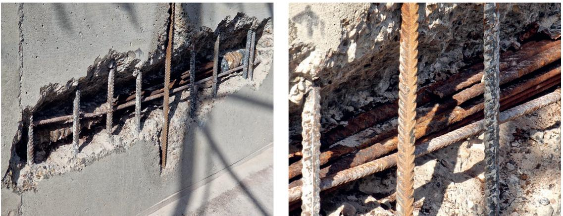
Bild 6: Unverpresste Hüllrohre und korrosionsbedingte Drahtbrüche an Längsspanngliedern einer Autobahnbrücke
