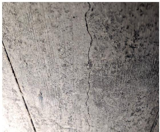
**Bild 9:** Typischer Längsriß an der Bauwerksunterseite, ausgeprägte Verteilung insbesondere an Zug a
