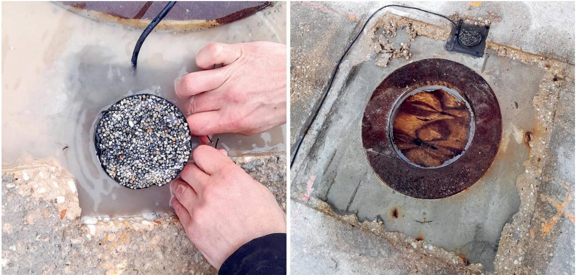
Bild 10: Installation eines Feuchtesensors an der Bewehrung
