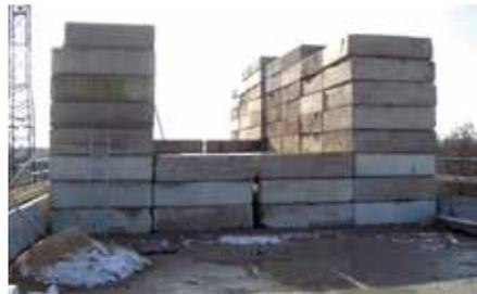
Bild 7: Vorbelastung mittels Betonplatten an der AA 32, [2]
