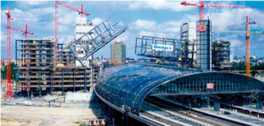
Bild 1: Hauptbahnhof Berlin; Zustand während des Einbaus der Bügelbauten 2004
