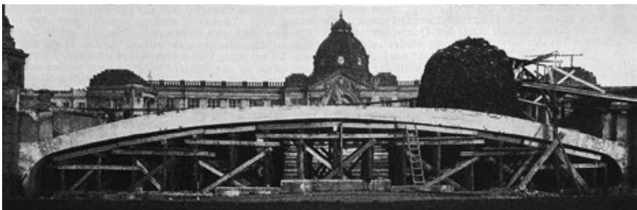
Bild 4: Ansicht und Probelastung an der Düsseldorfer Ausstellungsbrücke Foto: aus [39]
