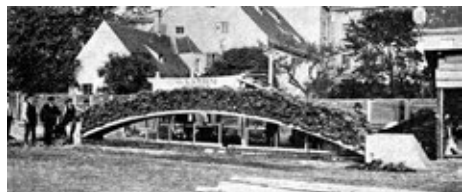
Bild 1: Belastungsprobe eines Monierbogens durch Bauschinger, München, 1887
