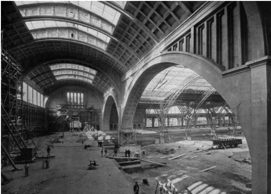
Bild 5: Innenansicht der Konstruktion der Querbahnsteighalle des Hauptbahnhofes Leipzig Foto: aus [41]
