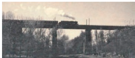
Bild 8: Bauwerk von 1936 mit Vollwandträgern unter Betrieb Foto: [6]
