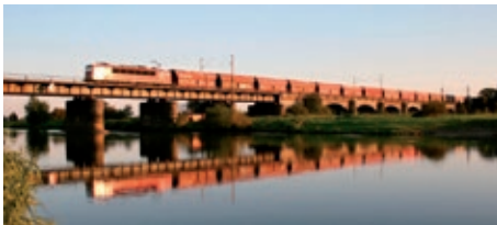
Bild 2: Ehemalige Allerbrücke vor dem Ersatzneubau Foto: Gustav Richard
