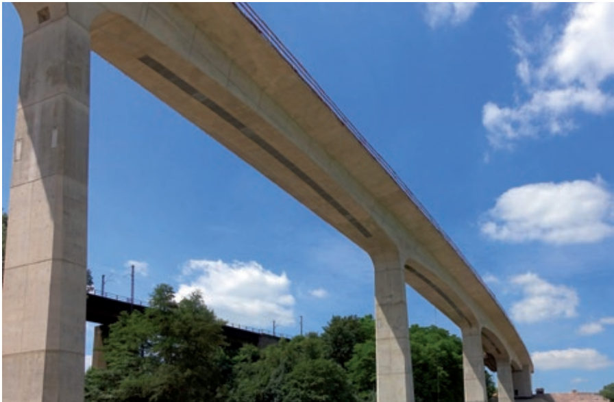
Bild 9: Neubau im Bauzustand mit alter Brücke von 1936 im Hintergrund Foto: Max Käding
