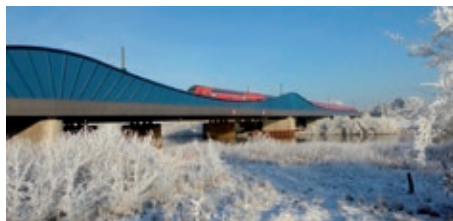
Bild 3: Allerbrücke nach Fertigstellung des Ersatzneubaus in paralleler Lage Foto: Erich Schwinge
