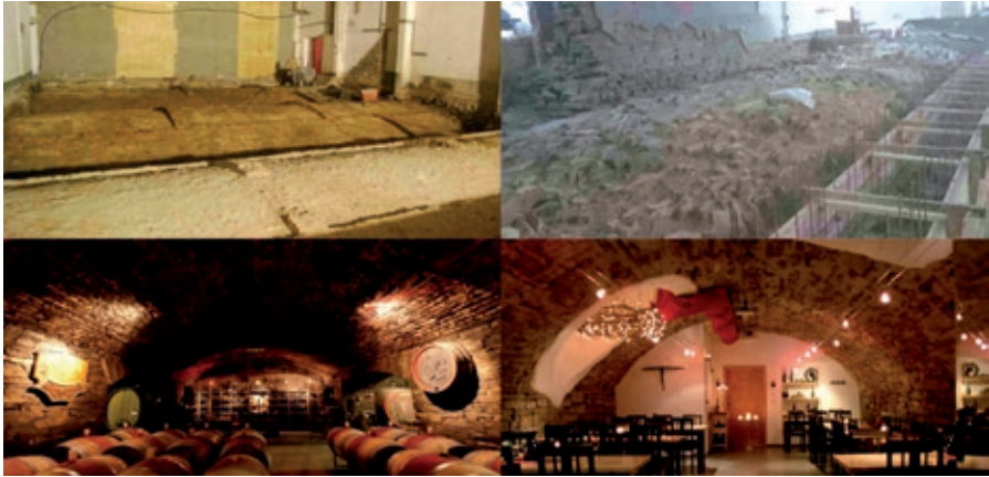
Bild 1: Weinkeller; links: „neuezeitlicher“ Weinkeller, Gewölberücken (oben) und Gewölbeleitung (unten); rechts: historischer Weinkeller, Gewölberücken (oben) und Gewölbeleitung (unten) Fotos: [3]
