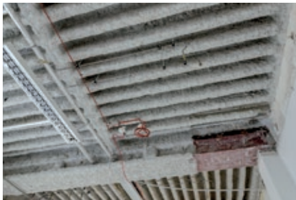
Bild 4: Historische Rippendecken mit Wechsel in der Spannrichtung Foto: Gerd Kapphahn
