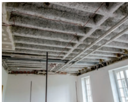
Bild 6: Rippendecke, Baujahr um 1950 Foto: Gerd Kapphahn
