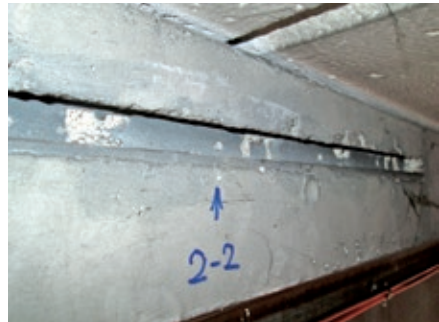
Bild 9: Typische Halfenschiene HSB 36/20 mit Schlaufen und durchgestecktem Verankerungsbügel Foto: HOCHTIEF
