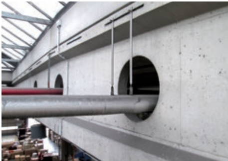
Bild 3: Ansicht der Spannbetonbinder mit Anordnung der Halfenschienen
