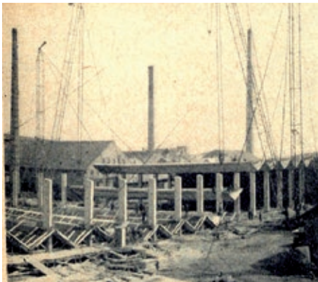
Bild 3: Montagefolge der Zickzack-Falten Foto: aus [3]
