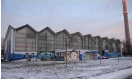
Bild 1: Ansicht der Sporthalle der HTWK Leipzig mit Zickzack-Faltwerkdach Foto: Christoph Schulze [4]
