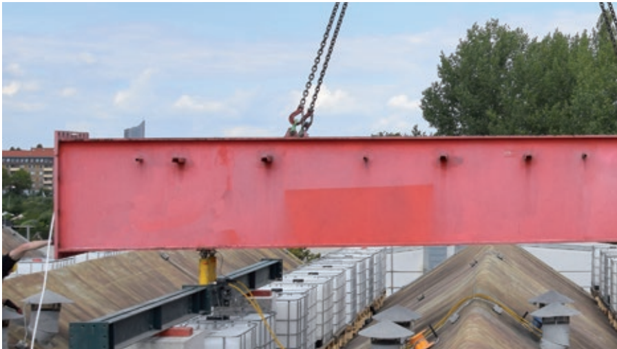
Bild 10: Justierung der Stahltraverse zur hydraulischen Lastableitung auf dem Hallendach
