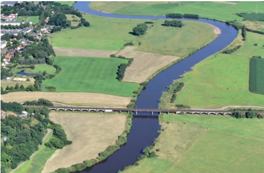
Bild 2: Zustand der Allerbrücke vor dem Ersatzneubau
