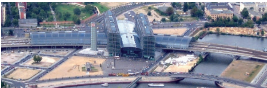
Bild 1: Blick auf den Berliner Hauptbahnhof vom Helikopter aus; gut sichtbar: die auf den äußeren Brücken aufgelagerte Bahnhofshalle
