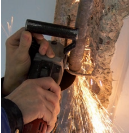
Bild 10: Entnahme eines Bewehrungsseisens eines Unterzugs über dem Erdgeschoss im Beyer-Bau
