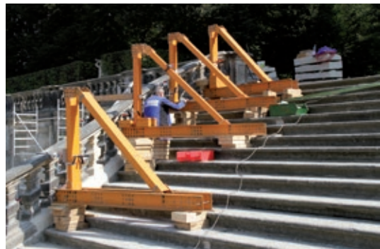
Bild 4: Aufbau der Belastungsrahmen auf der westlichen Treppe Foto: Sabine Wellner
