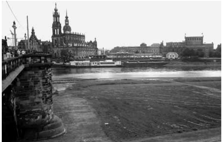
Bild 2: Vorlandabgrabungen zur Entfernung von Sedimenten gegenüber dem Pegel Dresden (Foto: Pohl 2010)
