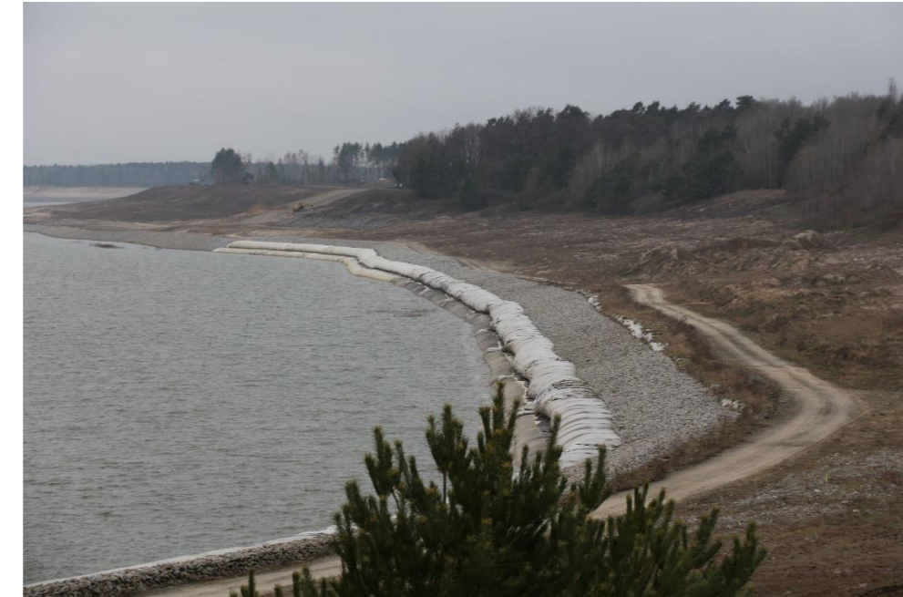
Big Packs zur Ufersicherung
