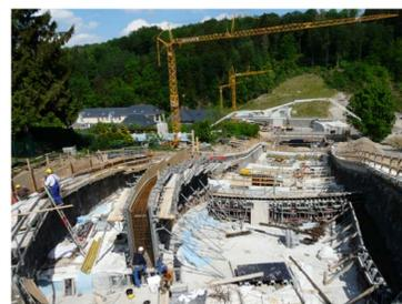
Beim Auguthochwasser 2002 war das Staubecken der Talsperre fast vollständig gefüllt. Dazu kamen enorm große Niederschlagsmengen, so dass etwa 160 m<sup>3</sup>/s über die Hochwasserentlastungsanlage abflossen. Die Kaskaden hielten dieser Belastung nicht stand.
