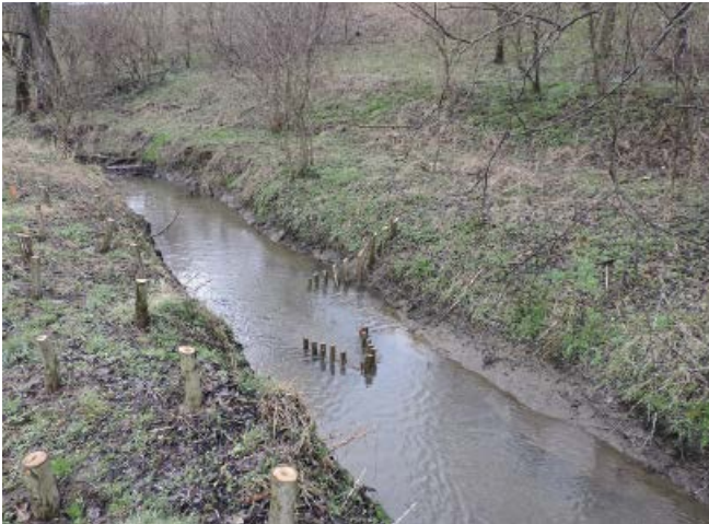
Abb. 5: Inselbuhnen und deklinante Rechenbuhnen mit Setzstangen am Mutzschener Wasser (Foto: Stowasserplan)
