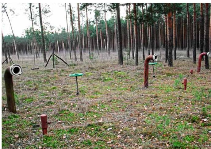
Abb. 5: Unterirdisches Löschwasserlager bei Peitz
