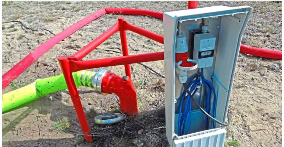
Abb. 3: Kopfstation eines Tiefbrunnens bei Jüterbog
