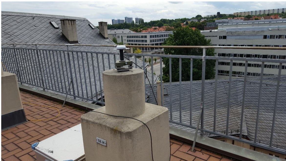
Abbildung 36: Tallysman TW3870 GNSS-Antenne, aufgebaut auf einem Pfeiler des Messdaches auf dem Beyer-Bau der TU Dresden
